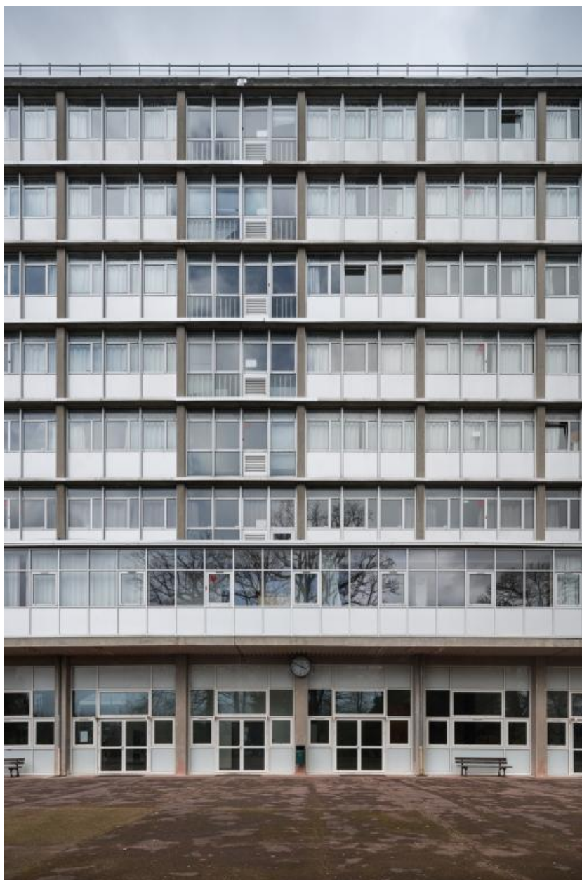
Façade sud-est du bâtiment D, Raymond Lopez architecte, 1958 : détail. On remarquera notamment les "parties ouvrantes et vitrées en éléments "de type Jean Prouvé" formant carters de réception des glaces coulissantes de la partie mobile". Les menuiseries extérieures des foyers, au rez-de-chaussée, ne sont pas d'origine.
