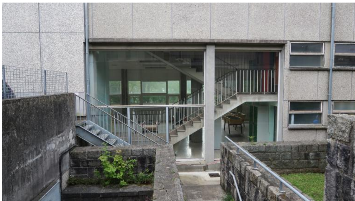
Un escalier (vu de l'extérieur) de l'internat de 7 étages (D), R. Lopez Architecte, 1958. Il s'agissait de l'escalier d'accès au restaurant scolaire (avant la construction d'un nouveau service de restauration).
