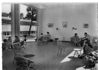
Un foyer de l'internat (bâtiment D), et ses menuiseries d'origine : de très grandes fenêtres à guillotine. A l'arrière-plan, l'externat (bâtiment C) construit en 1958 (Raymond Lopez, architecte) Phot. E. Le Grand IVR53_20182905639NUC
