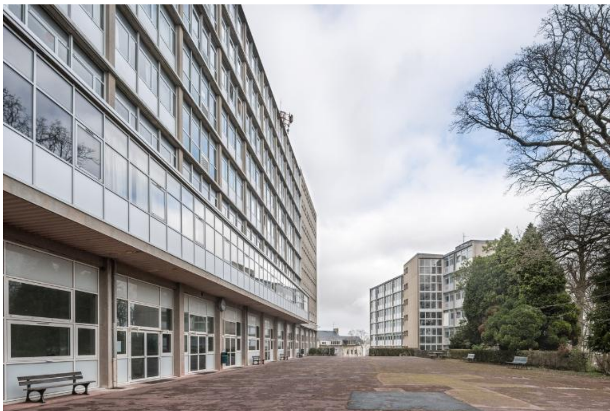
Les deux internats (à gauche, bâtiment D, à droite, bâtiment B, R. Lopez, architecte, 1958). La passerelle aérienne qui les reliait a été démolie.
