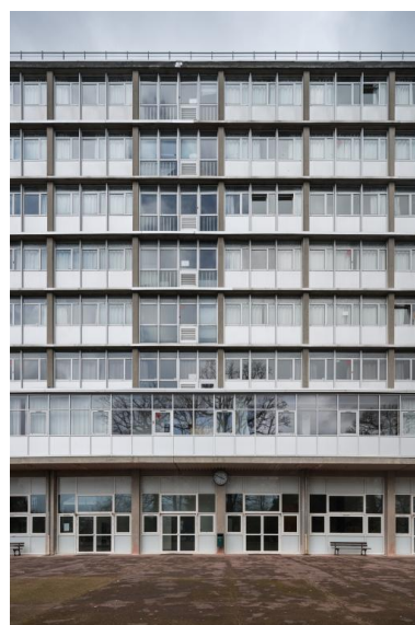
Façade sud-est du bâtiment D, Raymond Lopez architecte, 1958 : détail. On remarquera notamment les "parties ouvrantes et vitrées en éléments "de type Jean Prouvé" formant carters de réception des glaces coulissantes de la partie mobile". Les menuiseries
