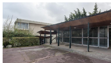
Galerie de liaison entre le bâtiment D (internat) et le bâtiment C, externat. Elle avait été réclamée par le Conseil général des bâtiments de France. Phot. Delia Gaulin-Crespel IVR53_20192900239NUCA
