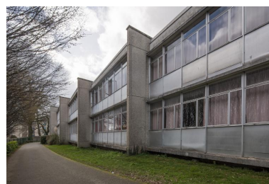
Bâtiment C, externat, Raymond Lopez architecte, 1958 : façade sud-est (vue prise du nord-est) : modules de deux niveaux de salles de classe disposés en dents de scie. Phot. Delia Gaulin-Crespel IVR53_20192900240NUCA
