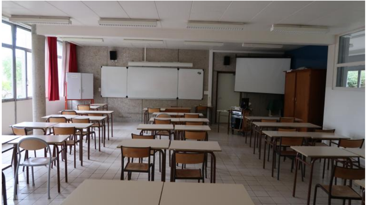
Ancienne salle d'étude, devenu salle de classe. R. Lopez architecte, 1958. Atypique pour l'époque, la structure porteuse est en retrait de la façade.
