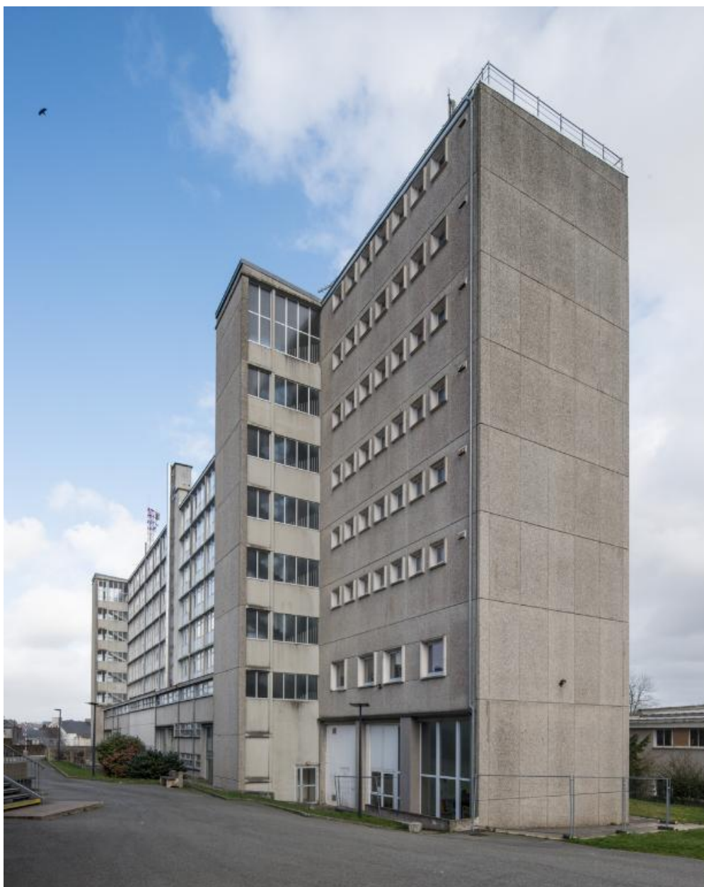
Bâtiment D, externat, façade arrière (vue prise depuis le sud-ouest). Raymond Lopez architecte, 1958.
