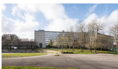
Ensemble des trois bâtiments de 1958, Raymond Lopez, architecte : vue prise du sud-est. Phot. Delia Gaulin-Crespel IVR53_20192900248NUCA
