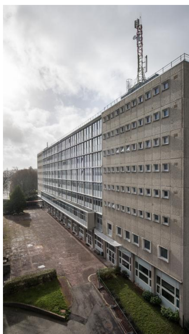
Façade sud-est du bâtiment D, grande barre d'internat de 8 niveaux. Raymond Lopez architecte, 1958. Noter l'alternance des matériaux entre les parties réservées aux
