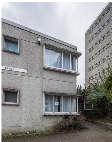
Bâtiment d'externat (à l'origine, études de l'internat), détail de l'angle nord, Raymond Lopez architecte, 1958. A droite, la grande barre d'internat. Phot. Delia Gaulin-Crespel IVR53_20192900232NUCA
