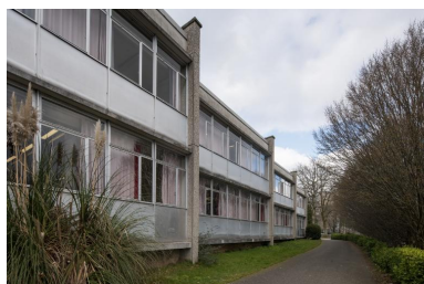
Bâtiment C, externat, Raymond Lopez architecte, 1958 : façade sud-est (vue prise du sud-ouest) : modules de deux niveaux de salles de classe disposés en dents de scie. Phot. Delia Gaulin-Crespel IVR53_20192900241NUCA
