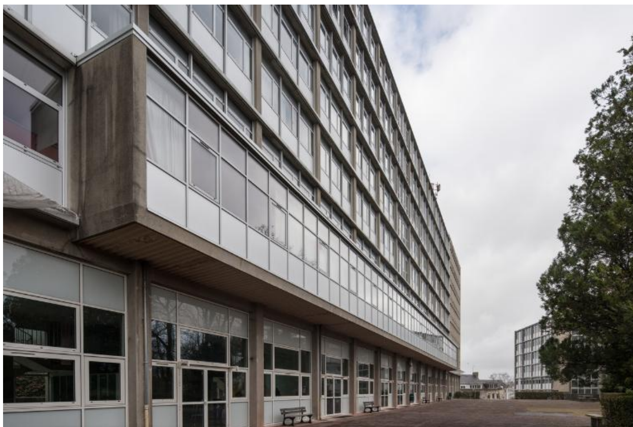
Internats (bâtiment D), R. Lopez, architecte, 1958 : détail sur l'encorbellement du 1er étage (salles de réfectoire, à l'origine).
