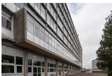
Internats (bâtiment D), R. Lopez, architecte, 1958 : détail sur l'encorbellement du 1er étage (salles de réfectoire, à l'origine). Phot. Delia Gaulin-Crespel IVR53_20192900234NUCA
