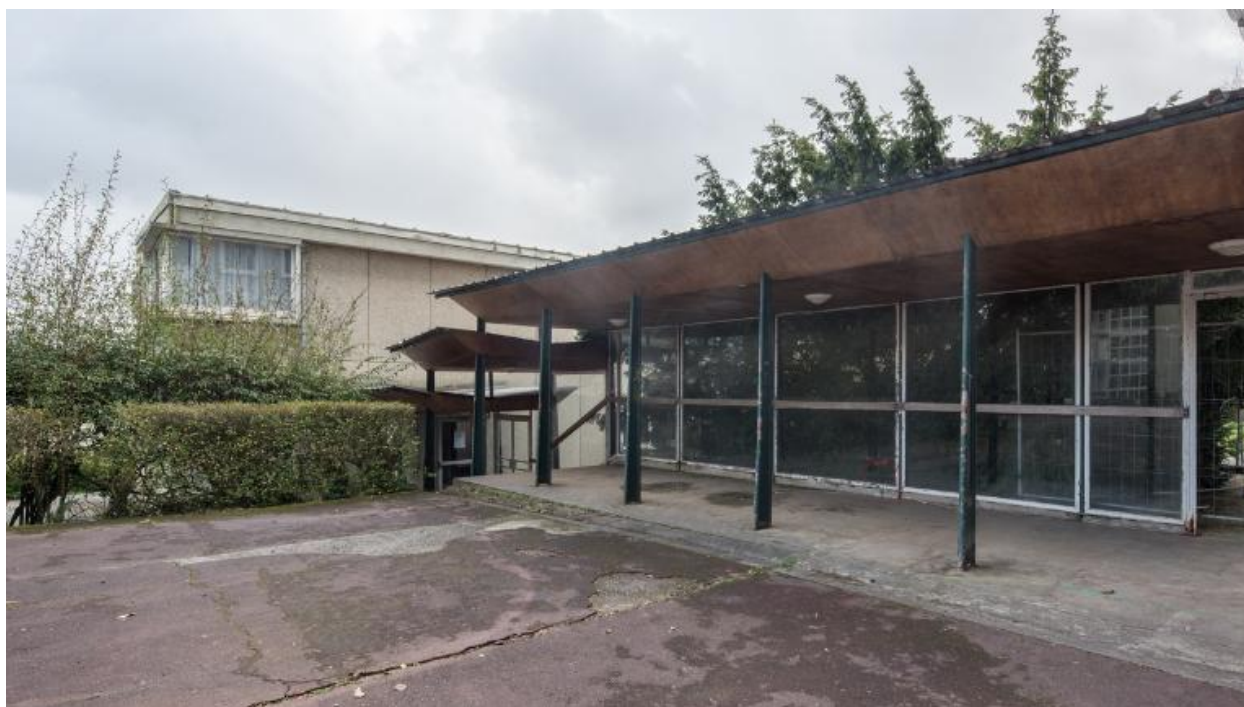
Galerie de liaison entre le bâtiment D (internat) et le bâtiment C, externat. Elle avait été réclamée par le Conseil général des bâtiments de France.
