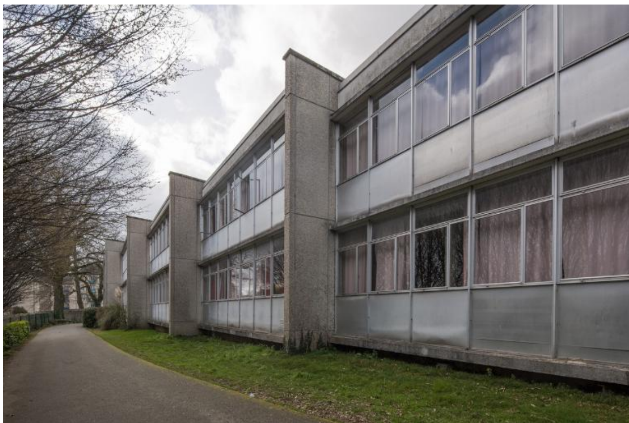
Bâtiment C, externat, Raymond Lopez architecte, 1958 : façade sud-est (vue prise du nord-est) : modules de deux niveaux de salles de classe disposés en dents de scie.
