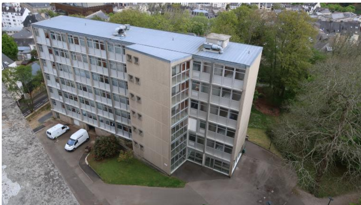
L'internat des "petites", Raymond Lopez architecte, 1958. Vue prise du toit du bâtiment D.
