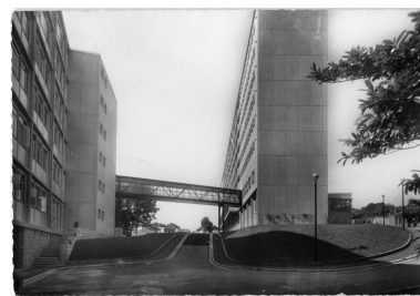
Les deux internats (bâtiments B et D), à l'origine reliés par une passerelle Phot. E. Le Grand IVR53_20182905638NUC
