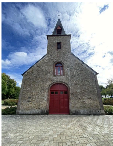
Élévation ouest Phot. Baptiste Oligo IVR53_20265610423NUCA
