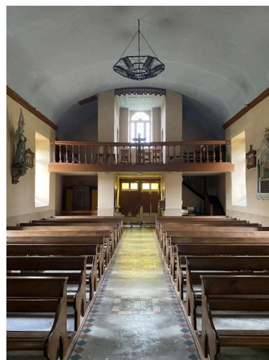
Vue générale de l'intérieur Phot. Baptiste Oligo IVR53_20265610422NUCA
