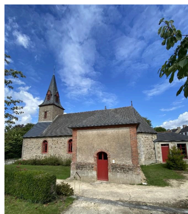
Vue sud Phot. Baptiste Oligo IVR53_20265610424NUCA
