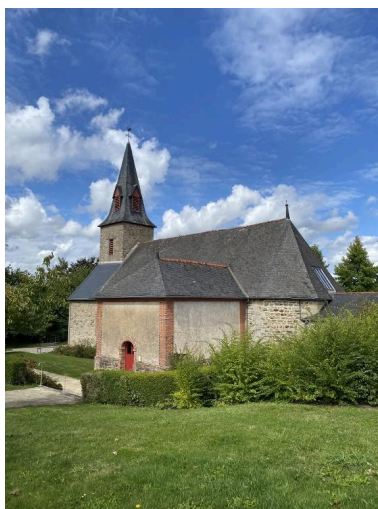
Vue sud-est Phot. Baptiste Oligo IVR53_20265610415NUCA
