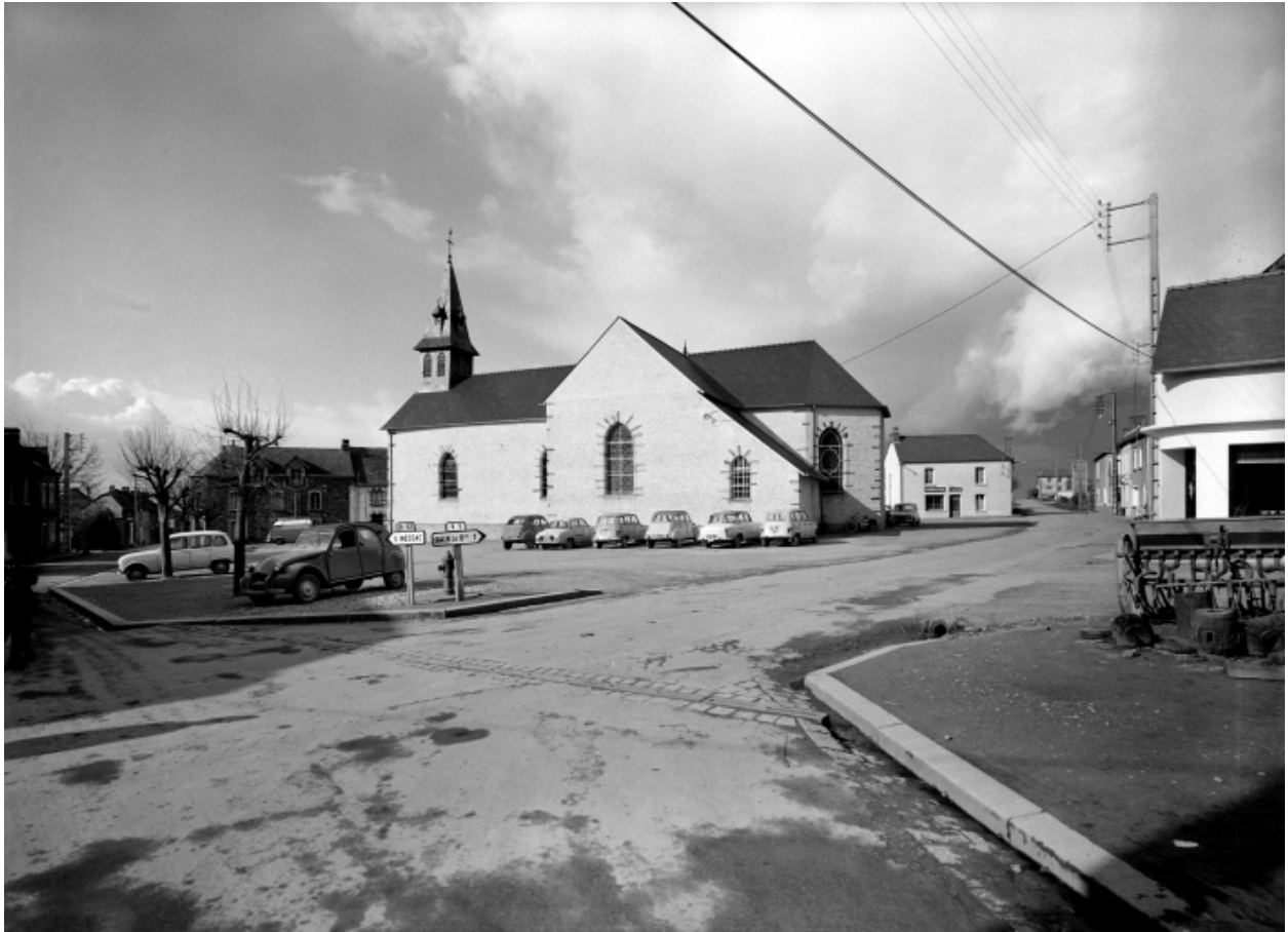
Elévation Sud-Est : vue générale
