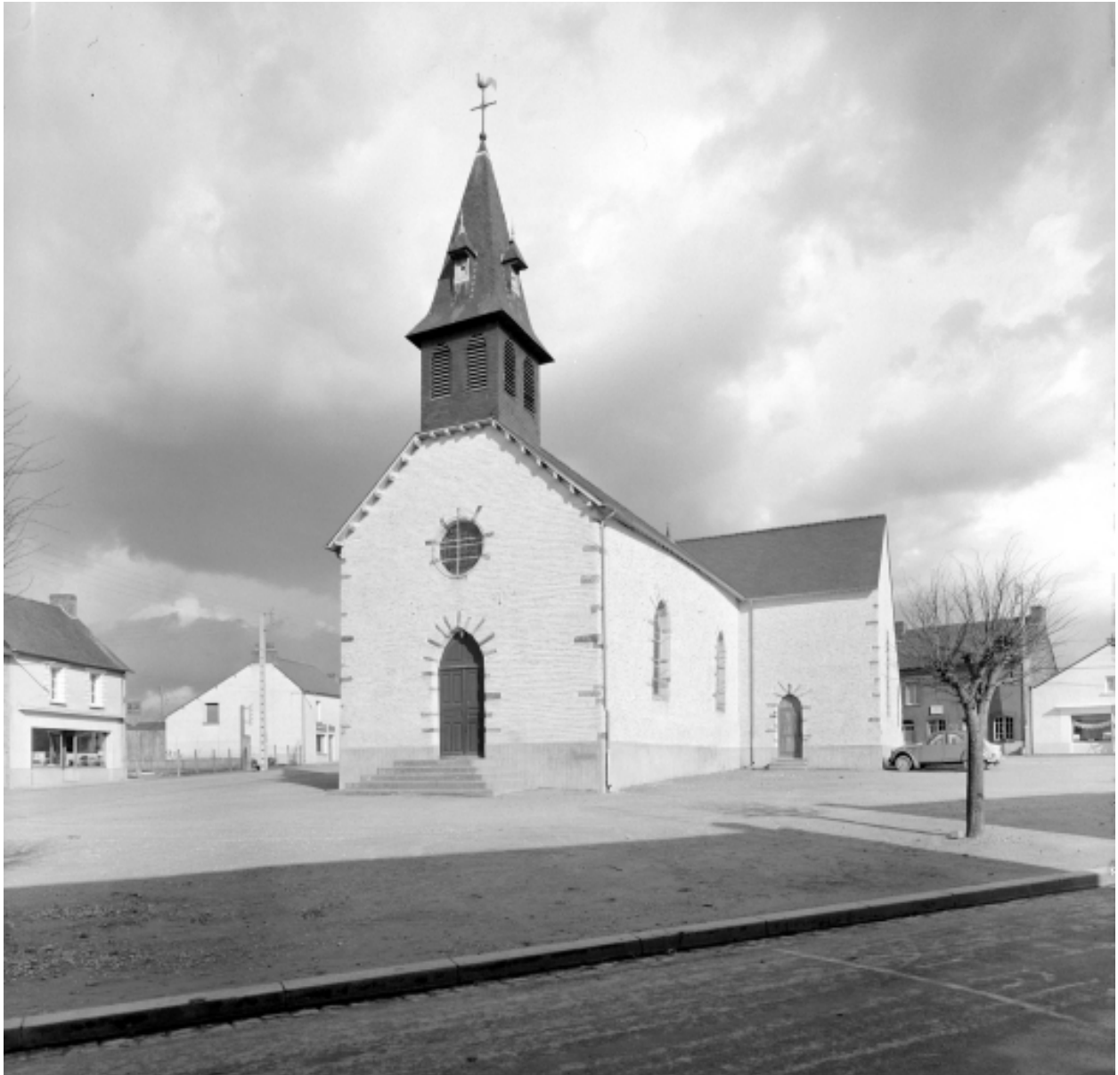
Elévation Sud-Ouest : vue générale
