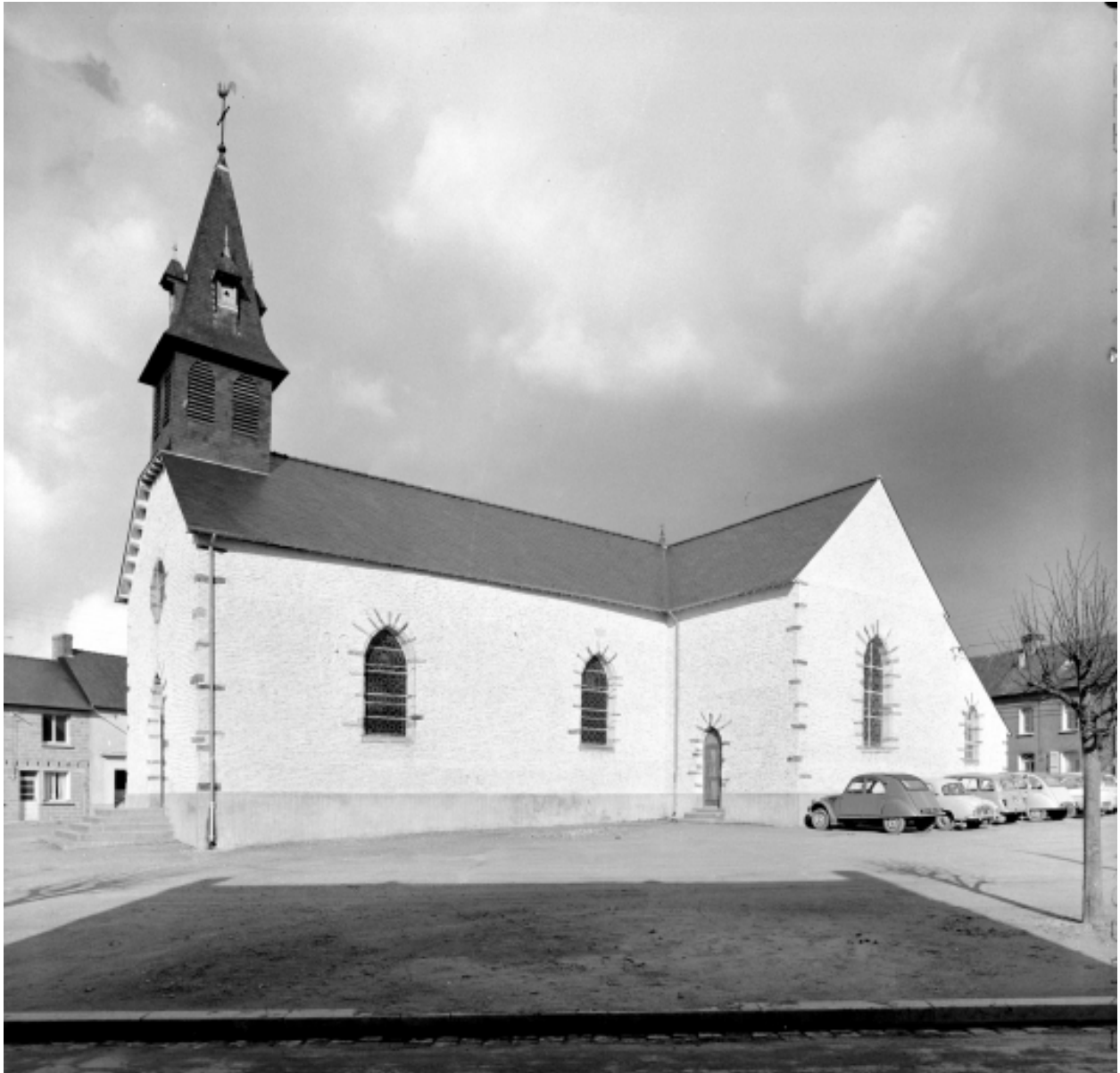
Elévation Sud : vue générale
