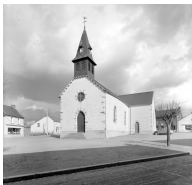
Elévation Sud-Ouest : vue générale Phot. Guy Artur, Phot. Norbert Lambart IVR53_19703500152V
