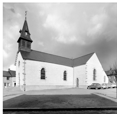
Elévation Sud : vue générale Phot. Guy Artur, Phot. Norbert Lambart IVR53_19703500153V
