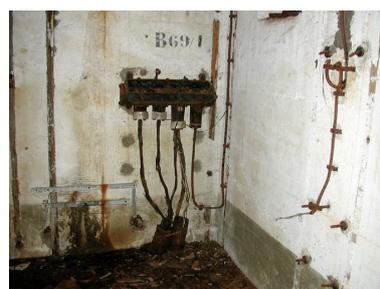
Vue de la chambre de troupe de droite : boîtier de connexion téléphonique surmonté du numéro "B 69/1" et câblage (état en 2003)
