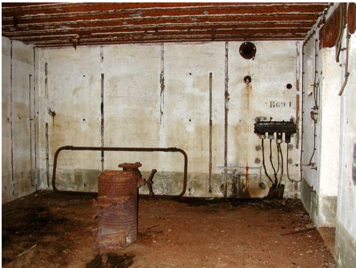
Vue de la chambre de troupe de droite : poêle de type Wt 80K, chassis tubulaire de couchette posé contre le mur, boîtier de connexion téléphonique surmonté du numéro "B 69/1" et câblage... (état en 2003)
