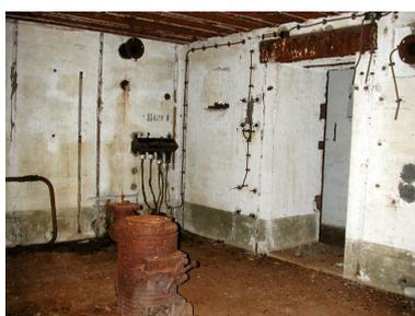
Vue de la chambre de troupe de droite : poêle de type Wt 80K, châssis tubulaire de couchette posé contre le mur, boîtier de connexion téléphonique surmonté du numéro "B 69/1" et câblage... (état en 2003)
