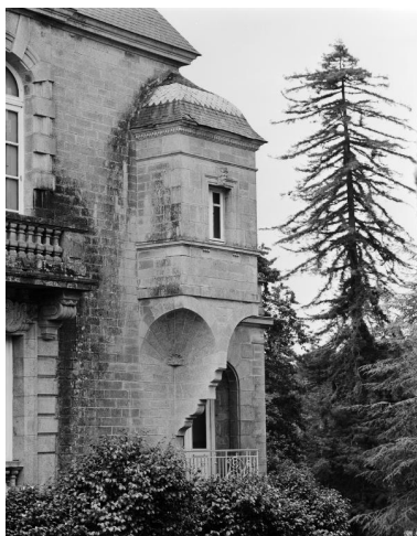
Château, logis, pavillon ouest, échauguette sur trompe. Phot. Guy Artur, Phot. Norbert Lambart IVR53_19885600844X
