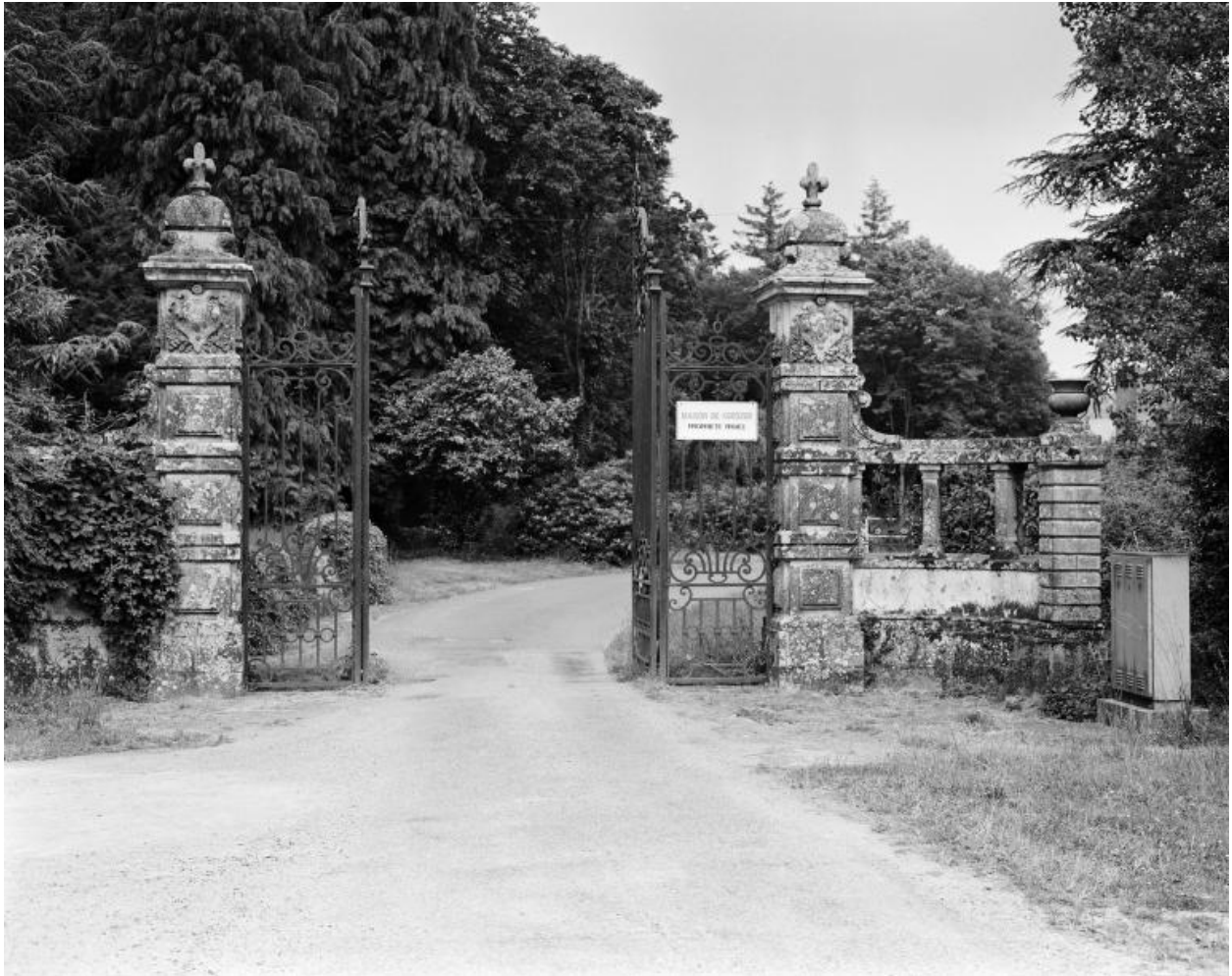
Château, portail d'entrée (ancien portail du jardin).
