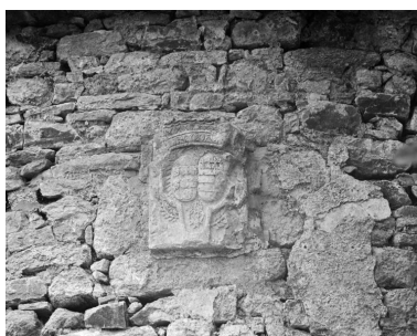
Château, colombier, détail des armoiries. Phot. Guy Artur, Phot. Norbert Lambart IVR53_19885600884X
