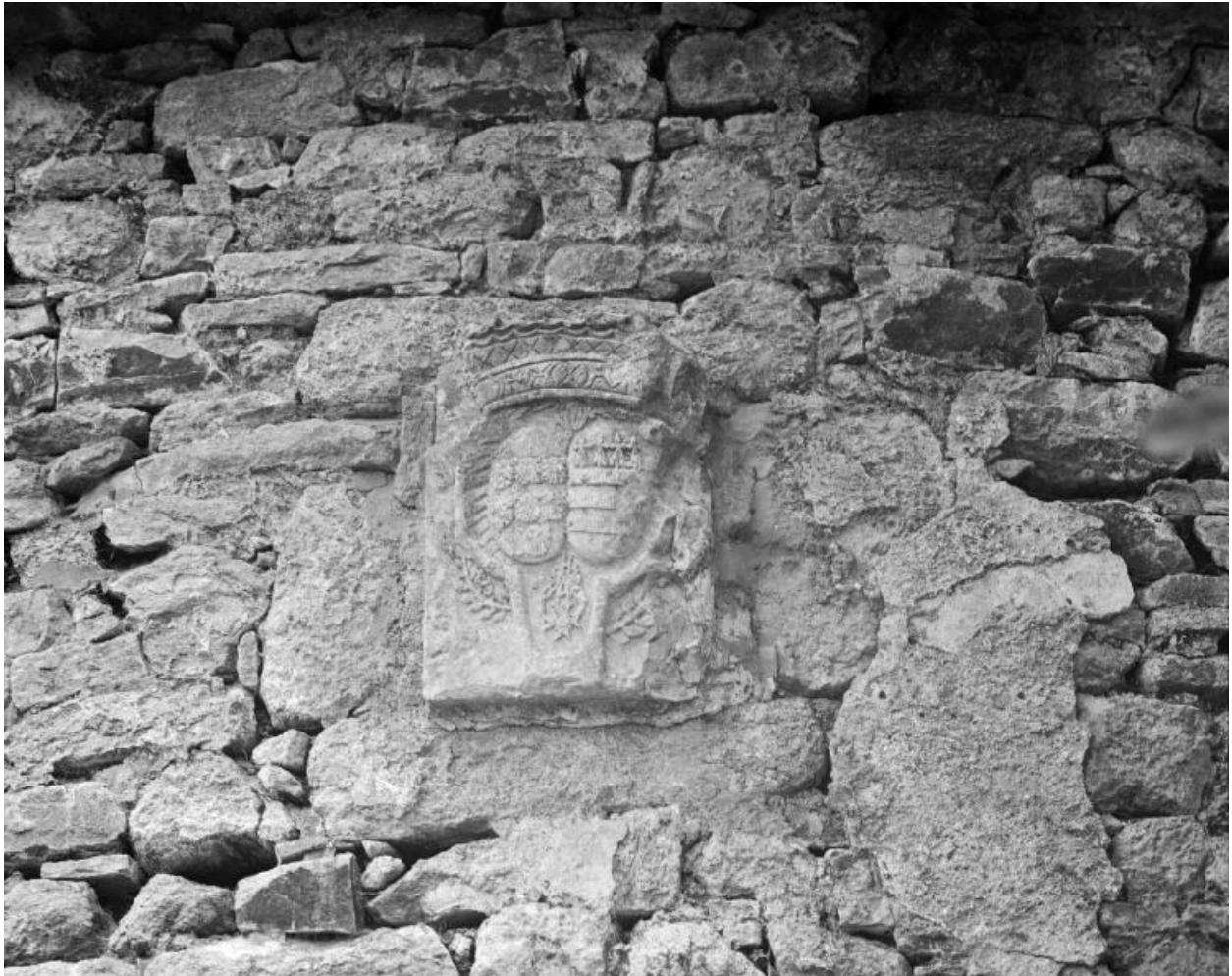
Château, colombier, détail des armoiries.
