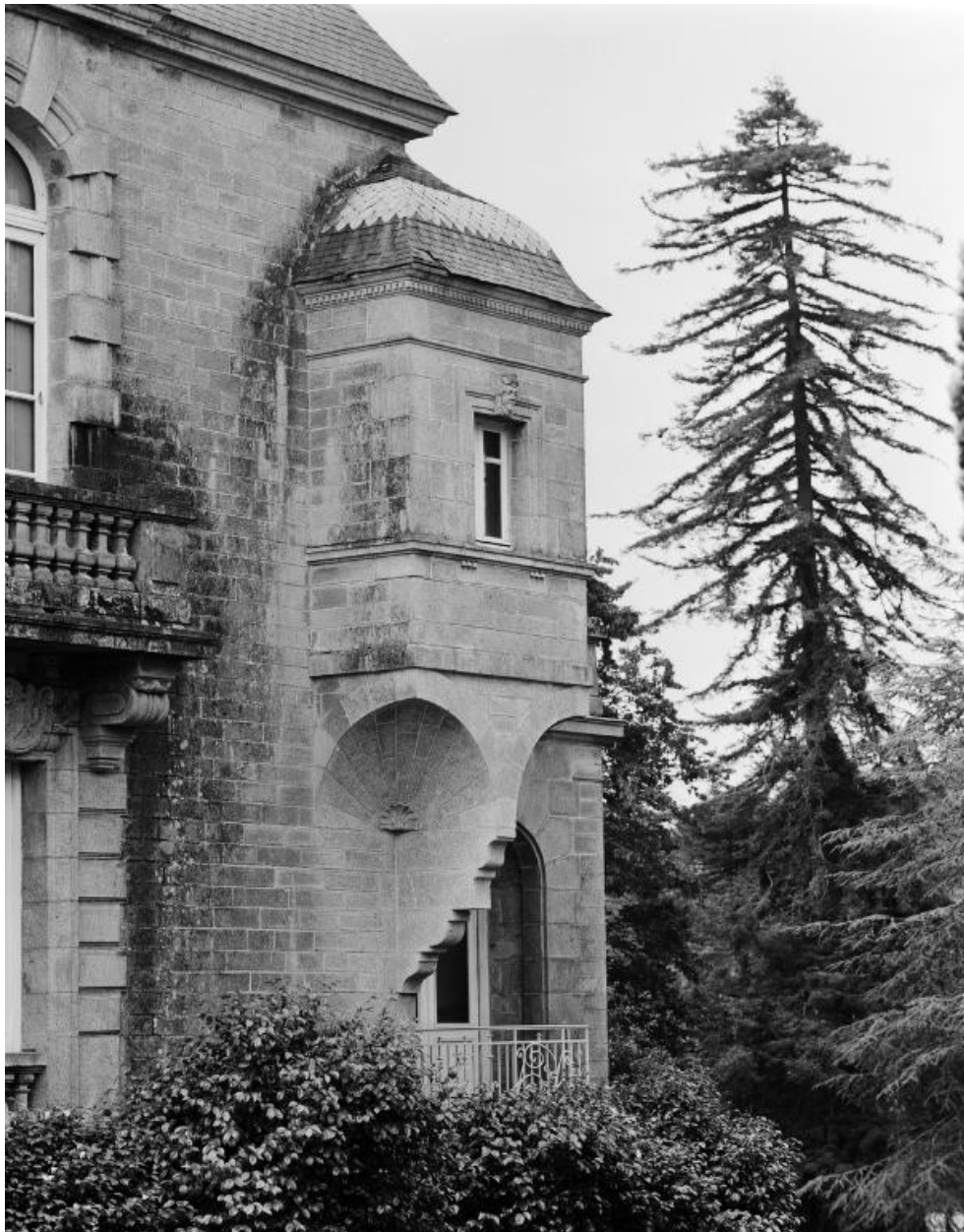
Château, logis, pavillon ouest, échauguette sur trompe.
