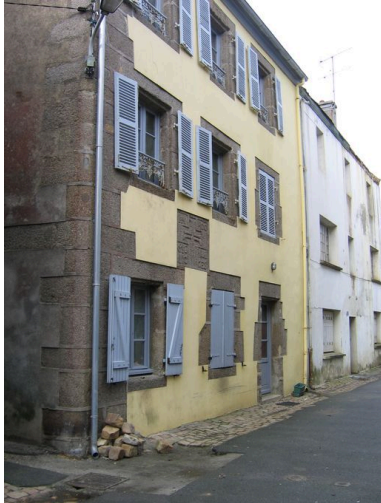
Maison n° 43 rue de Dixmude Phot. Françoise Péron IVR53_20062908316NUCA
