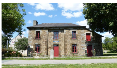
Vue sud Phot. Laurence Marquet IVR53_20243531591NUCA
