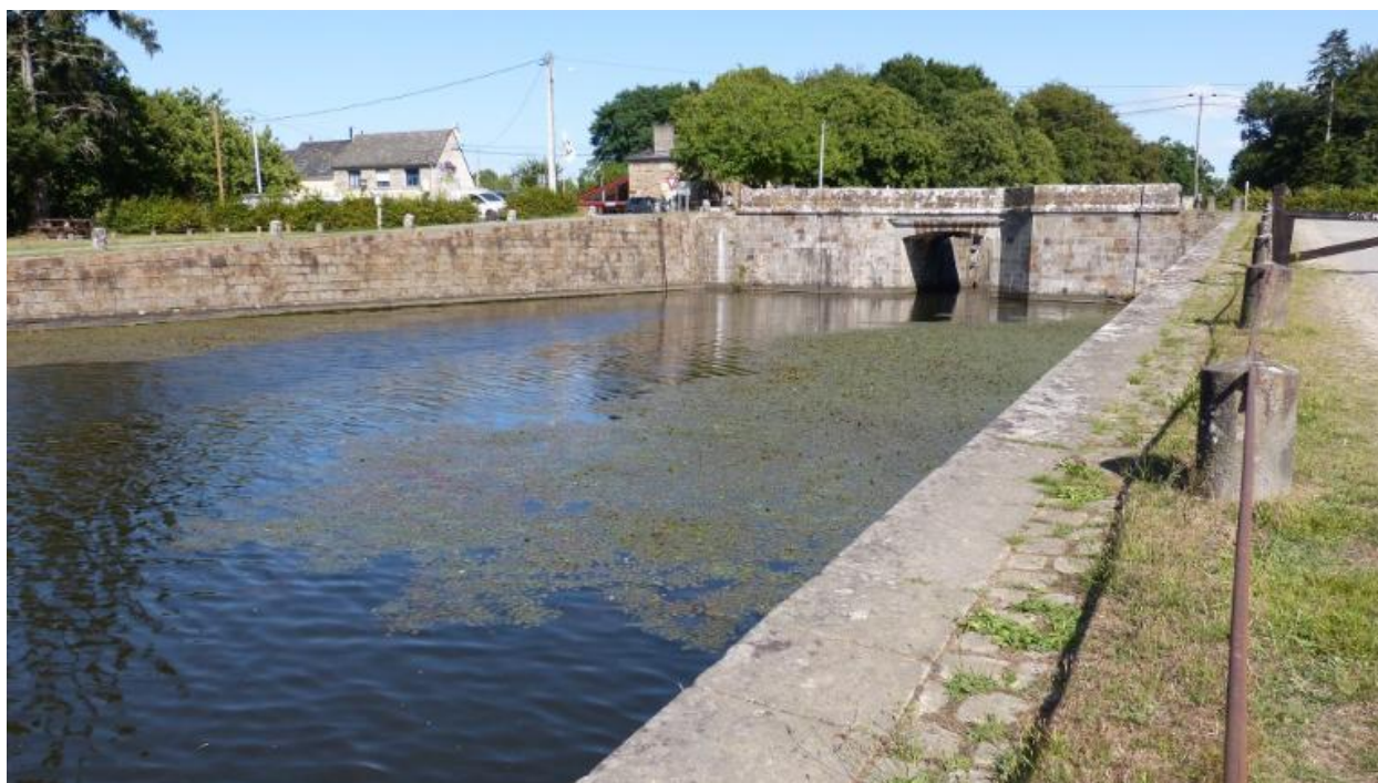
Vue sud ouest
