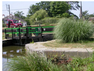
Vue nord-est Phot. Stéphanie Ménard IVR53_20053519015NUCA
