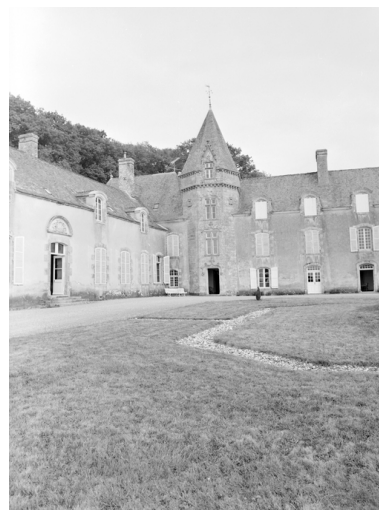
Tour dans l'angle des deux ailes : vue générale (état en 1979) Phot. Guy Artur, Phot. Norbert Lambart IVR53_19795600266X
