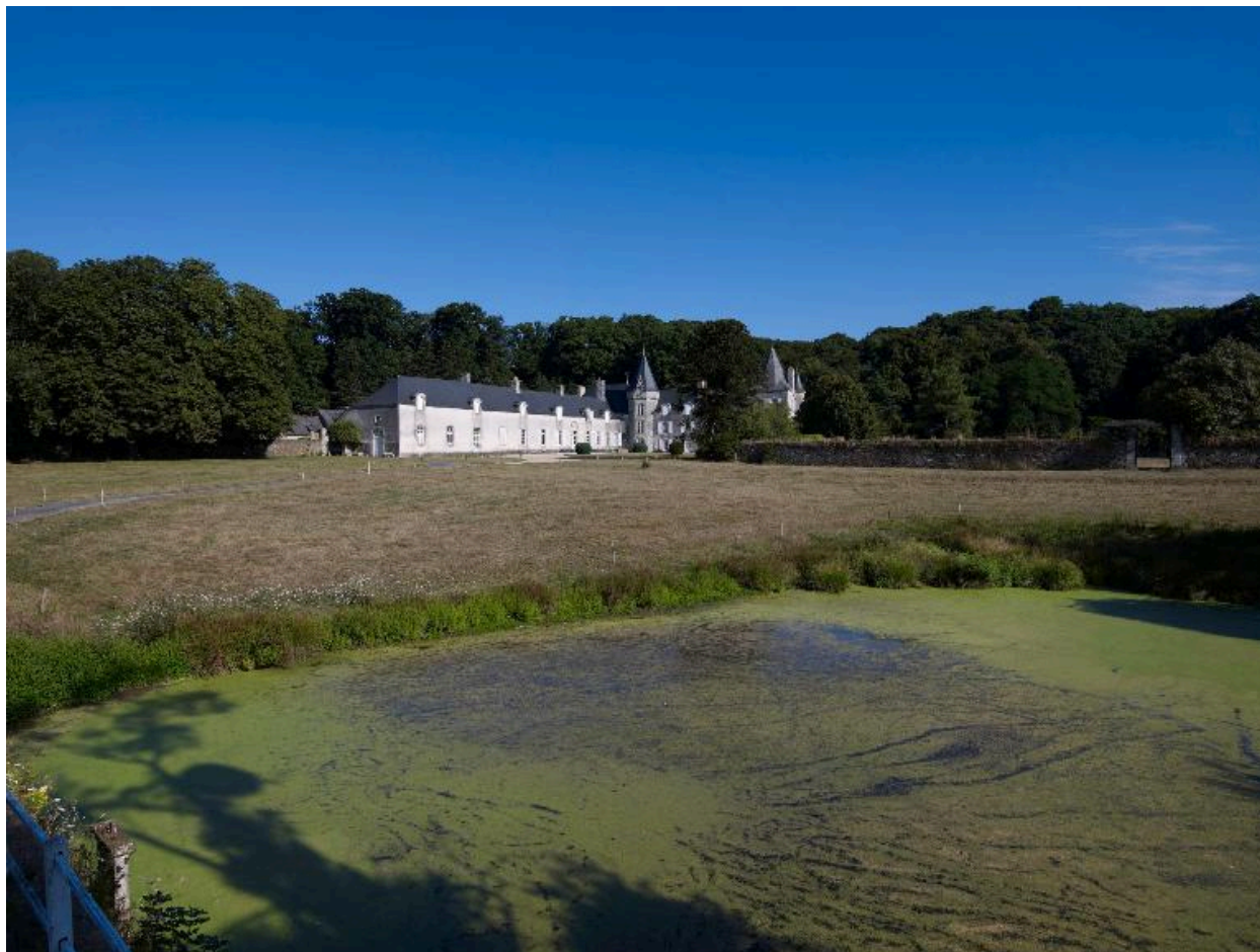
Logis, vue de situation sud-est
