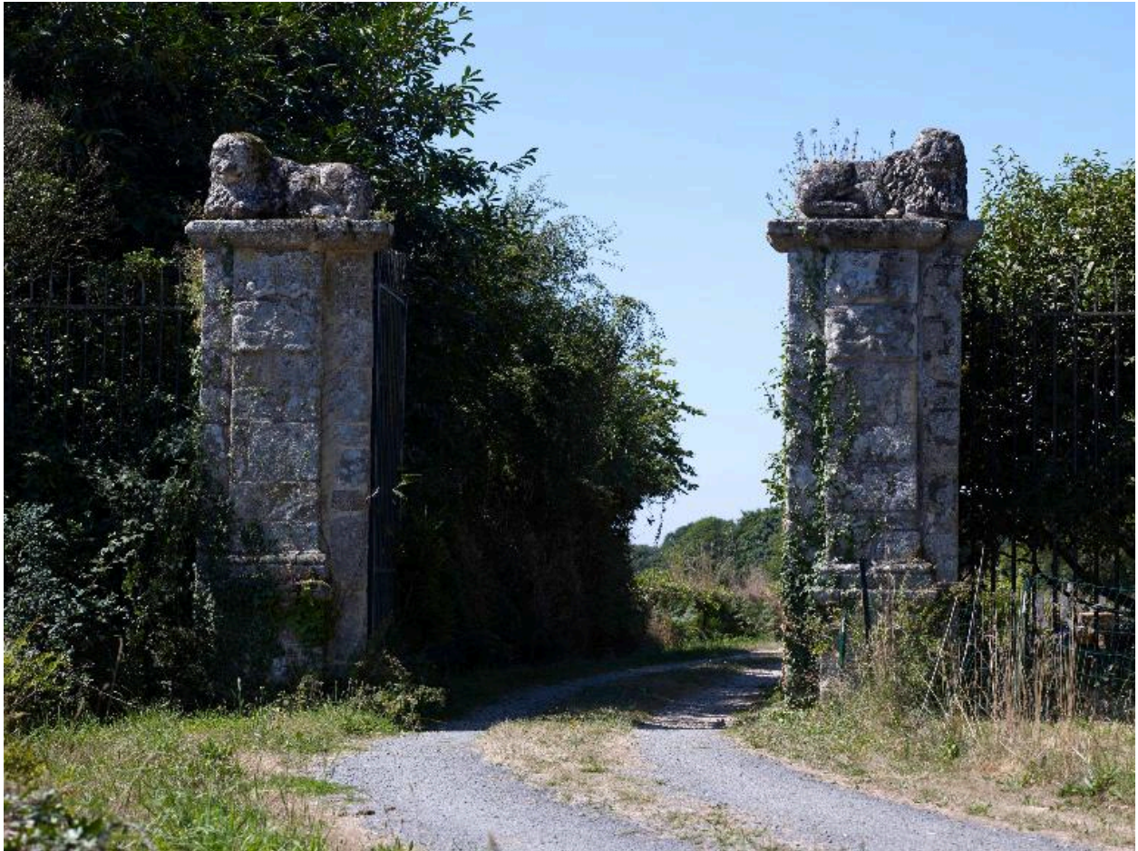
Portail d'entrée à l'est du château, vue rapprochée
