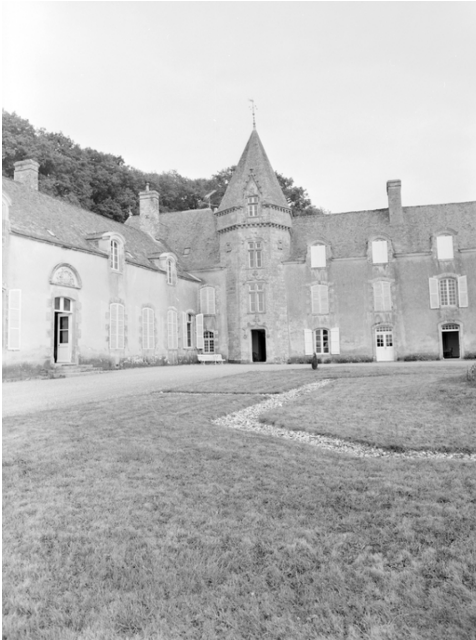
Tour dans l'angle des deux ailes : vue générale (état en 1979)
