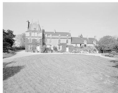
Vue générale de la façade principale Phot. Guy Artur, Phot. Norbert Lambart IVR53_19963500978X
