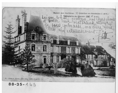
Vue de la façade principale Phot. Guy Artur, Phot. Norbert Lambart, Autr. Auguste Fleury IVR53_19883500145X
