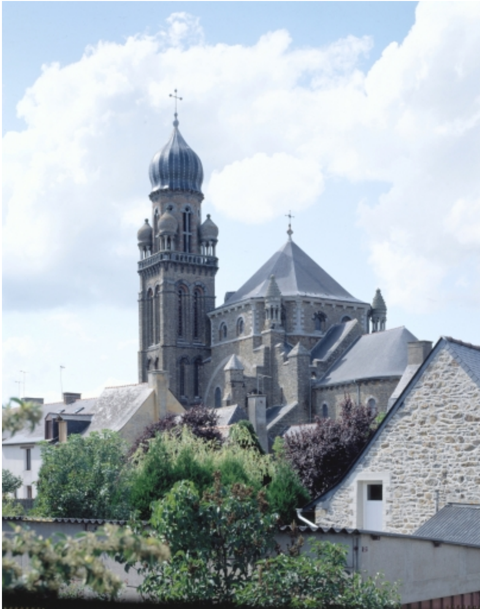
Elévation Sud-Est : vue générale
