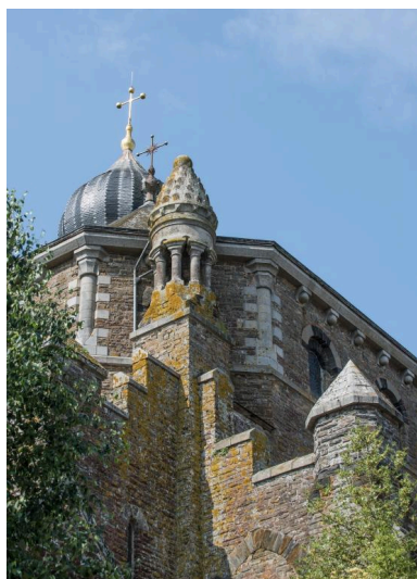
Détail des toitures Phot. Charlotte Barraud IVR53_20183500266NUCA
