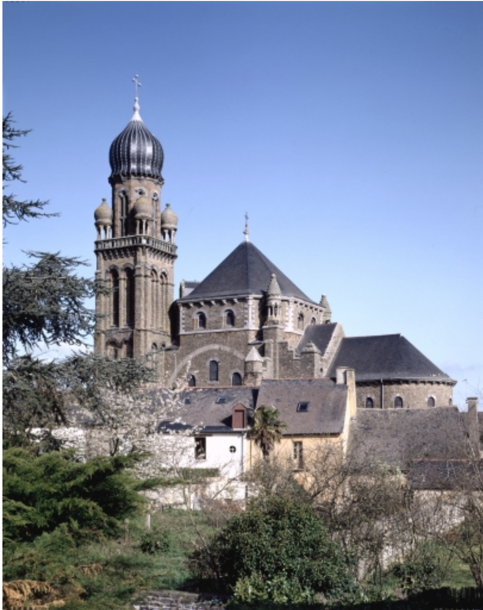
Elévation Sud-Est : vue générale
