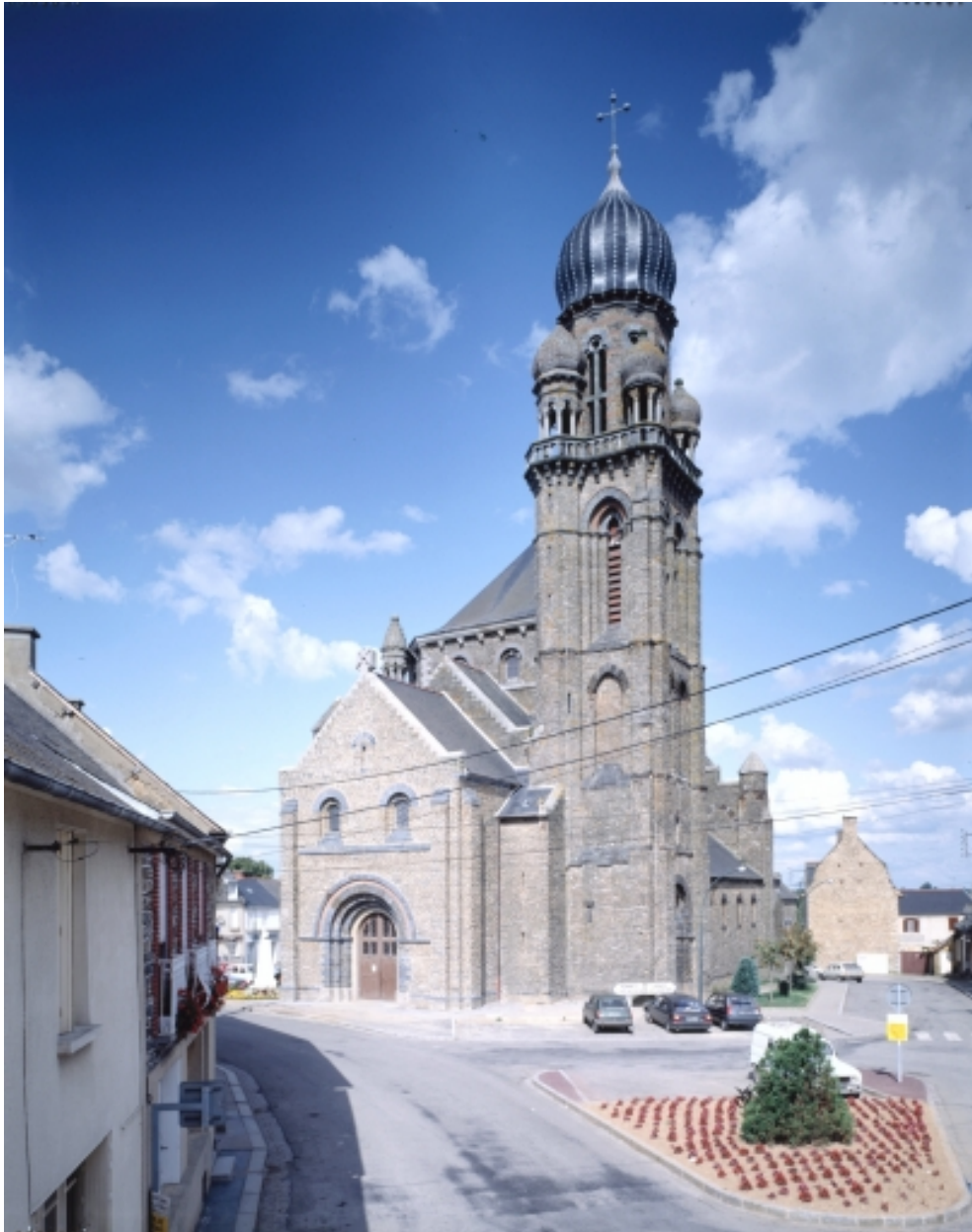
Elévation Ouest : vue générale
