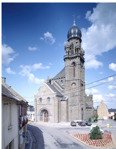
Elévation Ouest : vue générale Phot. Guy Artur, Phot. Norbert Lambart IVR53_19923500601VA
