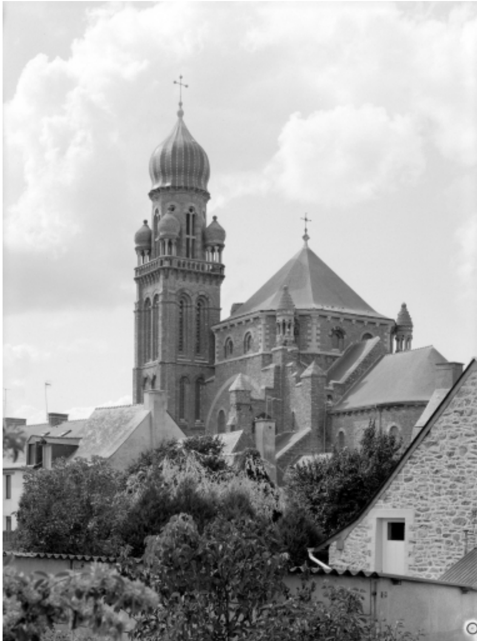
Elévation Sud-Est : vue générale
