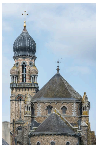
Détail des élévations Phot. Charlotte Barraud IVR53_20183500262NUCA
