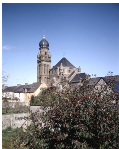
Elévation Sud-Est : vue générale Phot. Guy Artur, Phot. Norbert Lambart IVR53_19933500347VA
