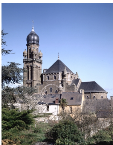
Elévation Sud-Est : vue générale Phot. Guy Artur, Phot. Norbert Lambart IVR53_19933500349VA
