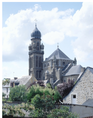
Elévation Sud-Est : vue générale Phot. Guy Artur, Phot. Norbert Lambart IVR53_19923500602VA
