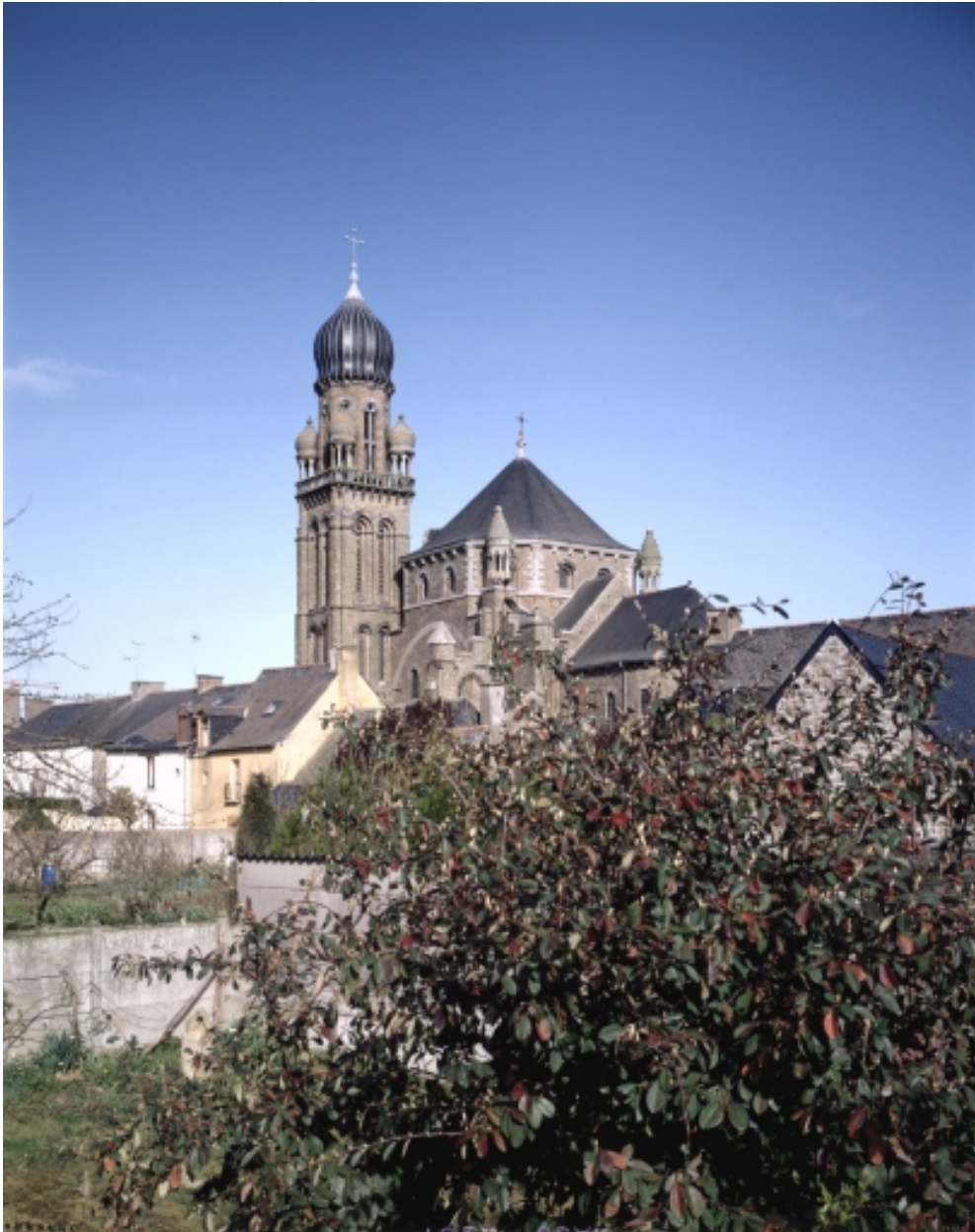
Elévation Sud-Est : vue générale
