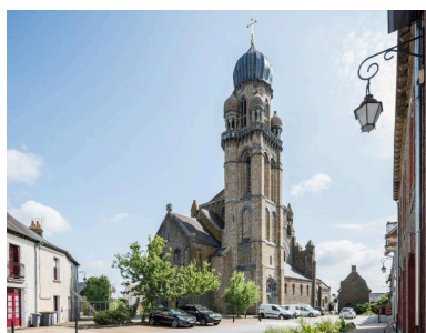
Vue générale de l'église Phot. Charlotte Barraud IVR53_20183500269NUCA
