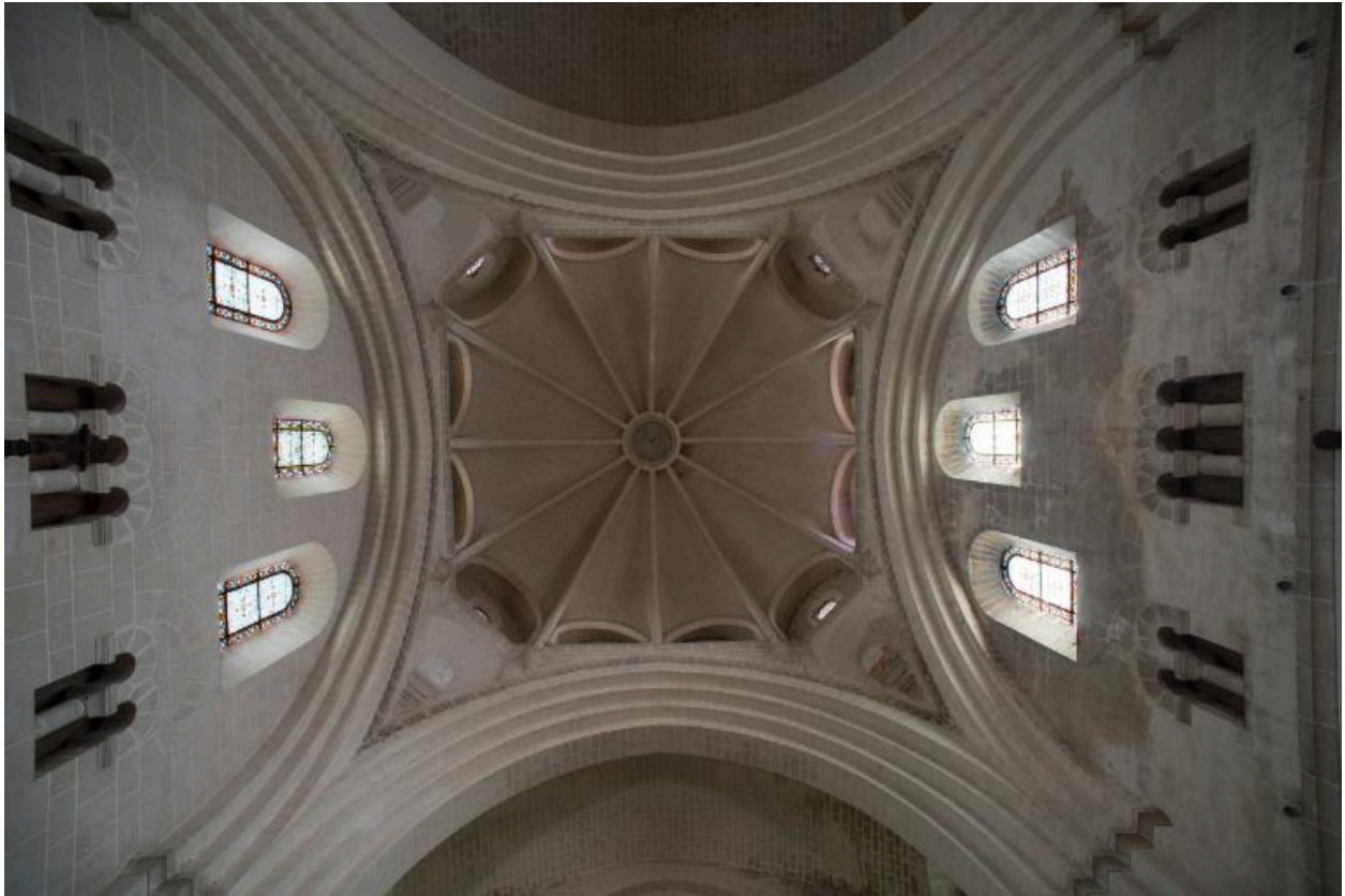
Détail des voûtes de couverture
