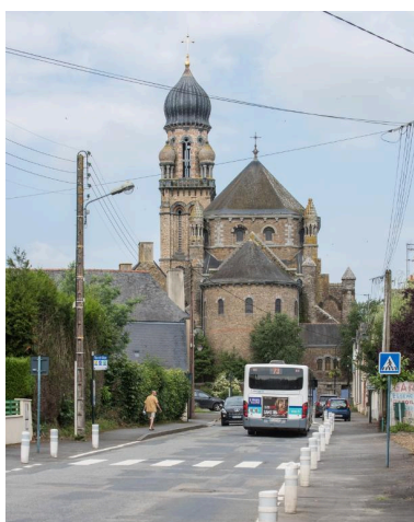
Elévation est Phot. Charlotte Barraud IVR53_20183500261NUCA
