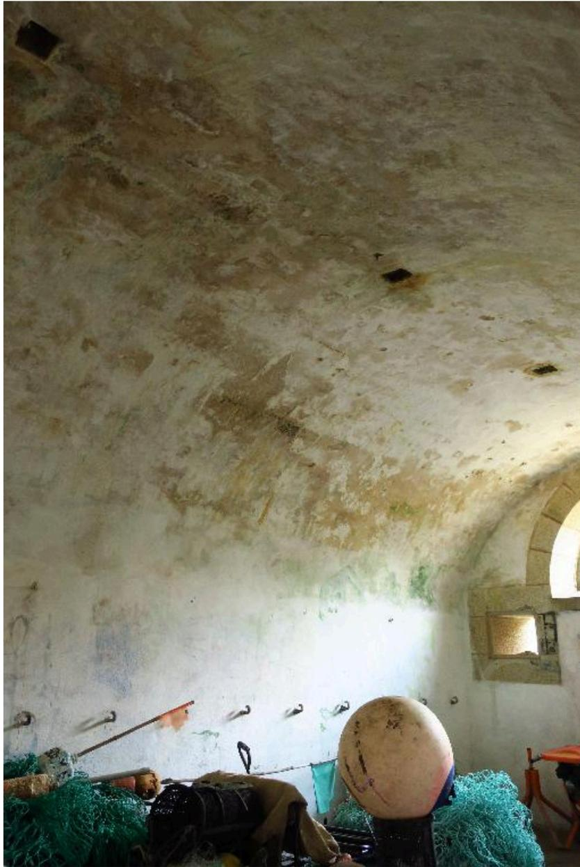
Archipel de Glénan, batterie de Penfret, corps de garde crénelé, trous de poteaux de support de hamacs dans la voûte d'une chambrée.
