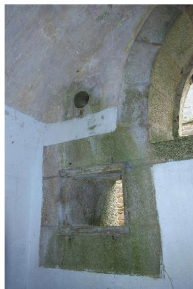
Archipel de Glénan, batterie de Penfret, corps de garde crénelé, créneau de tir et conduit de poêle dans une chambre.
