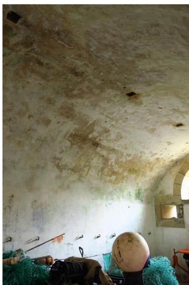
Archipel de Glénan, batterie de Penfret, corps de garde crénelé, trous de poteaux de support de hamacs dans la voûte d'une chambre.
