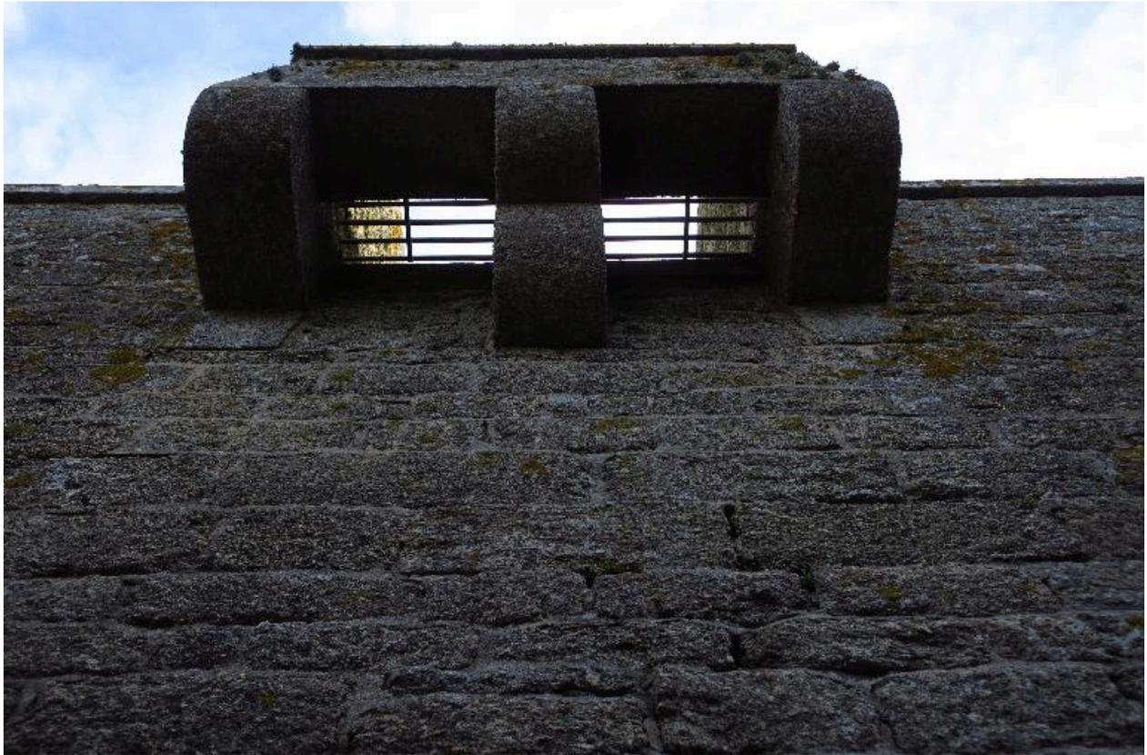
Archipel de Glénan, batterie de Penfret, corps de garde crénelé, détail d'une bretèche.
