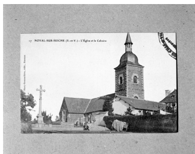
Elévation Nord-Ouest : vue générale (Carte postale ancienne, AD35 : 6Fi) Phot. Guy Artur, Phot. Norbert Lambart IVR53_19933500807X
