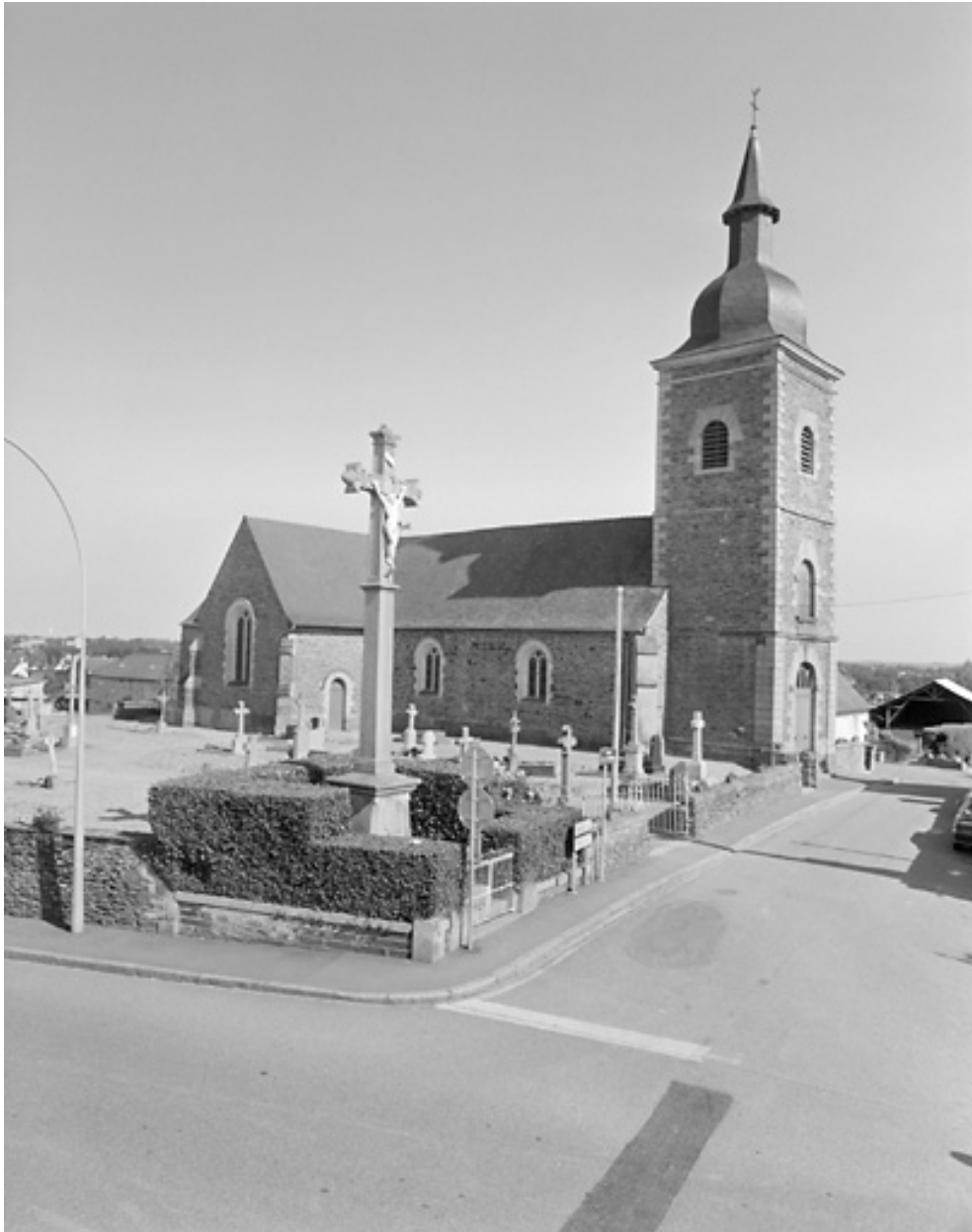
Elévation Nord-Ouest : vue générale.
