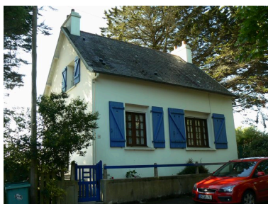
Vue côté route de la villa Les Embruns Phot. Johan Vincent IVR53_20072908763NUCA
