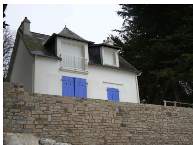
Vue avant de la villa Les Embruns Phot. Johan Vincent IVR53_20072908762NUCA
