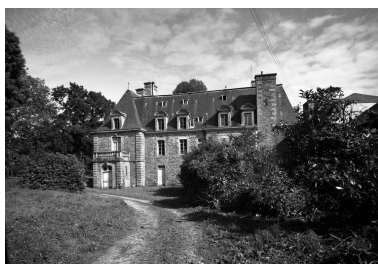
Vue générale nord-ouest : état en 1986 Phot. François Dagorn IVR53_19655600231V
