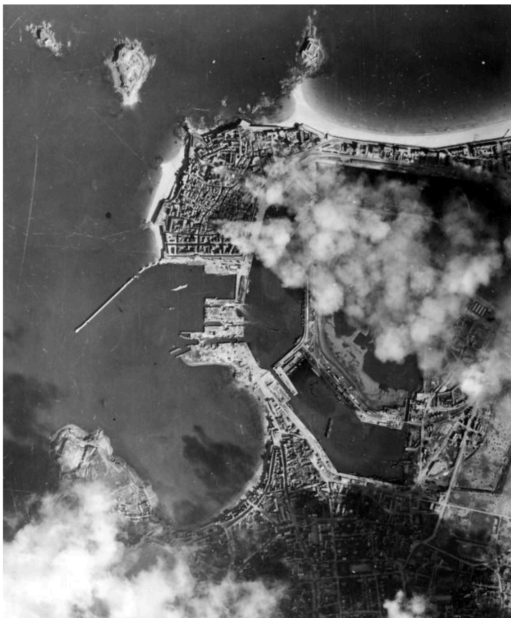
Vue aérienne verticale de Saint-Malo, 13 août 1944 (?). On peut observer le résultat de la destruction du port par l'occupant dans la nuit du 7 au 8 août (collection : Institut national de l'information géographique et forestière ?)
