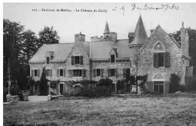
Vue générale Phot. Elise Lauranceau IVR53_20042905491NUCB
