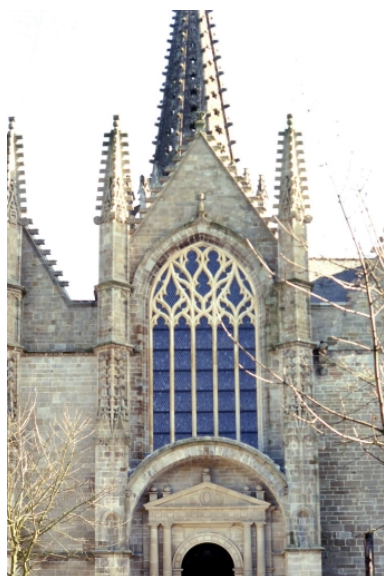
Elévation ouest : vue générale. Phot. Claude Quillivic IVR53_19943503057ZA
