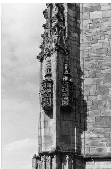
Élévation ouest, détail d'un pinacle. Phot. Auteur inconnu IVR53_19913500285V
