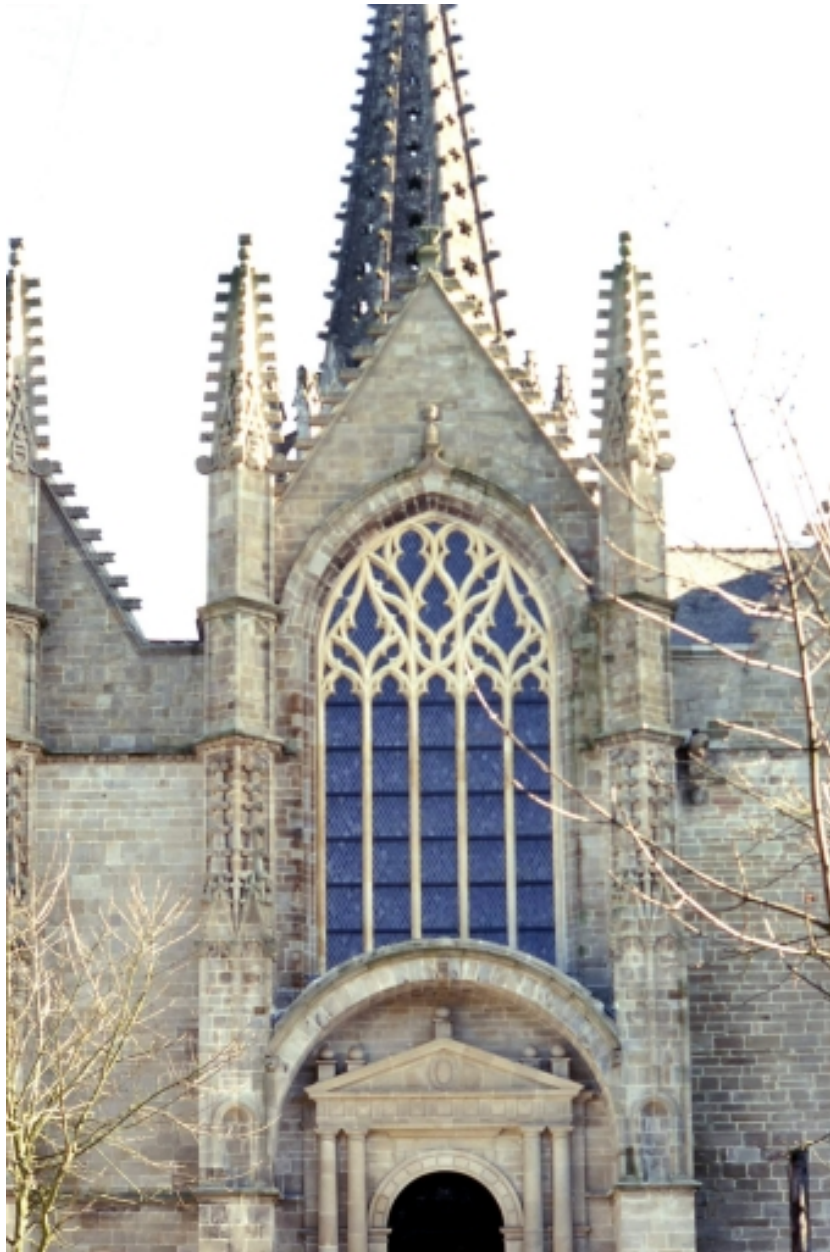
Elévation ouest : vue générale.
