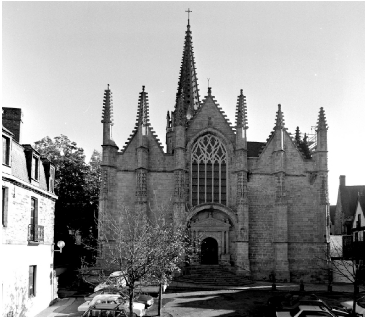
Elévation ouest : vue générale.
