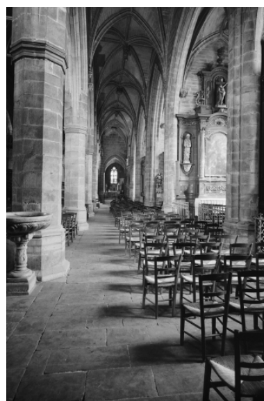
Nef bas-côté, vue générale vers élévation sud. Phot. Auteur inconnu
