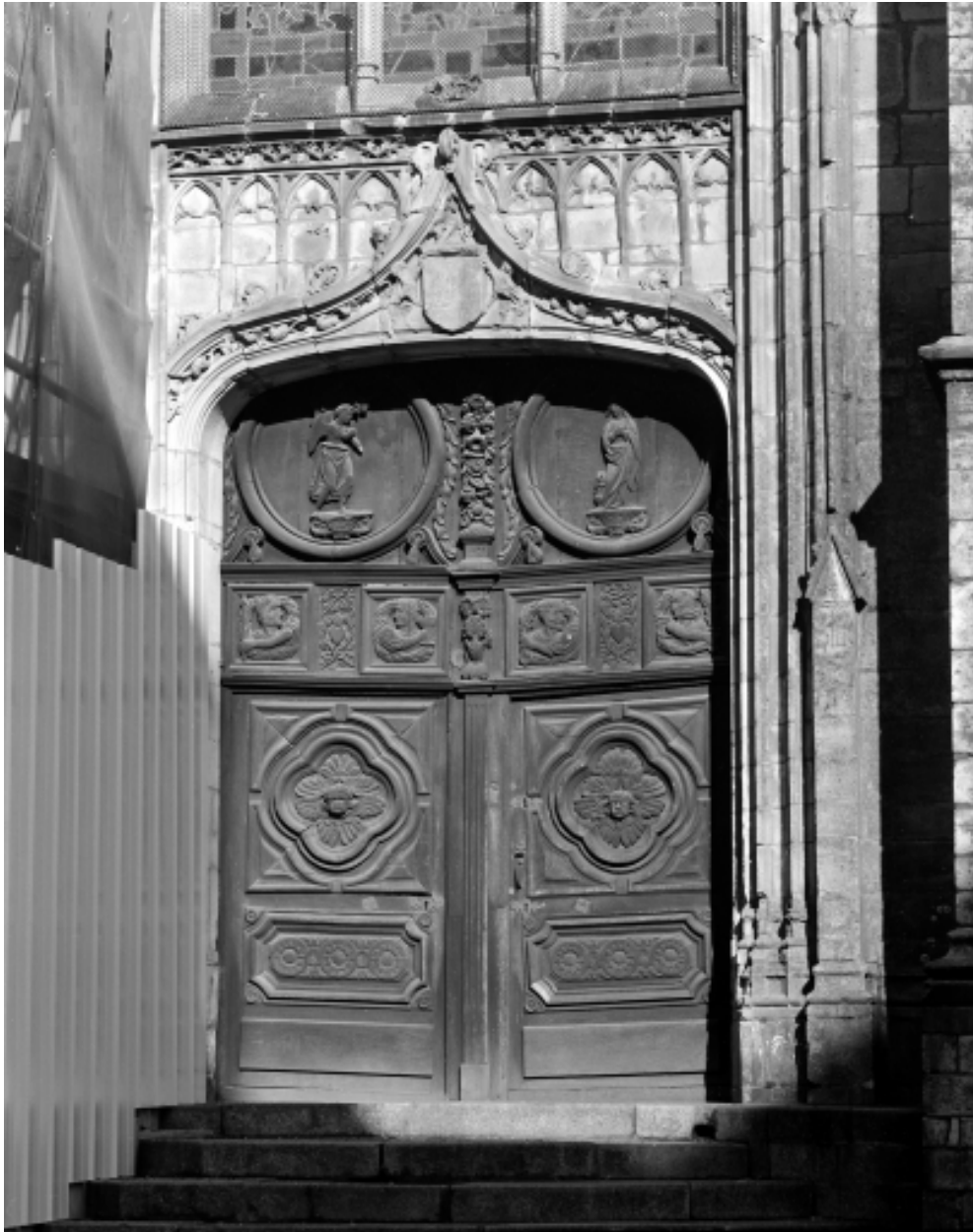
Elévation sud, porte : vue générale
