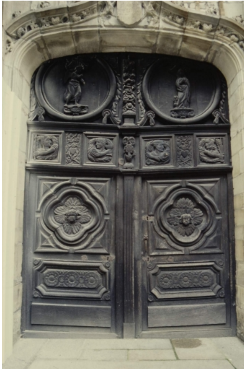
Elévation sud : détail de porte datée de 1689.
