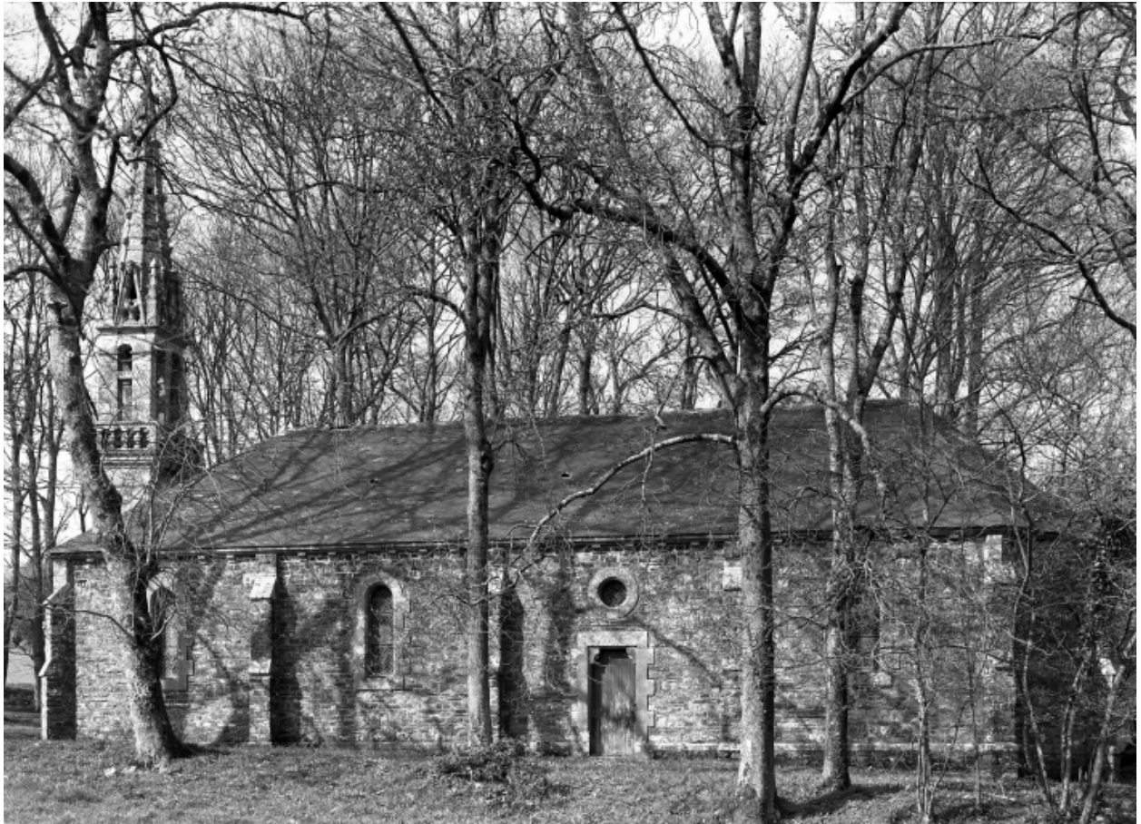
Vue générale sud. Etat en 1968
