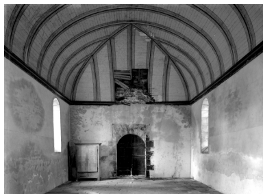
Intérieur, vue vers l'ouest. Etat en 1968 Phot. Le Doaré IVR53_19682900128V
