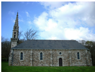
Elévation sud. Etat en 2008 Phot. Gwénaél Fauchille IVR53_20082905595NUCA
