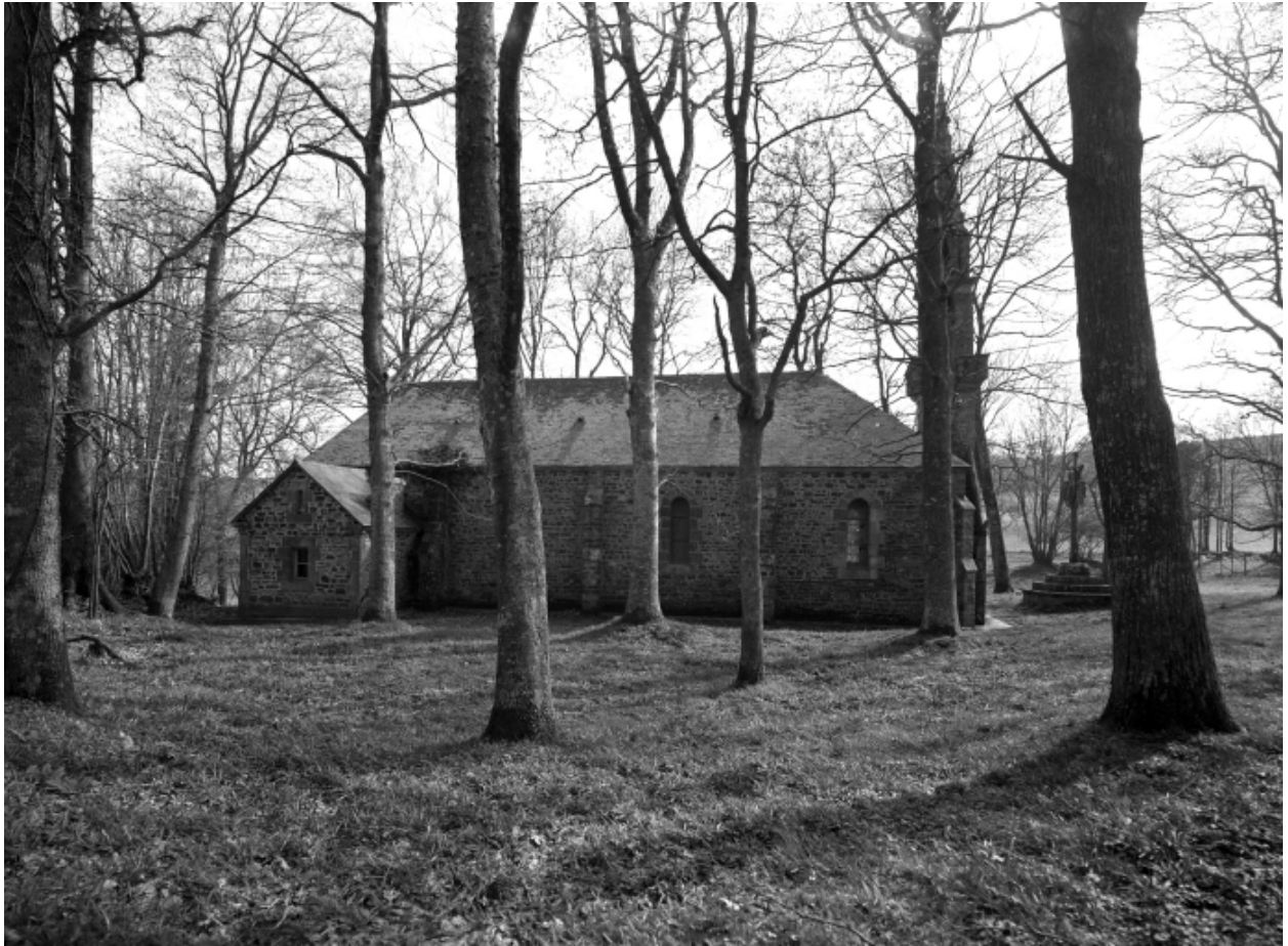
Vue générale nord. Etat en 1968
