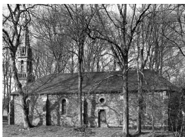
Vue générale sud. Etat en 1968 Phot. François Dagorn IVR53_19722900044V
