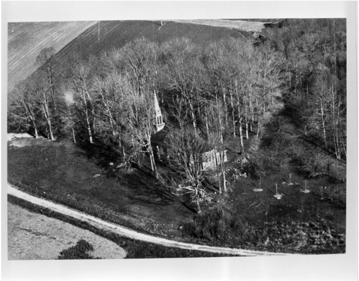
Vue aérienne sud-est. Etat en 1977
