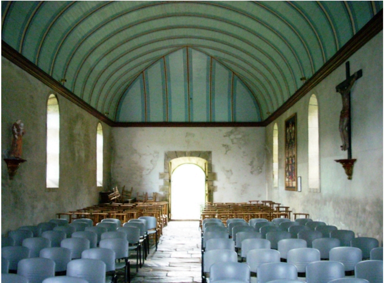
Intérieur, vue vers l'ouest. Etat en 2008
