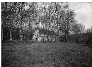
Vue générale sud-ouest. Etat en 1968 Phot. François Dagorn IVR53_19722900043V
