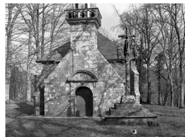
Détail élévation ouest et calvaire. Etat en 1968 Phot. Le Doaré IVR53_19682900123V
