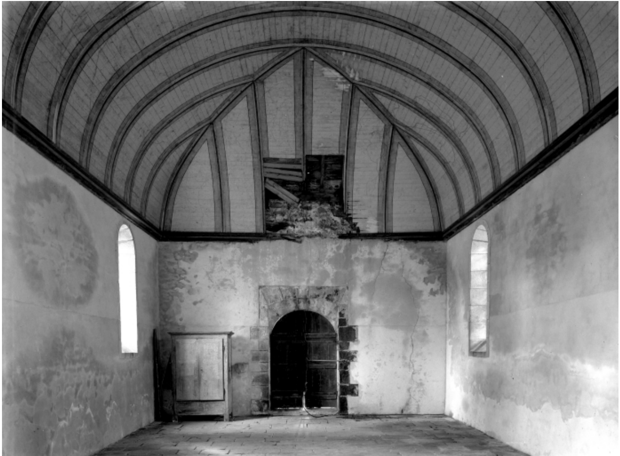
Intérieur, vue vers l'ouest. Etat en 1968
