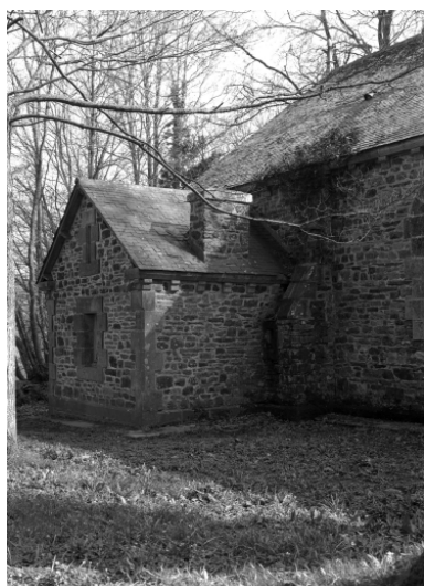
Elévation nord : sacristie. Etat en 1968
