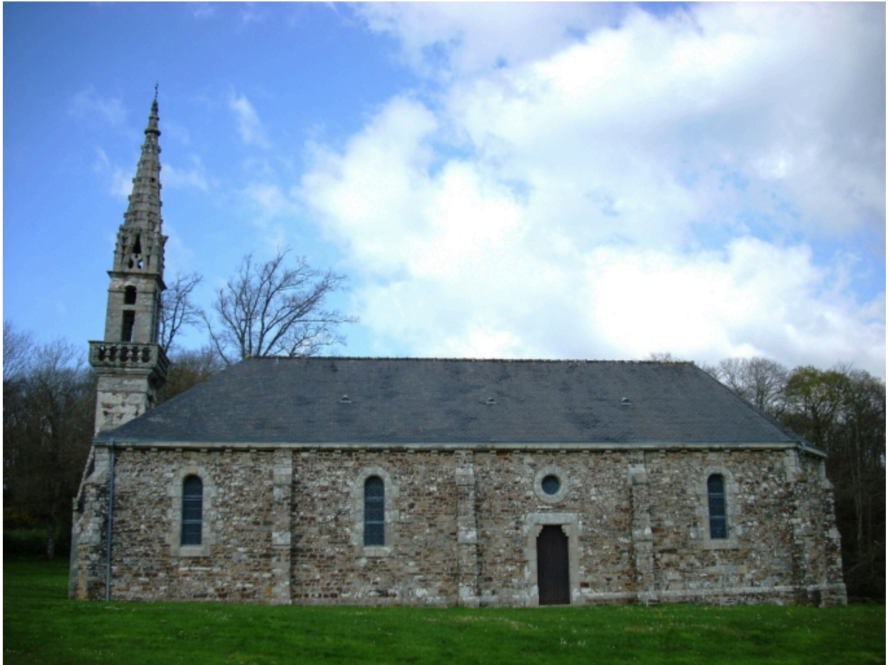
Elévation sud. Etat en 2008
