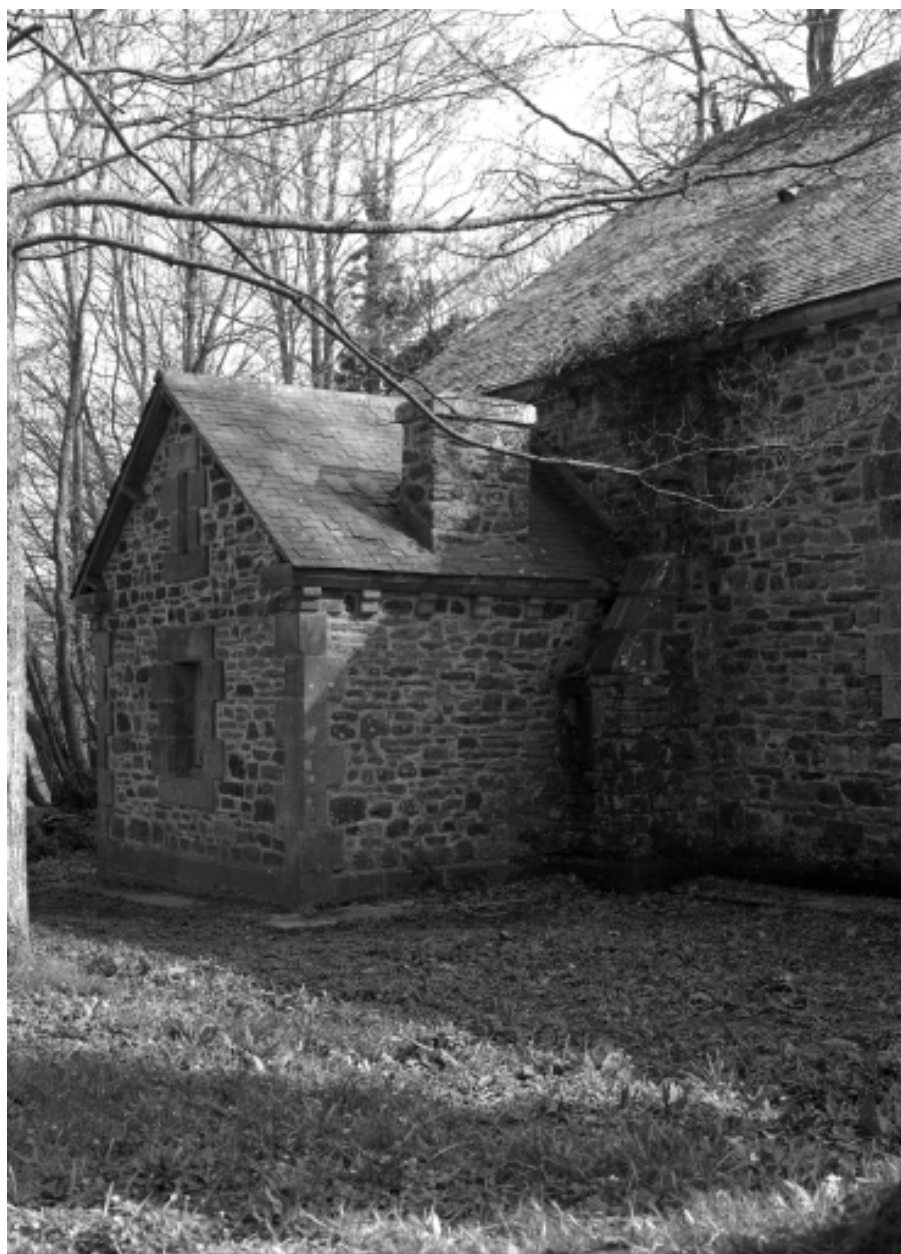
Elévation nord : sacristie. Etat en 1968
