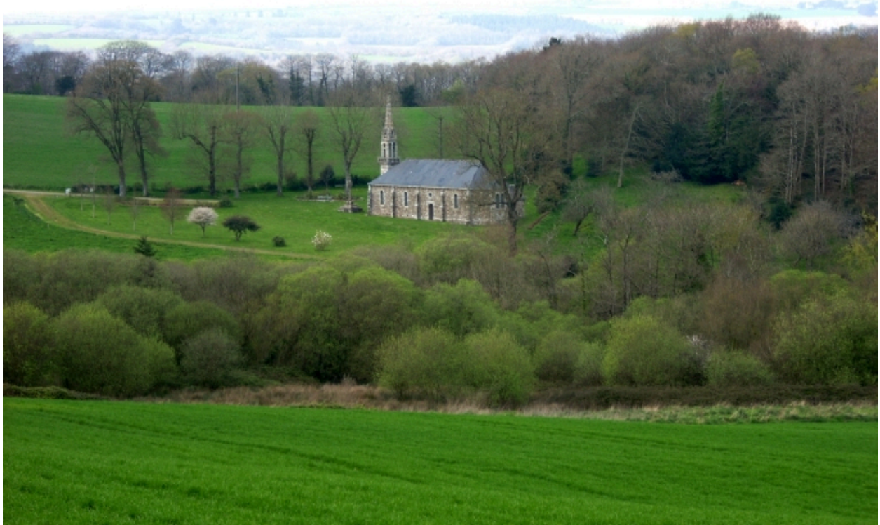
Vue de situation depuis le sud-est. Etat en 2008
