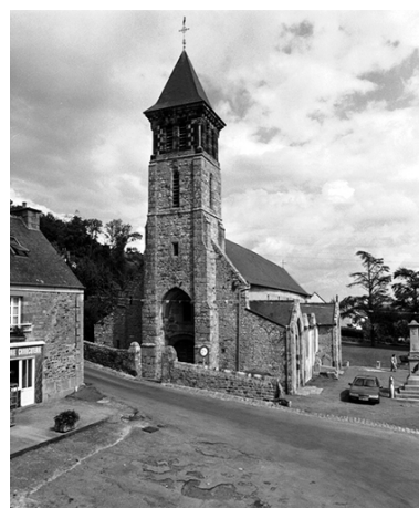
Vue générale sud-ouest Phot. Guy Artur, Phot. Norbert Lambart IVR53_19943501808X
