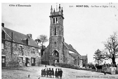
L'église : vue ouest (début 20e siècle) Repro. Guy Artur, Repro. Norbert Lambart IVR53_19933500760X
