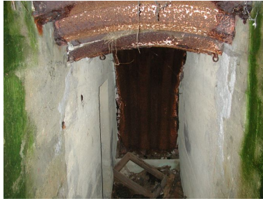
Vue de l'entrée : couloir d'accès couvert en tôle métro (état en 2002) Phot. Guillaume Lécueillier IVR53_20022901545NUCA
