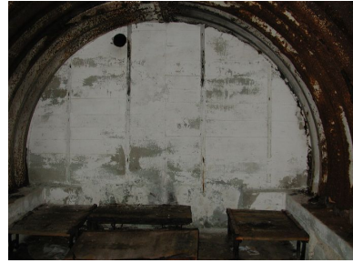
Vue de la pièce de vie/ chambree (état en 2002) Phot. Guillaume Lécueillier IVR53_20022901546NUCA
