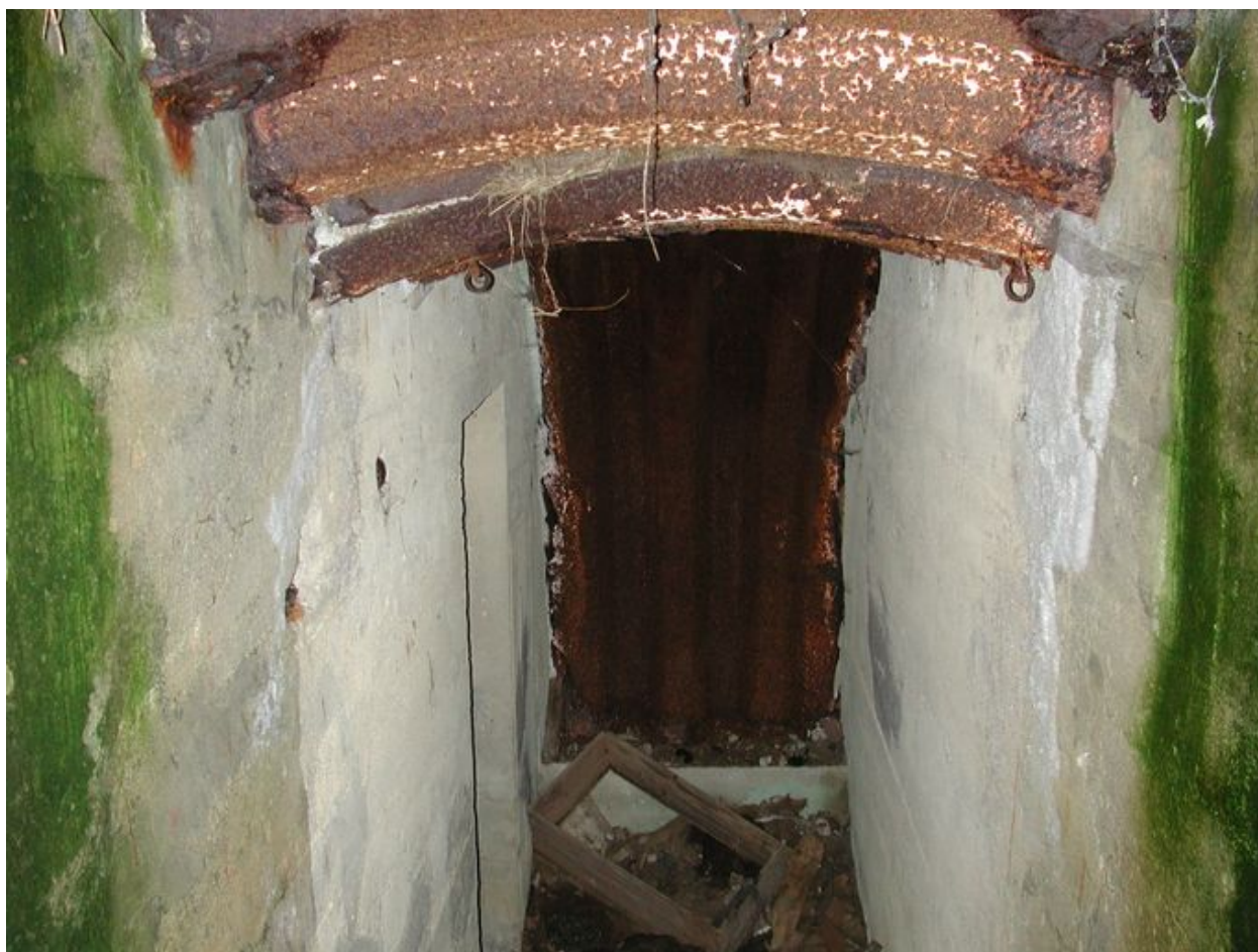
Vue de l'entrée : couloir d'accès couvert en tôle métro (état en 2002)
