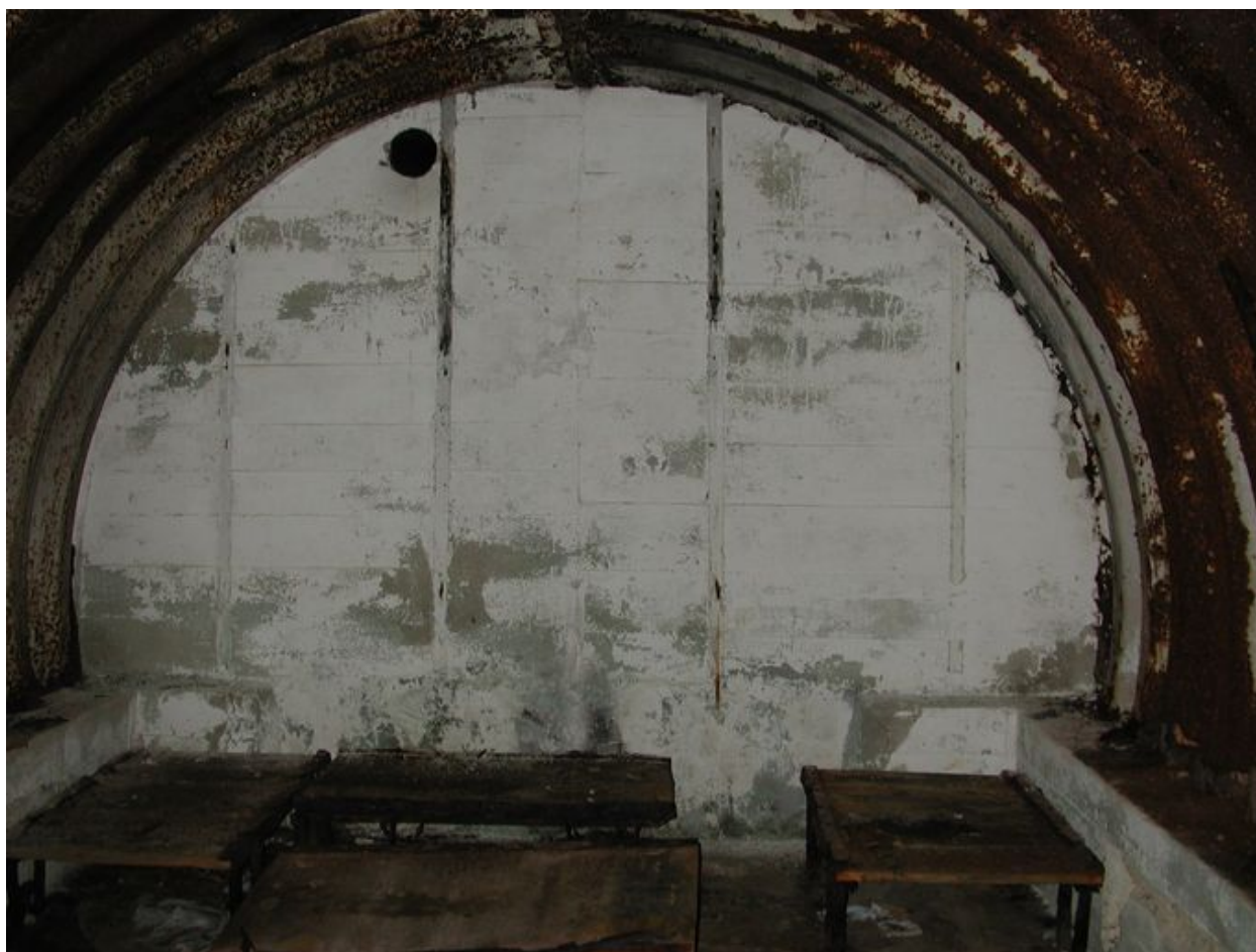
Vue de la pièce de vie/chambrée (état en 2002)
