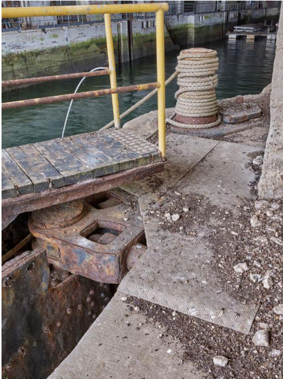
Vue de détail de la porte est de l'algéole G (n° 13 et 14) : mécanisme d'ouverture et cabestan
