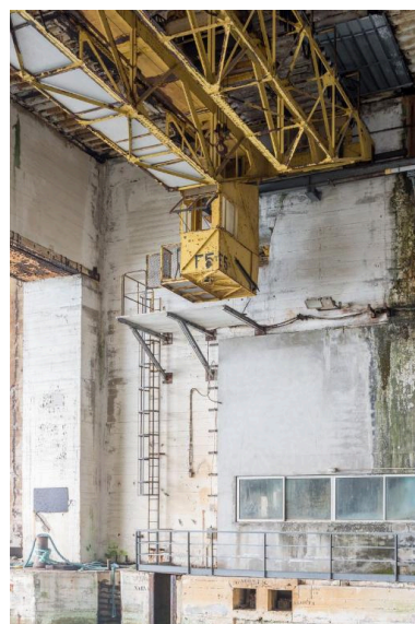
Vue de l'alvéole G (n° 13 et 14) : quai ouest n° 14 et pont roulant d'une capacité de 5 tonnes Phot. Charlotte Barraud IVR53_20215600652NUCA
