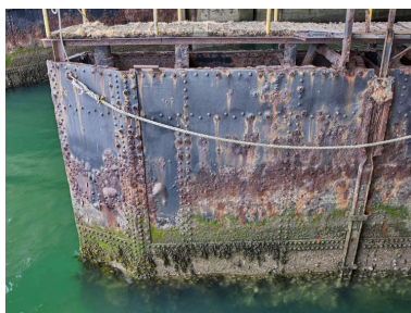
Vue de détail de la porte est de l'alvéole G (n° 13 et 14) Phot. Bernard Bègne IVR53_20215600464NUCA
