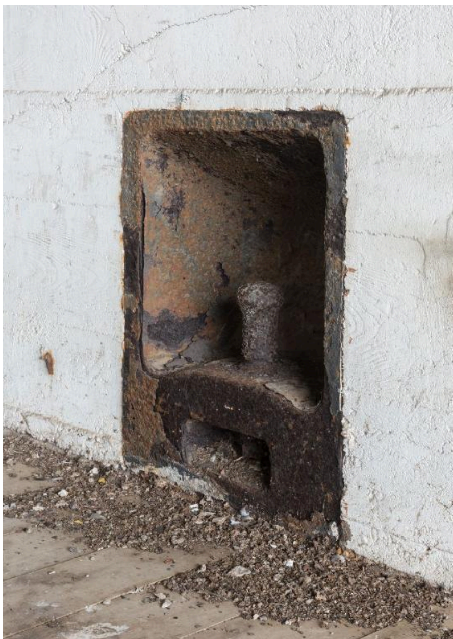
Vue de l'alcôve G (n° 13 et 14) : quai est n° 13, bollard ou borne d'amarrage intégré dans le mur
