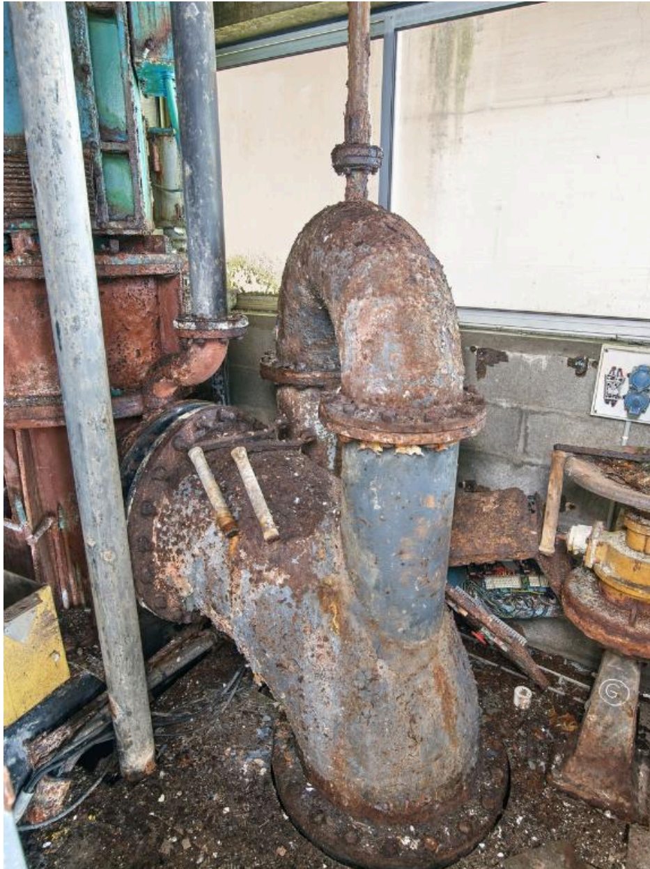
Vue du corps/tuyau de pompe du bassin G. Deux manivelles sont posées sur le tuyau de pompe
