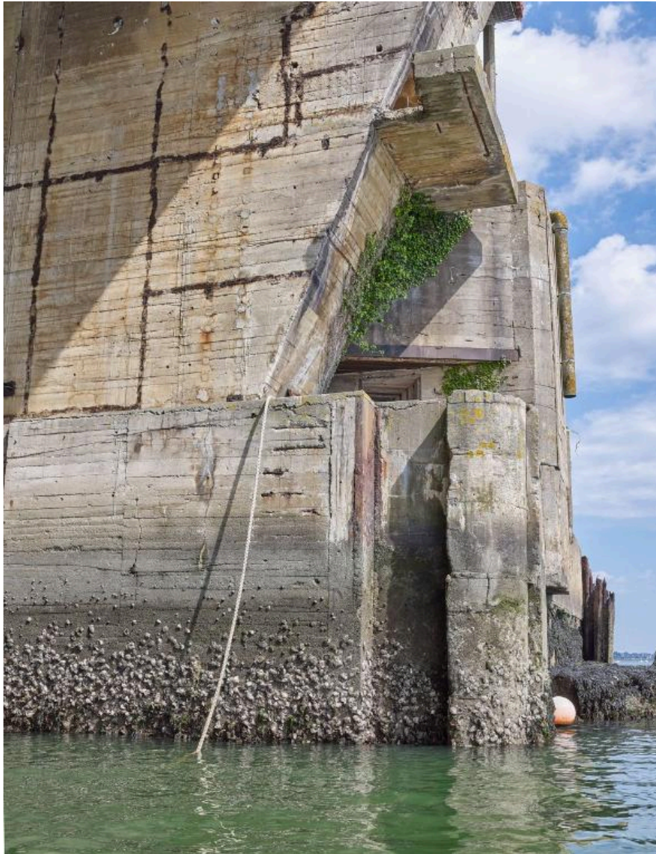
Vue de l'entrée de l'alvéole G (n° 13 et 14) : contrefort du mur latéral. Une casemate pour mitrailleuse - dont l'embrasure est partiellement visible ici - protège les approches de la base de sous-marins
