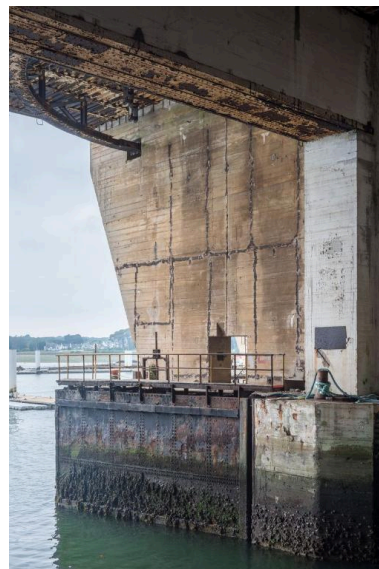
Vue de l'entrée de l'alvéole G (n ° 13 et 14) : porte ouest et supports de fixation de la porte haute Phot. Charlotte Barraud IVR53_20215600651NUCA
