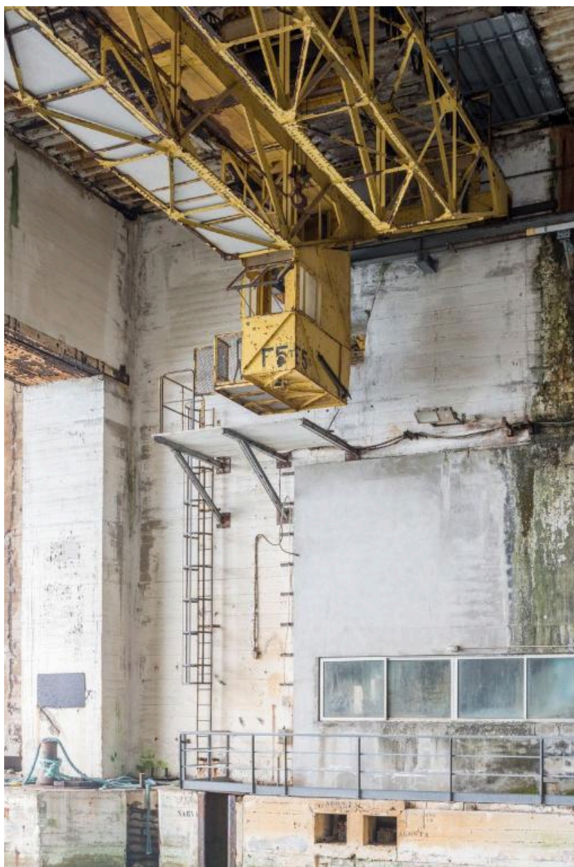
Vue de l'alcôve G (n° 13 et 14) : quai ouest n° 14 et pont roulant d'une capacité de 5 tonnes
