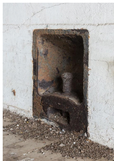
Vue de l'alvéole G (n° 13 et 14) : quai est n° 13, bollard ou borne d'amarrage intégré dans le mur Phot. Charlotte Barraud IVR53_20215600655NUCA
