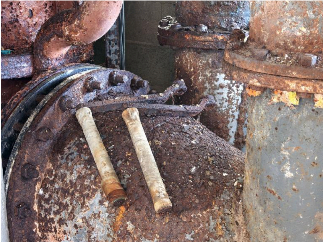
Vue de détail du corps/tuyau de pompe du bassin G. Deux manivelles sont posées sur le tuyau de pompe
