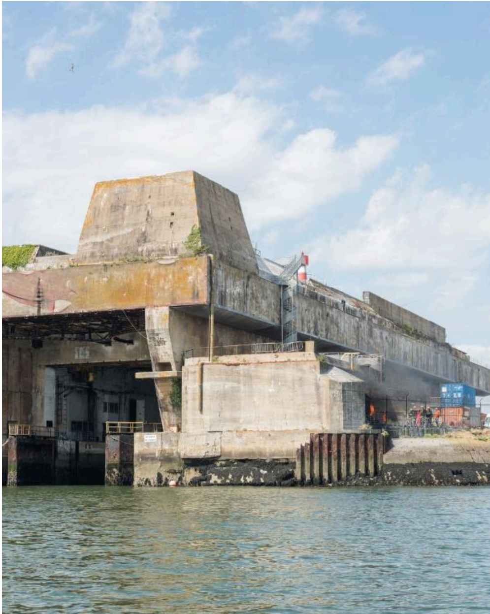
Vue de l'angle sud-est et entrée de l'alvéole G (sud). Cet angle de la base est protégé par une casemate pour canon et mitrailleuse et surmonté par un encuvement pour canon antiaérien
