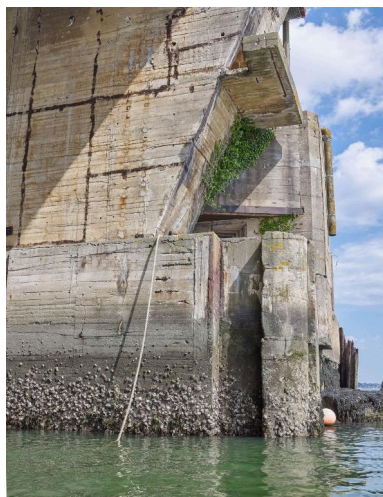
Vue de l'entrée de l'alvéole G (n° 13 et 14) : contrefort du mur latéral. Une casemate pour mitrailleuse - dont l'embrasure est partiellement visible ici - protège les approches de la base de sous-marins Phot. Bernard Bègne IVR53_20215600523NUCA
