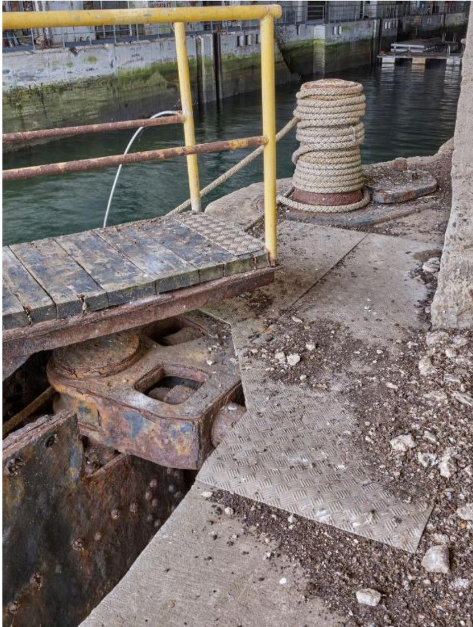
Vue de détail de la porte est de l'alvéole G (n° 13 et 14) : mécanisme d'ouverture et cabestan
