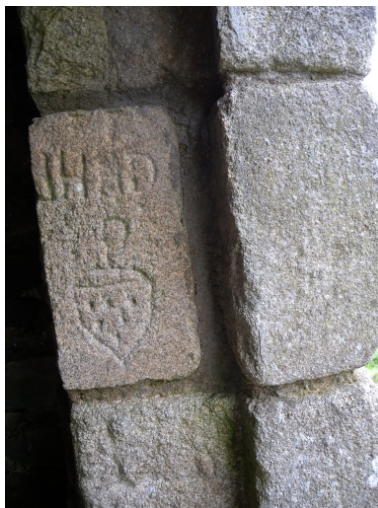
Vue de la pierre maçonnée et sculptée servant de contrefort intérieur au niveau de l'ouverture principale (à droite) Phot. Guy Prigent IVR53_20082213343NUCA
