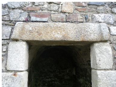
Vue des pierres d'encadrement de l'ouverture principale Phot. Guy Prigent IVR53_20082213340NUCA
