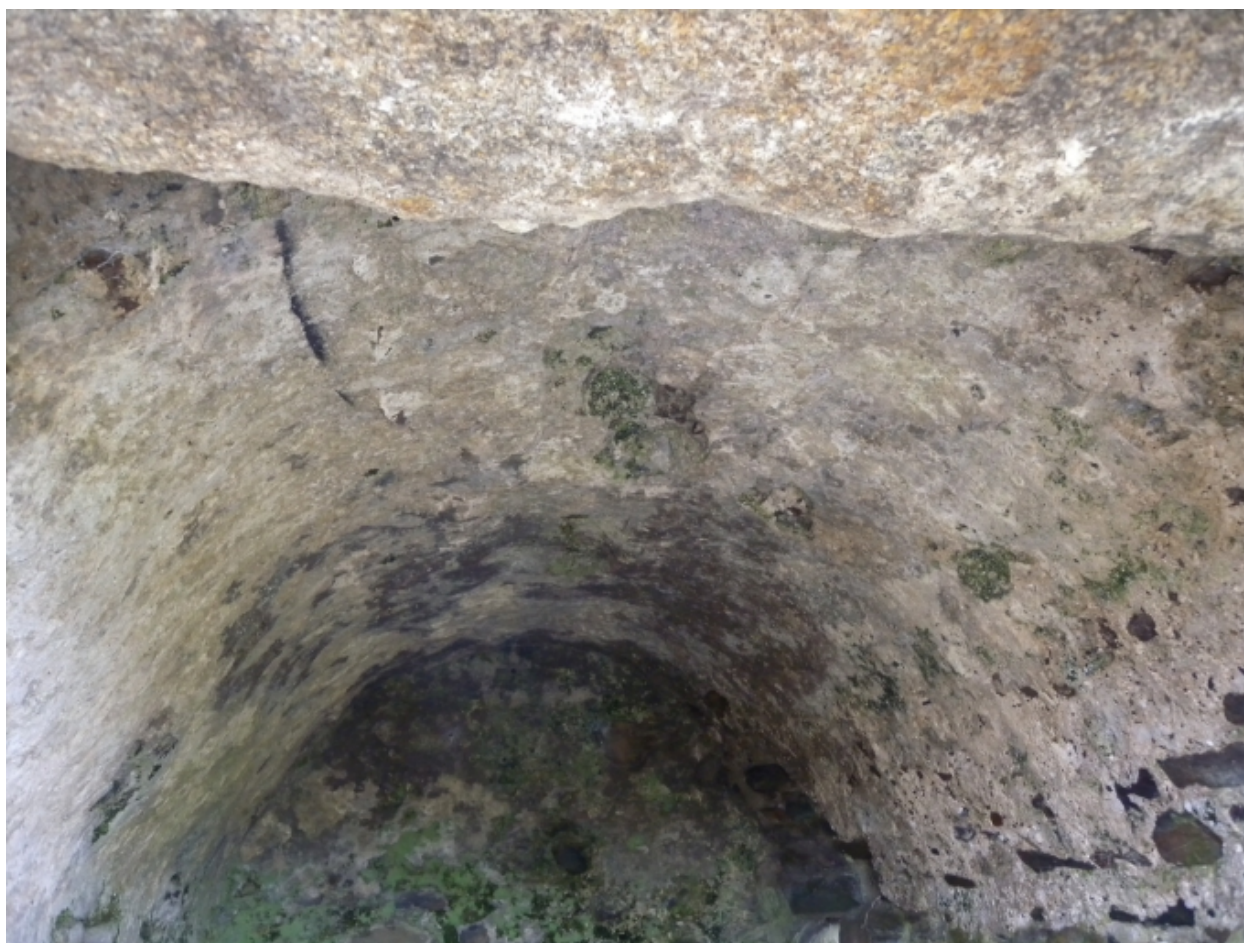
Vue de la voûte intérieure
