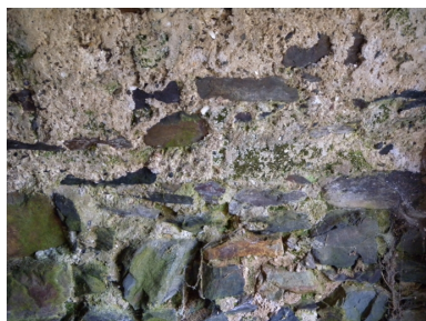
Vue de détail de la maçonnerie intérieure : moellons de schiste et liant en sable coquiller Phot. Guy Prigent IVR53_20082213342NUCA
