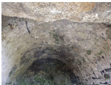
Vue de la voûte intérieure Phot. Guy Prigent IVR53_20082213341NUCA
