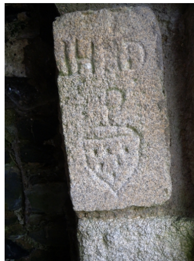
Vue de détail des armoiries sculptées dans la pierre maçonnée Phot. Guy Prigent IVR53_20082213344NUCA
