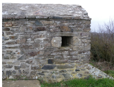
Vue de la façade Est du corps de garde avec la petite ouverture Phot. Guy Prigent IVR53_20082213338NUCA
