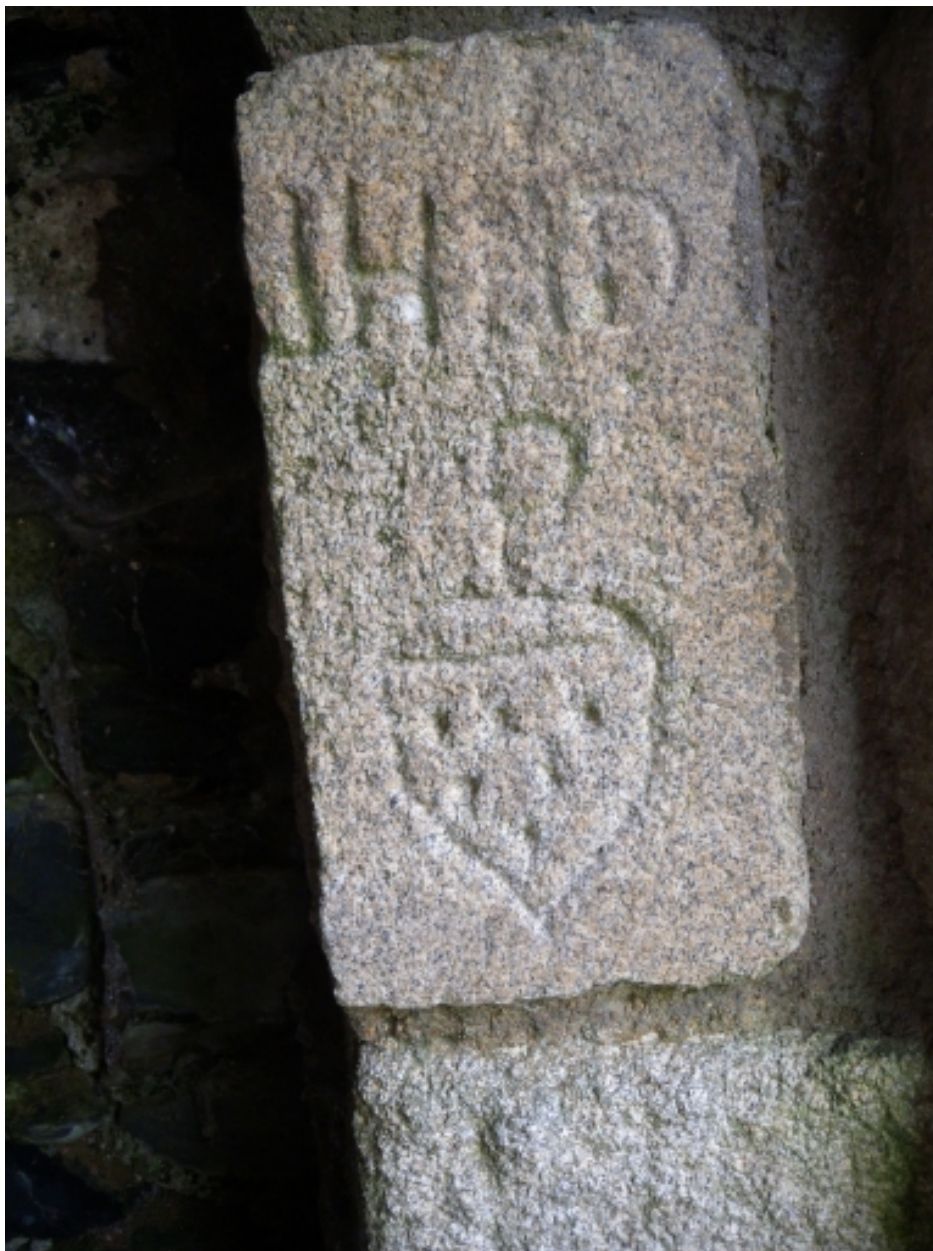
Vue de détail des armoiries sculptées dans la pierre maçonnée
