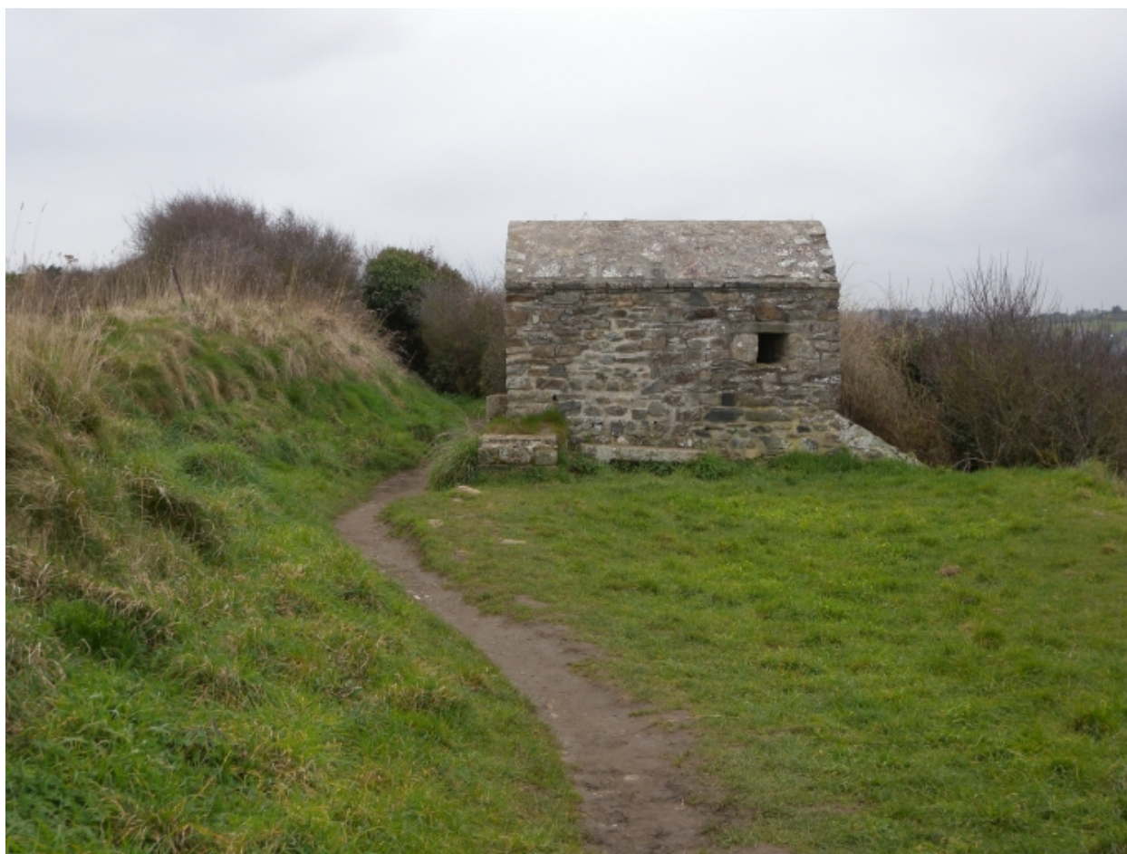
Vue de la façade Est du corps de garde
