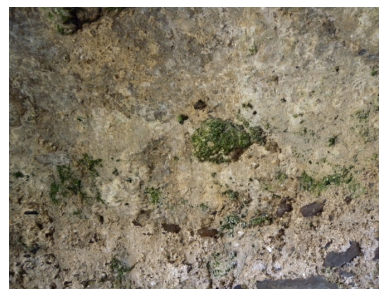
Vue de détail de la voûte intérieure chaulée Phot. Guy Prigent IVR53_20082213345NUCA
