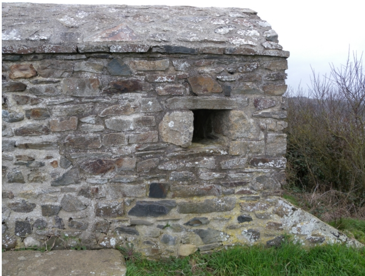
Vue de la façade Est du corps de garde avec la petite ouverture
