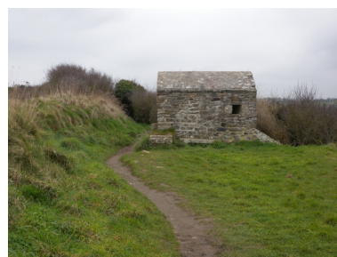
Vue de la façade Est du corps de garde Phot. Guy Prigent IVR53_20082213337NUCA
