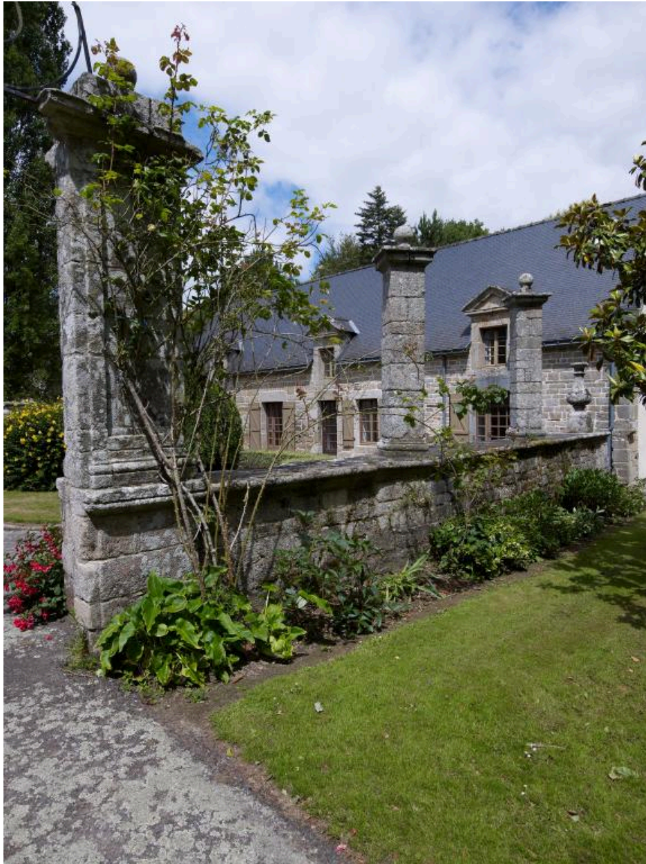
Vue générale de la dépendance
