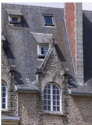
Vue de la fenêtre haute sur la façade est Phot. Bernard Bègne IVR53_20115600740NUCA
