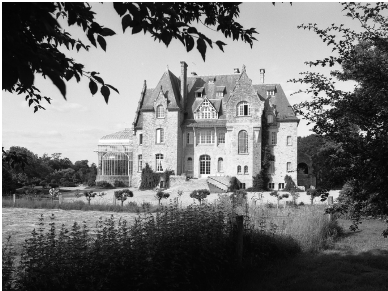
Vue générale sud
