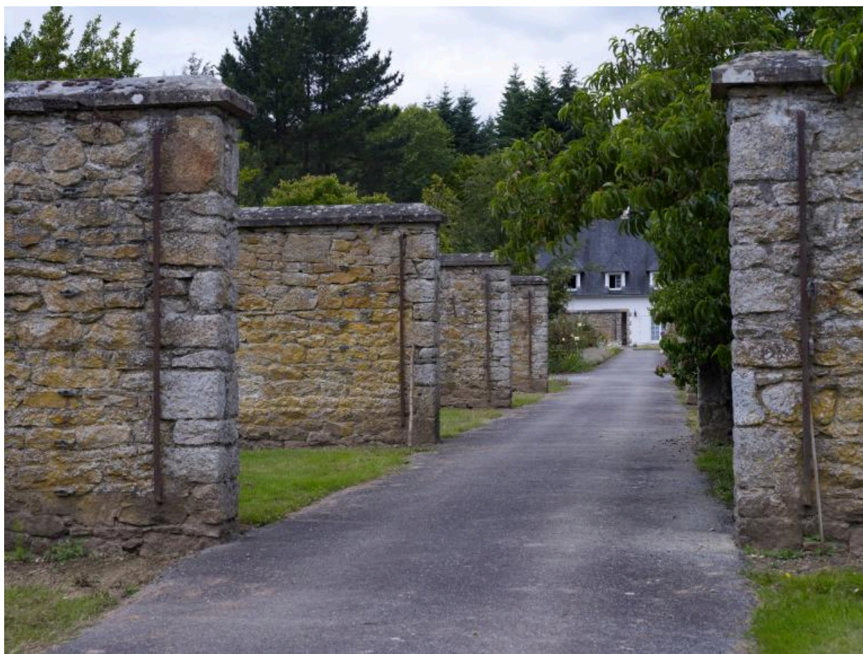
Vue des murs de palissage du verger
