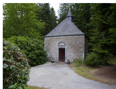
Vue générale de la chapelle Phot. Bernard Bègne IVR53_20115600742NUCA
