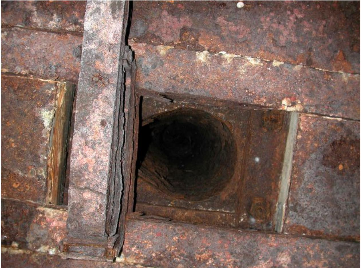
Vue de la casemate à toit blindé armée d'un canon de 75 mm Pak 40 (Type 626) (B 109) : orifice du périscope
