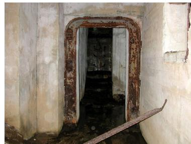
Vue de la casemate à toit blindé armée d'un canon de 75 mm Pak 40 (Type 626) (B 109) : porte blindée étanche de type marine
