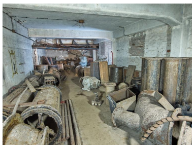
Vue du sous-sol de la salle des groupes électrogènes diesel : extrémité est, ensemble de réservoir d'air comprimé. Ces réservoirs datent de la période allemande Phot. Bernard Bègne IVR53_20235600788NUCA
