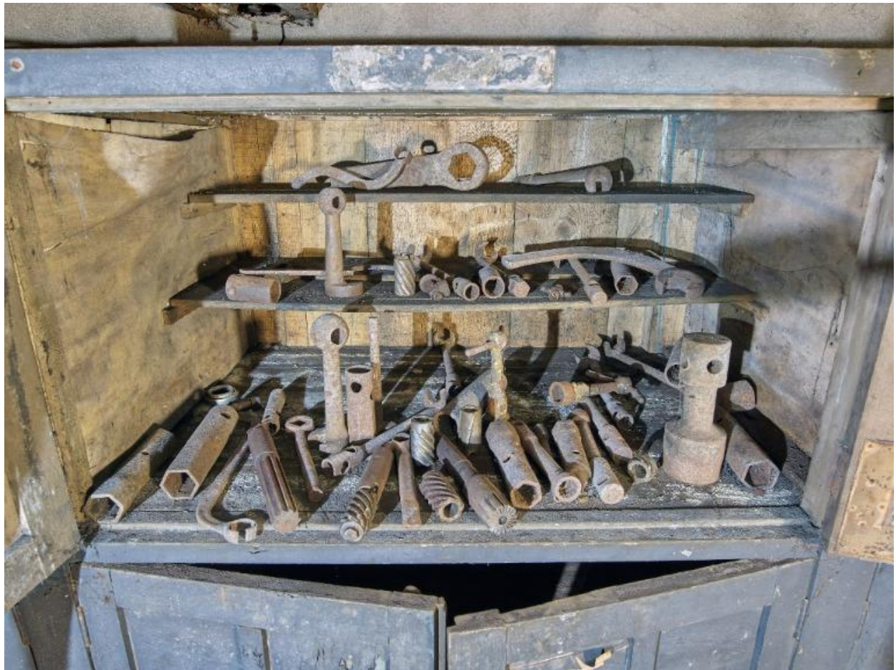
Vue du sous-sol de la salle des groupes électrogènes diesel : extrémité ouest, intérieur de l'une des armoires d'atelier avec ses outils et accessoires pour machine-outil
