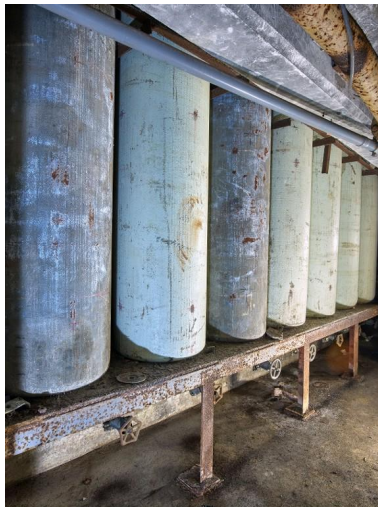
Vue du sous-sol de la salle des groupes électrogènes diesel : extrémité est, ensemble de réservoir d'air comprimé. Ces réservoirs datent de la période allemande Phot. Bernard Bègne IVR53_20235600788NUCA
