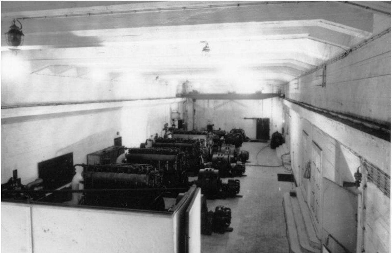
Vue de la salle des groupes électrogènes diesel depuis la fenêtre du bureau situé à l'est au premier étage, photographie non datée avec les moteurs en place (Archives municipales de Lorient)
