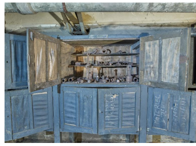
Vue du sous-sol de la salle des groupes électrogènes diesel : extrémité ouest, ensemble d'armoires d'atelier avec leurs outils et accessoires pour machine-outil Phot. Bernard Bègne IVR53_20235600797NUCA
