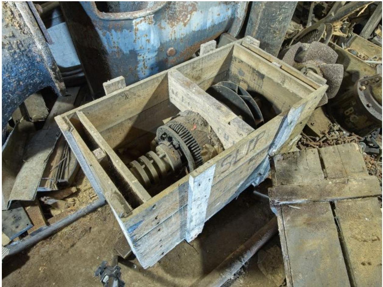
Vue du sous-sol de la centrale électrique : atelier de réparation et magasin de stockage, rotor dans sa caisse en bois de transport. La caisse est marquée SLIP et ROTOR
