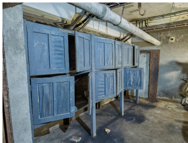
Vue du sous-sol de la salle des groupes électrogènes diesel : extrémité ouest, ensemble d'armoires d'atelier avec leurs outils et accessoires pour machine-outil Phot. Bernard Bègne IVR53_20235600796NUCA
