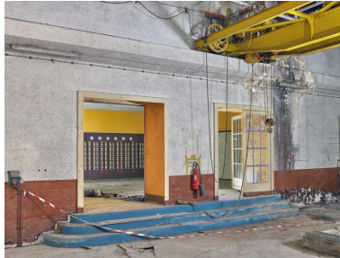
Vue des portes précédées d'un perron donnant accès à la centrale électrique depuis la salle des groupes électrogènes diesel. En haut à droite, le pont roulant d'une capacité de 5 tonnes de la salle des groupes électrogènes Phot. Bernard Bègne IVR53_20235600145NUCA
