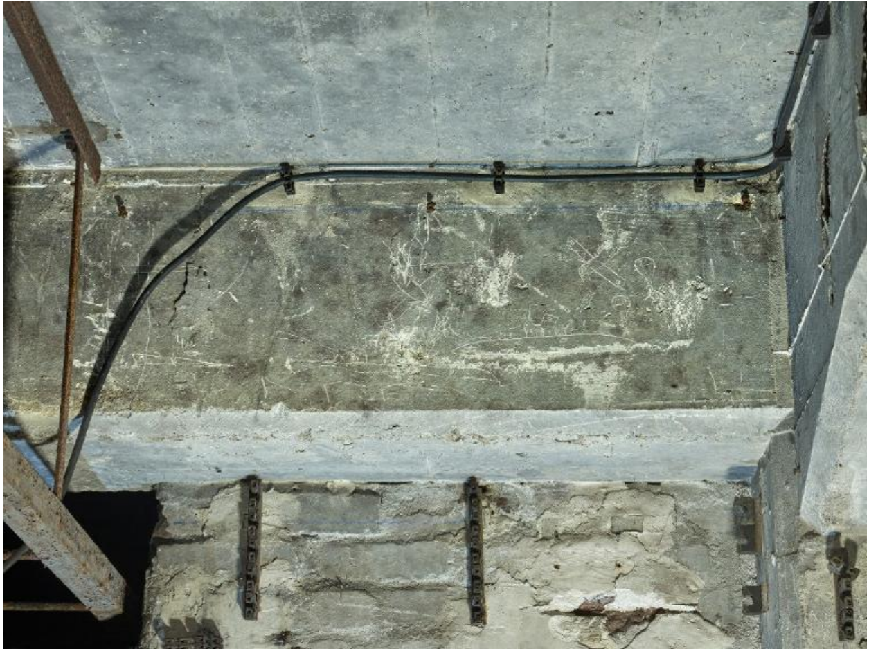
Vue du sous-sol de la centrale électrique : atelier de réparation et magasin de stockage, graffiti réalisé avec une pointe. Il représente une scène de combat entre trois sous-marins nazis et des avions alliés
