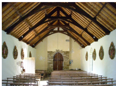
Moëlan-sur-Mer, chapelle Saint-Pierre : vue axiale ouest Phot. Gwénaél Fauchille IVR53_20082905691NUCA
