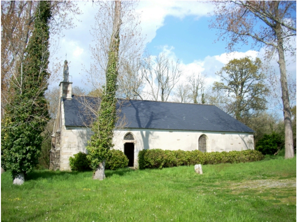
Moëlan-sur-Mer, chapelle Saint-Pierre : vue générale sud-ouest
