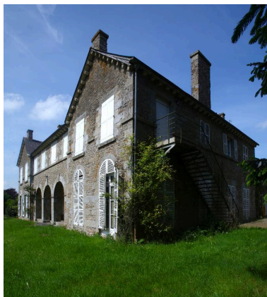
Vue sud-est Phot. Norbert Lambart IVR53_20133501170NUCA
