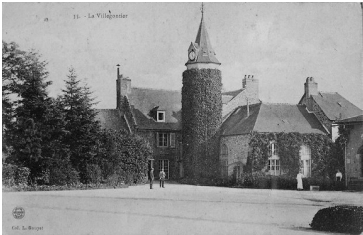
Vue sur l'arrière
