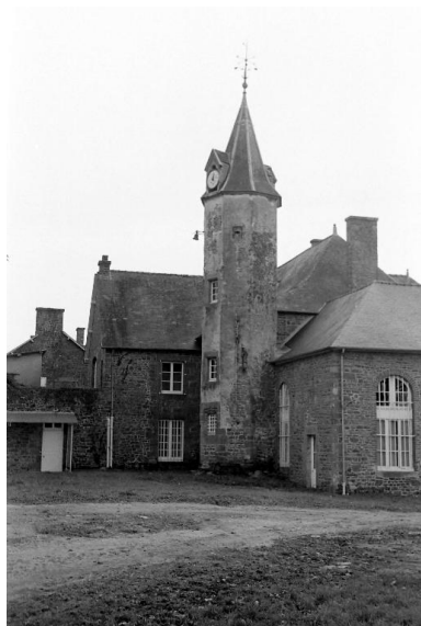
Vue arrière avec la tour Phot. Auteur inconnu IVR53_20083509014Z
