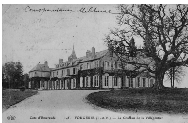
Vue de situation depuis l'arrivée Phot. Auteur inconnu IVR53_19883500459XB
