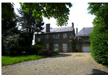
Vue est Phot. Norbert Lambart IVR53_20133501166NUCA
