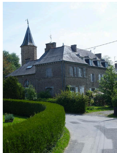
Vue sud-ouest Phot. Norbert Lambart IVR53_20133501172NUCA
