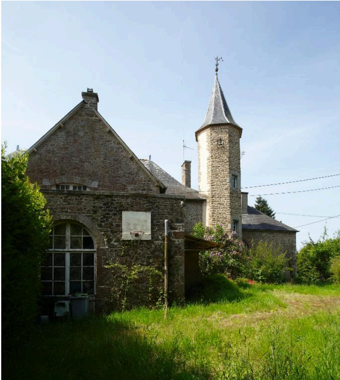
Vue sur la tour d'escalier
