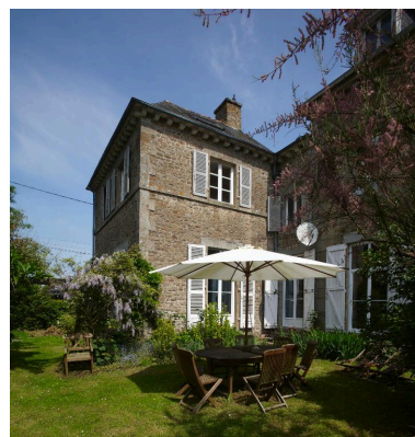
Aile en retour Phot. Norbert Lambart IVR53_20133501164NUCA
