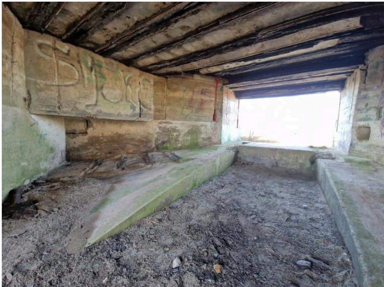
Vue intérieure : chambre de combat depuis l'entrée est. Rampes inclinées et rainures permettaient de faire monter puis de caler les roues de l'affût du canon
