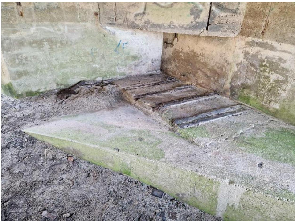
Vue intérieure : chambre de combat. Angle et rampe inclinée permettaient de caler l'une des deux flèches du canon
