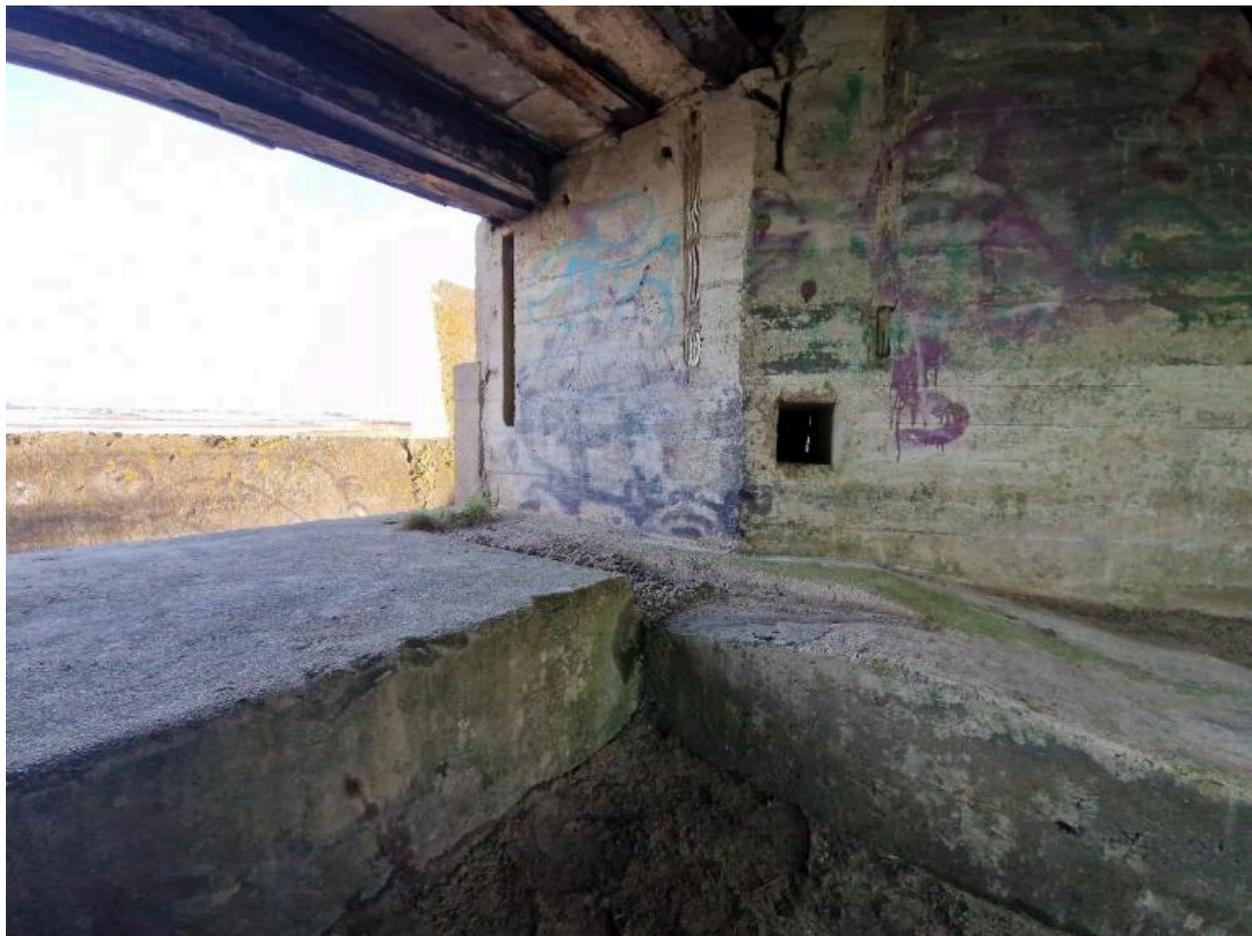
Vue intérieure : chambre de combat. Elle est reliée par une petite ouverture à la pièce servant d'observatoire avec puits de périscope. Rampes inclinées et rainures permettaient de faire monter puis de caler les roues de l'affût du canon
