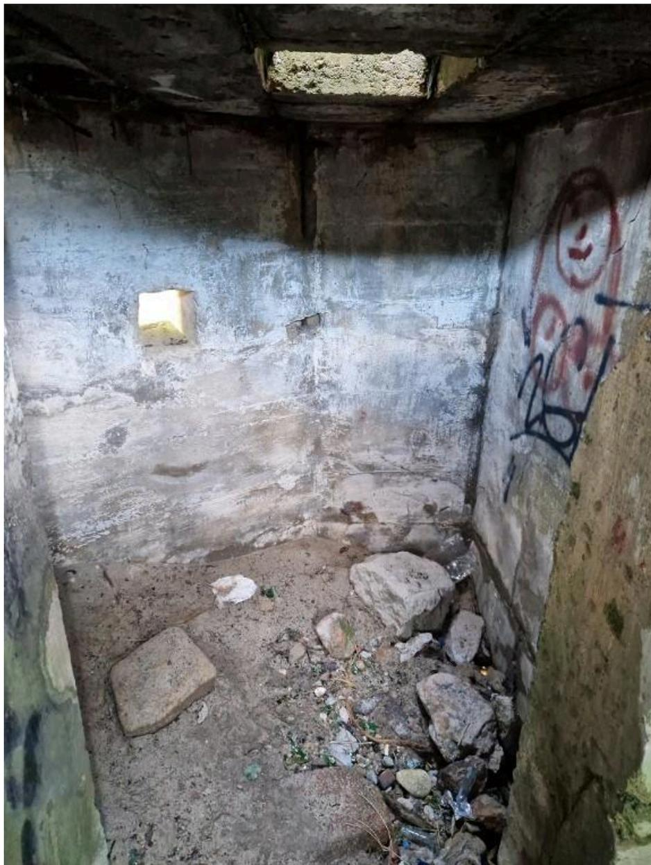
Vue intérieure : petite pièce servant d'observatoire avec puits de périscope dans la dalle de couverture
