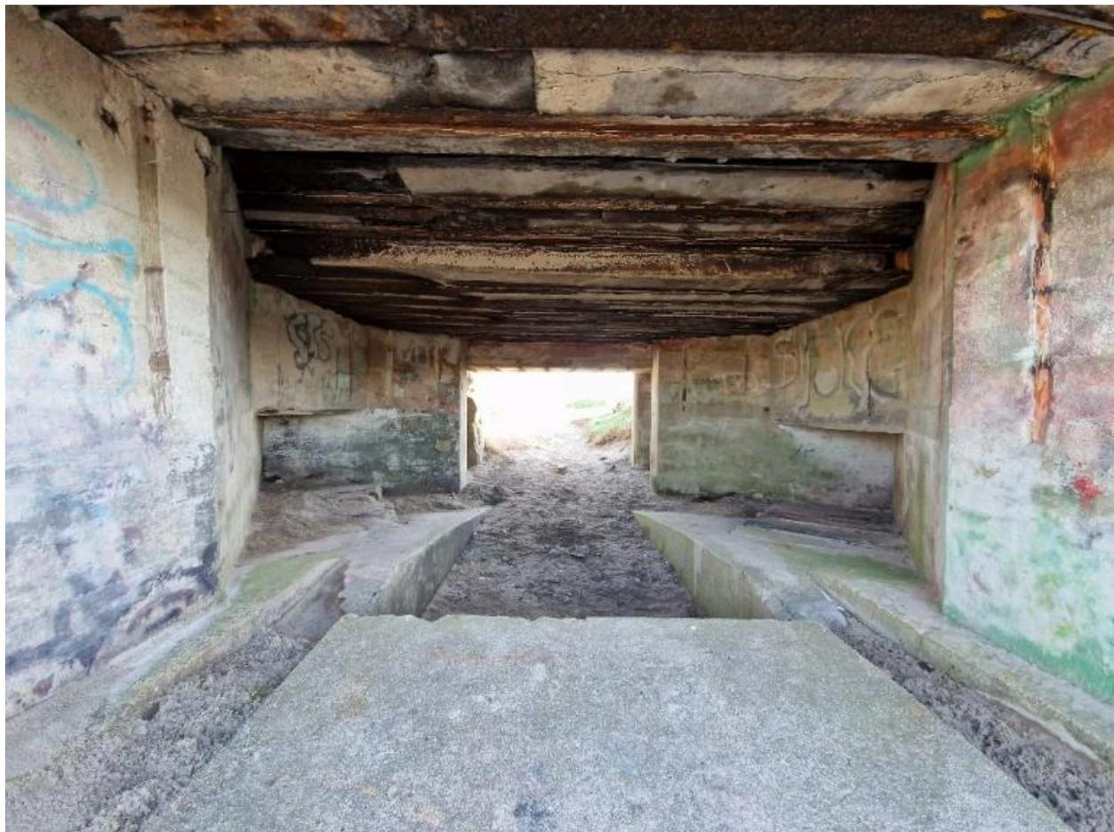
Vue intérieure : chambre de combat depuis l'embrasement ouest. Rampes inclinées et rainures permettaient de faire monter puis de caler les roues de l'affût du canon
