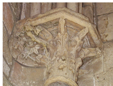
Petit porche sud : détail du chapiteau sur le pilier nord-ouest Phot. Claude Quillivic IVR53_19983502422NUCA
