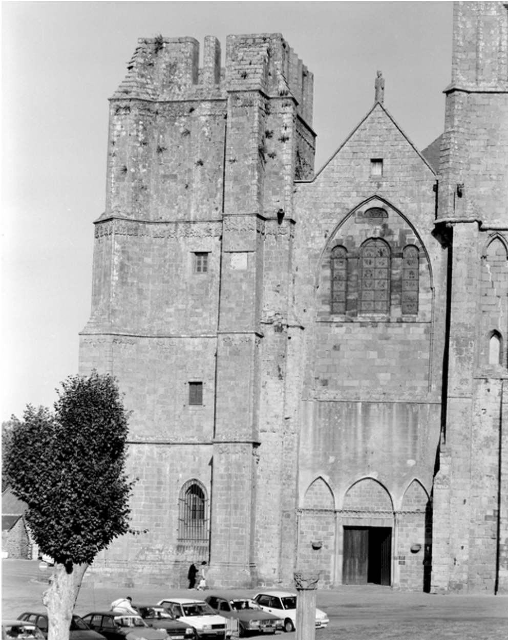
Tour occidentale nord : vue générale
