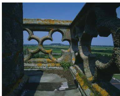
Garde-corps à quadrilobes ; le Mont-Dol à l'horizon Phot. Bernard Bègne IVR53_19993501645XA
