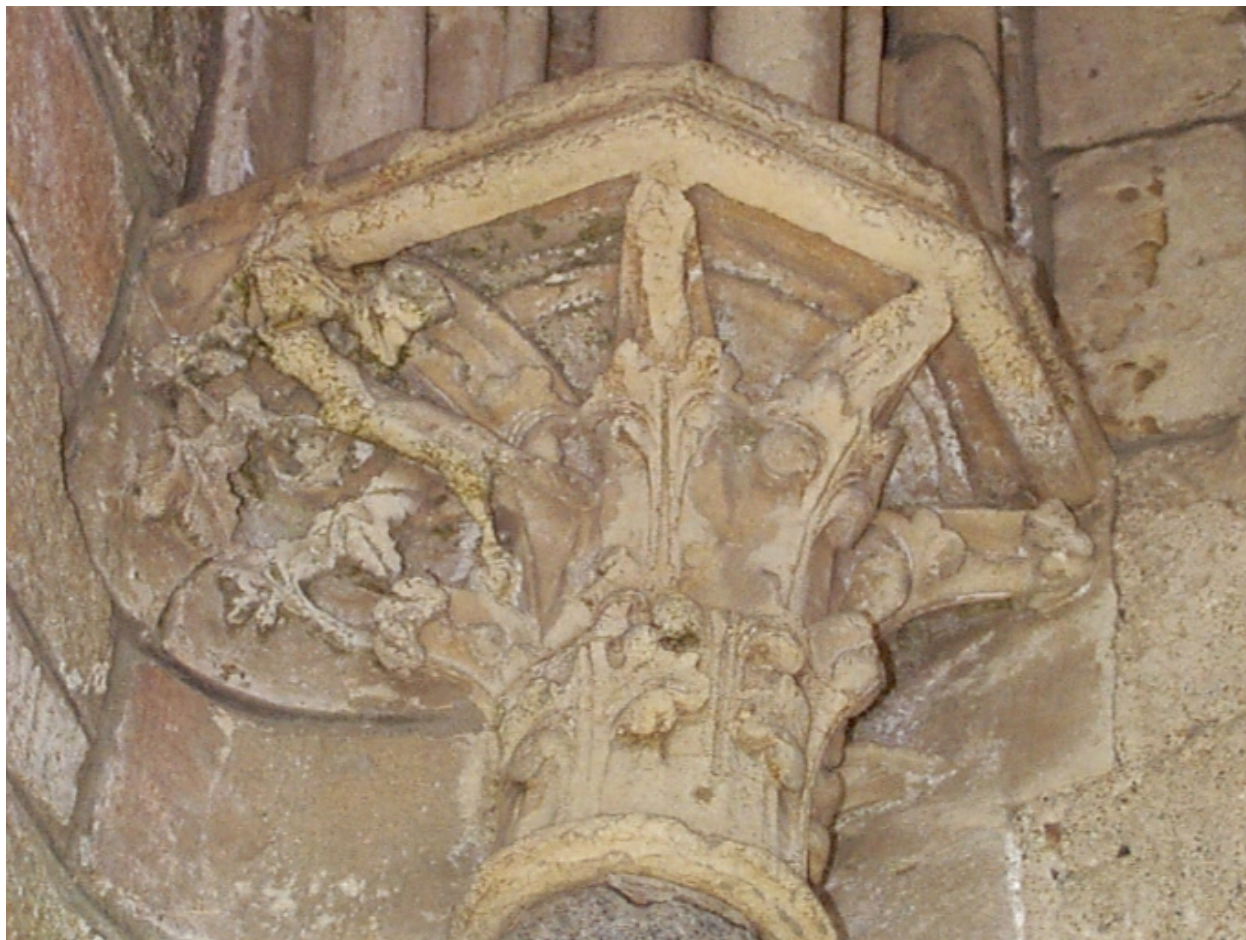
Petit porche sud : détail du chapiteau sur le pilier nord-ouest
