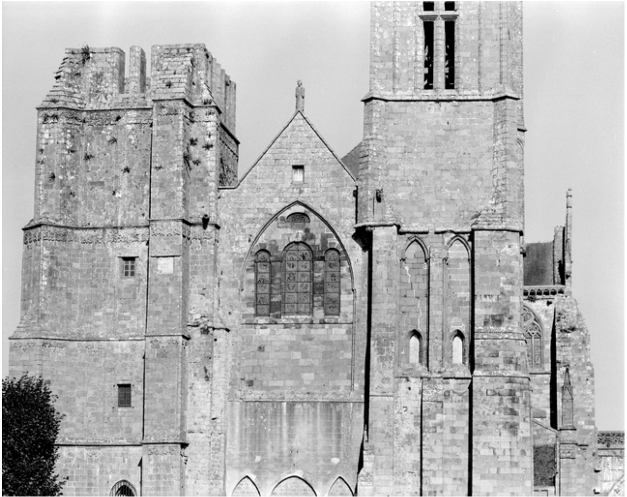
Façade ouest : deuxième niveau
