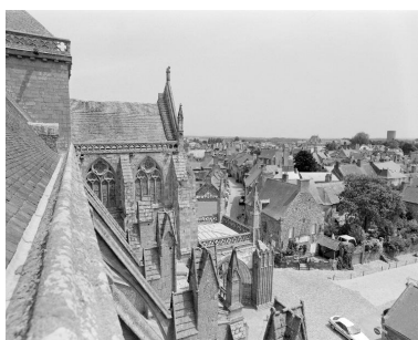
Élévation sud, face à la ville : vue partielle Phot. Bernard Bègne IVR53_19993501709X
