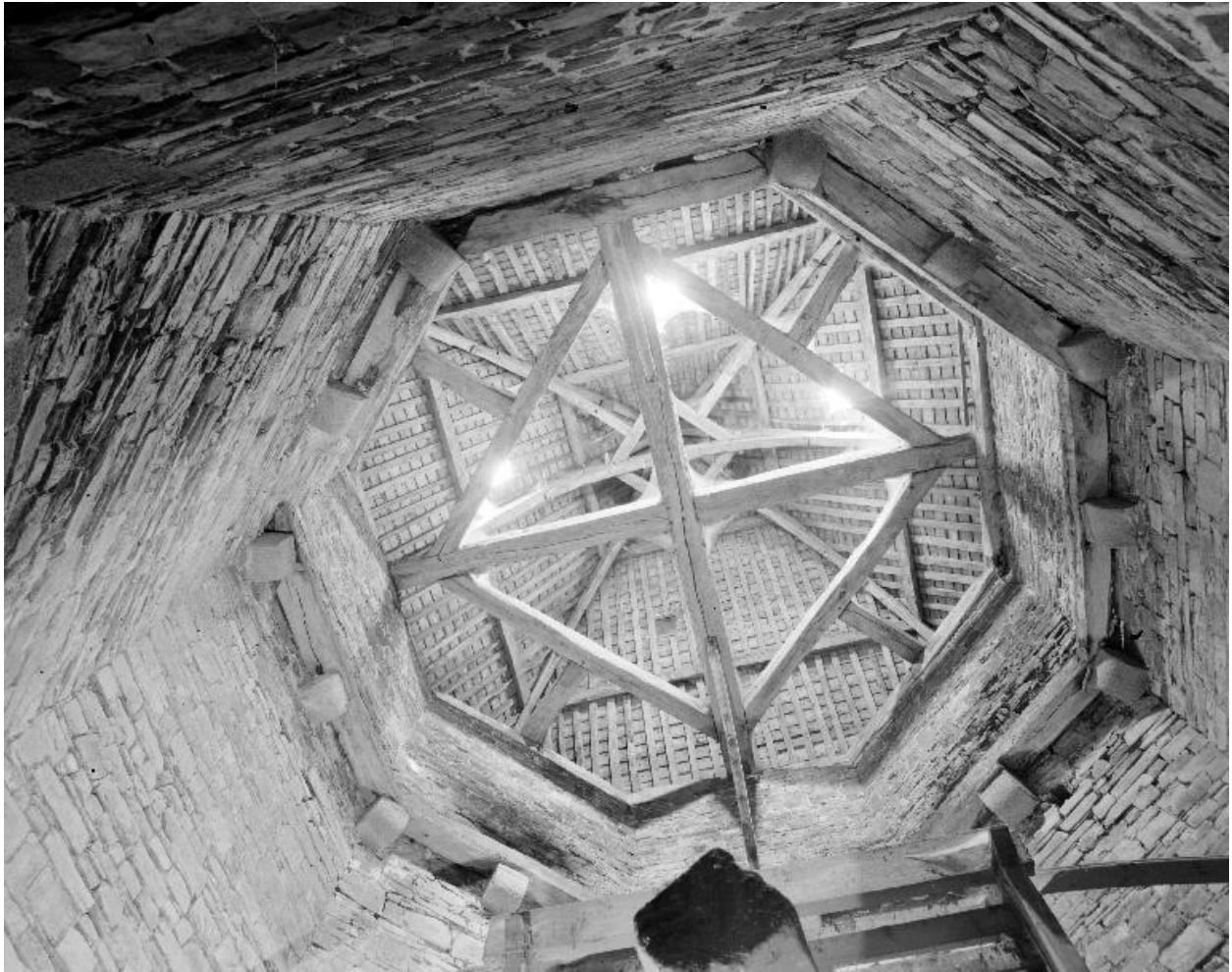
Tour centrale, détail de la charpente
