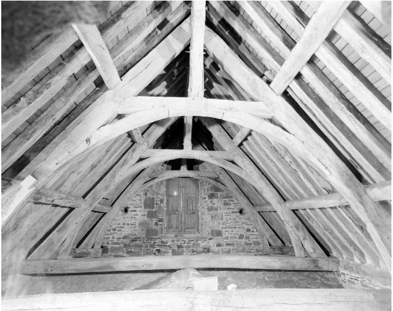
Transept sud, détail de la charpente
