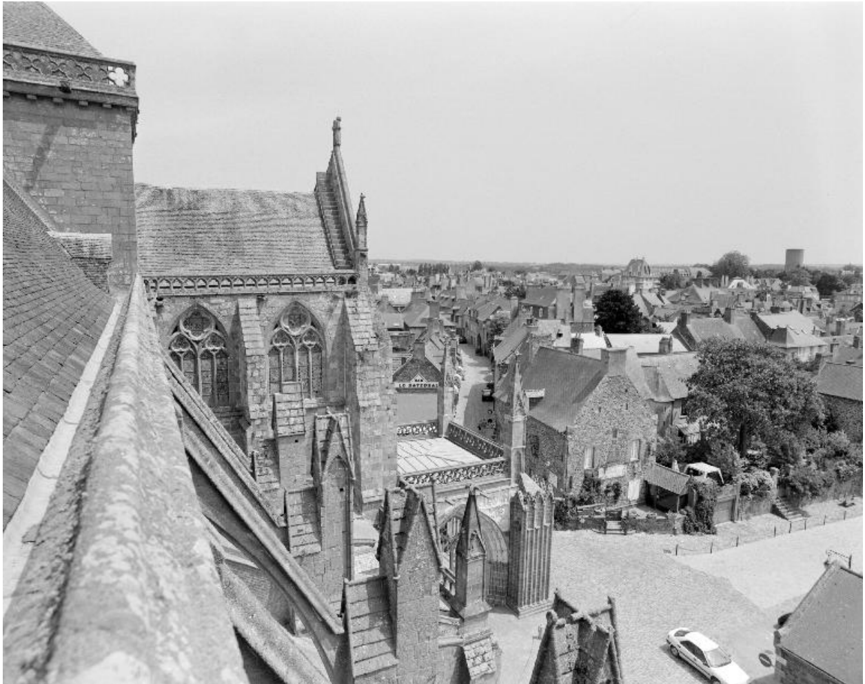
Elévation sud, face à la ville : vue partielle
