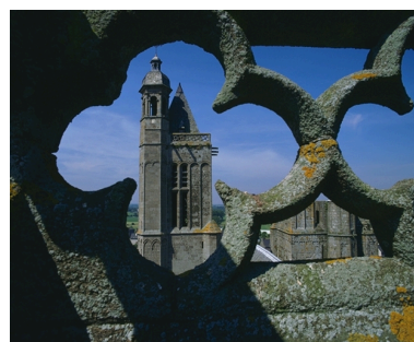
Tour occidentale sud au travers d'un quadrilobe Phot. Bernard Bègne IVR53_19993501699XA
