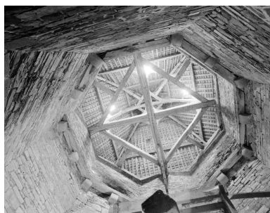
Tour centrale, détail de la charpente Phot. Bernard Bègne IVR53_19993501724X
