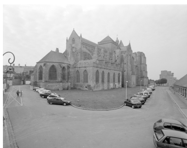
Vue générale nord-est Phot. Guy Artur, Phot. Norbert Lambart IVR53_19943501885X
