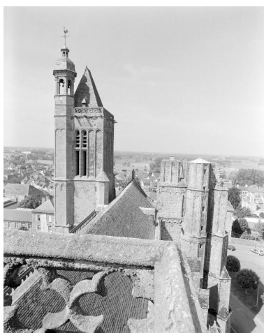
Tours occidentales vues depuis l'est Phot. Bernard Bègne IVR53_19993501700X
