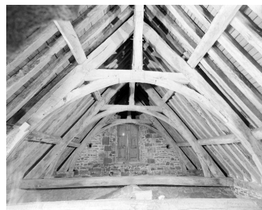
Transept sud, détail de la charpente Phot. Bernard Bègne IVR53_19993501723X
