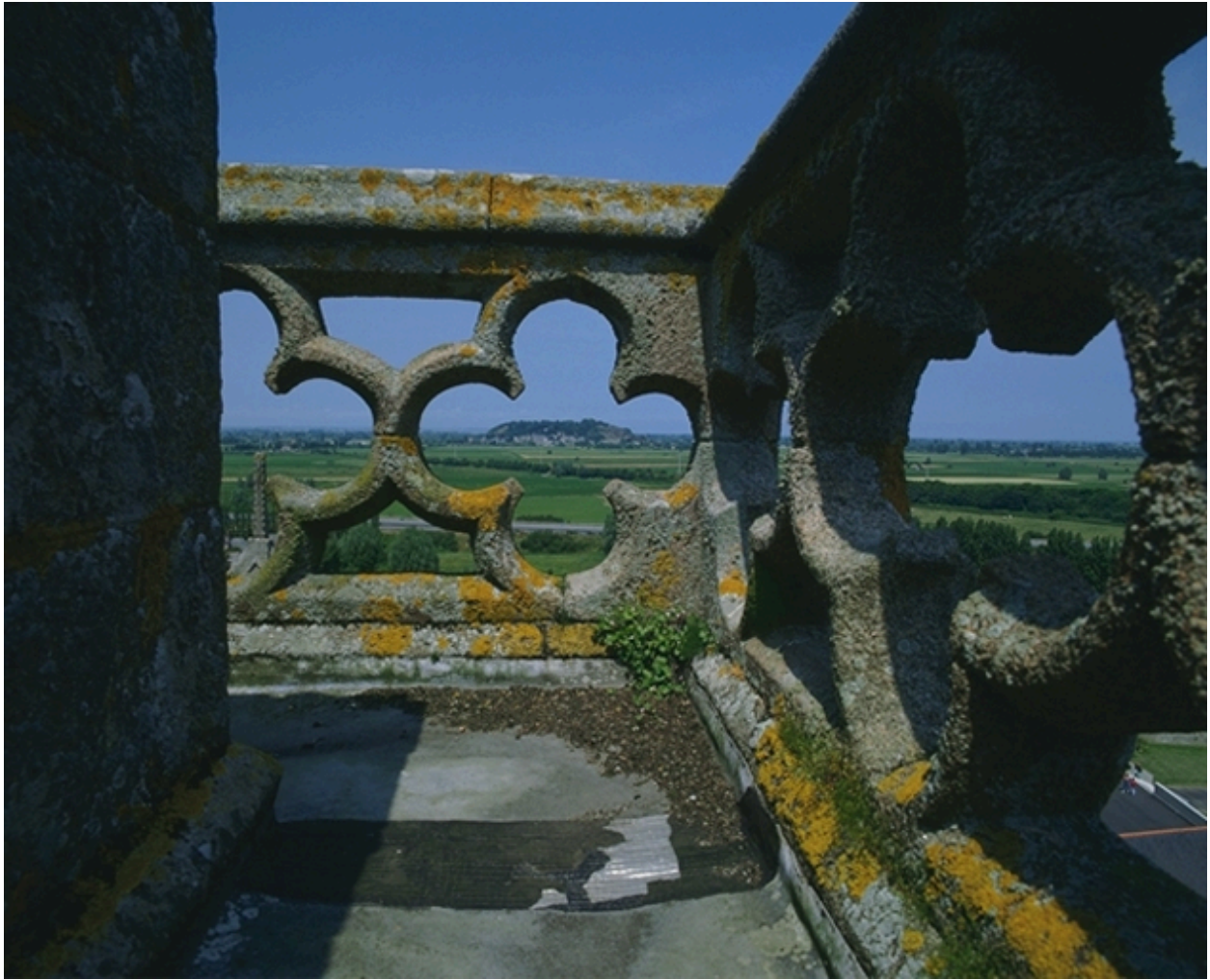
Garde-corps à quadrilobes ; le Mont-Dol à l'horizon
