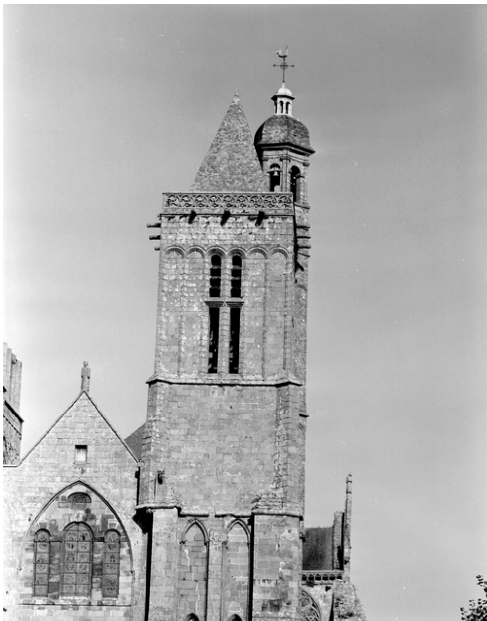
Tour occidentale sud : détail
