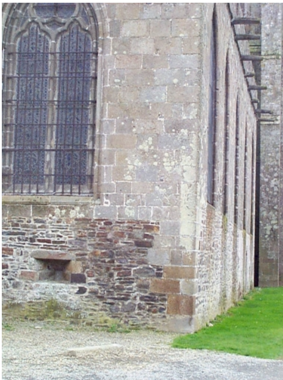
Canonnière sur la structure défensive au nord-est du chevet de la cathédrale
