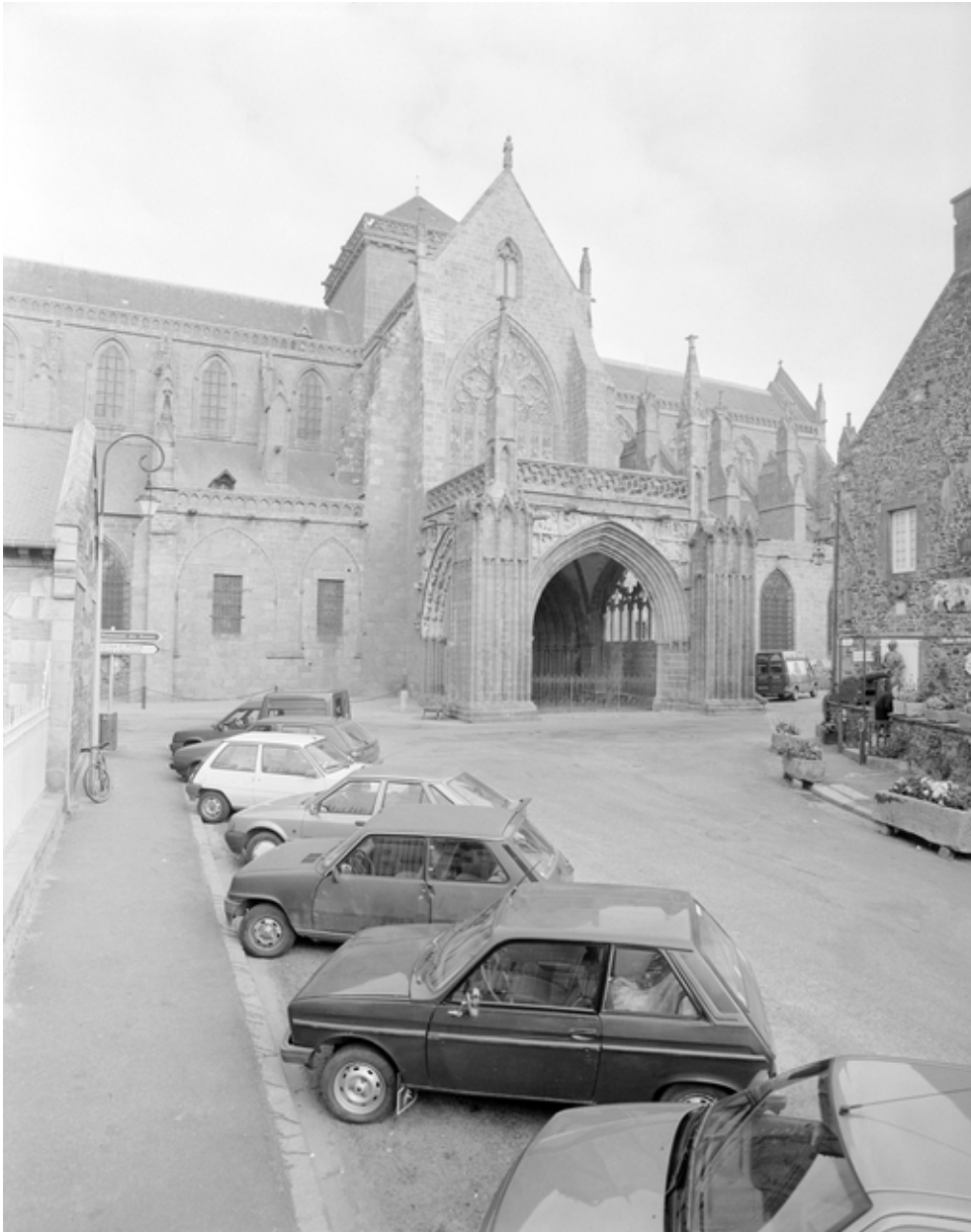
Elévation sud : grand porche
