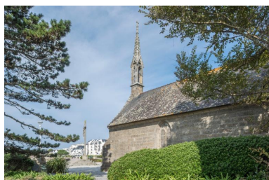
Chapelle Notre-Dame-de- Bon-Secours, élévation sud Phot. Charlotte Barraud IVR53_20242901259NUCA
