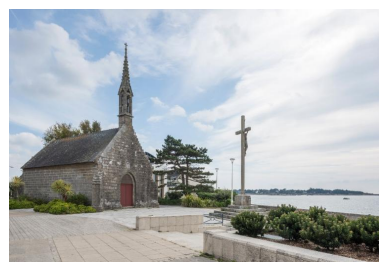
La chapelle Notre-Dame-de-Bon- Secours et la croix monumentale Phot. Charlotte Barraud IVR53_20242901261NUCA
