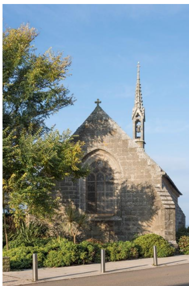
Chapelle Notre-Dame-de- Bon-Secours, élévation est Phot. Charlotte Barraud IVR53_20242901258NUCA
