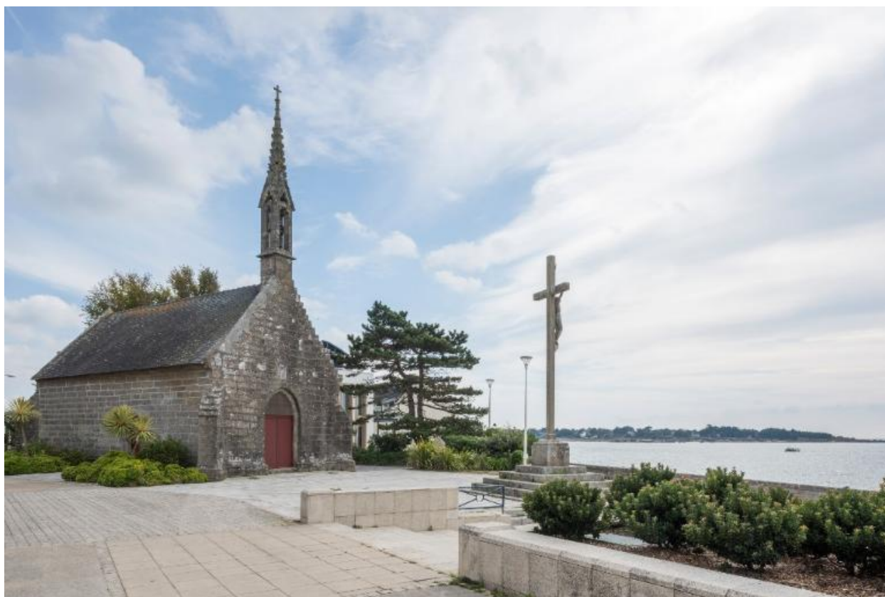
La chapelle Notre-Dame-de-Bon-Secours et la croix monumentale
