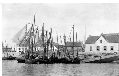
Le port de la Croix, l'abri du marin et la chapelle Phot. Archives départementales du Finistère, Autr. Villard IVR53_20242910404NUCB
