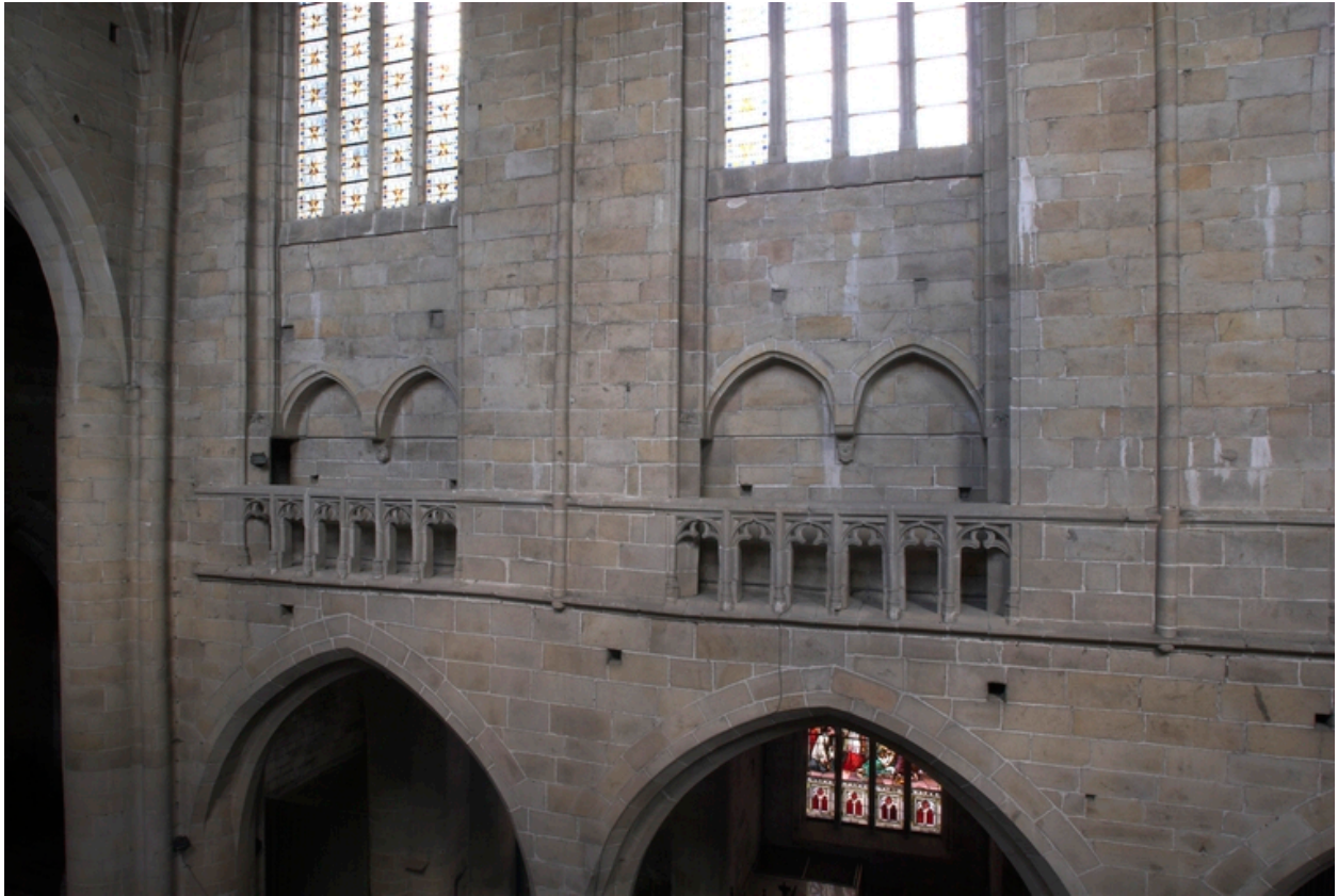
Vue du triforium du choeur
