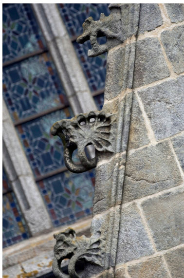
Détail d'un pignon d'une chapelle du chœur Phot. Norbert Lambart IVR53_20072200181NUCA
