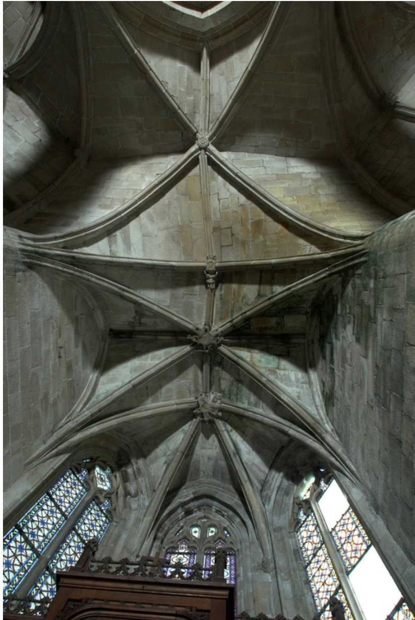
Voûtes du déambulatoire du choeur et de la chapelle d'axe.
