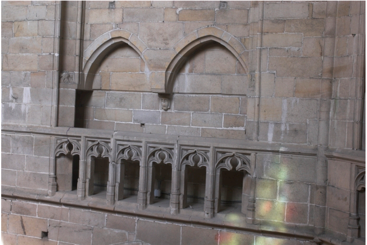
Vue du triforium du choeur
