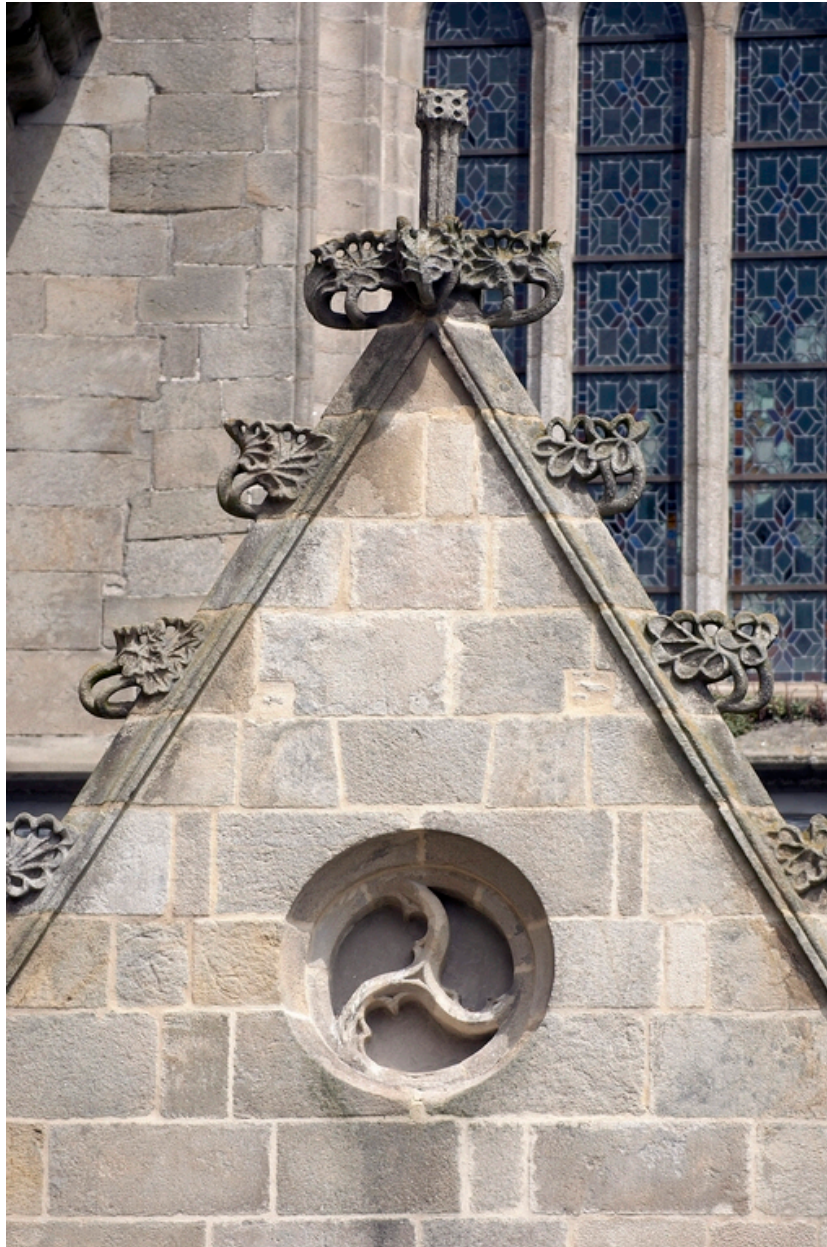
Détail du pignon de la première chapelle sud du choeur
