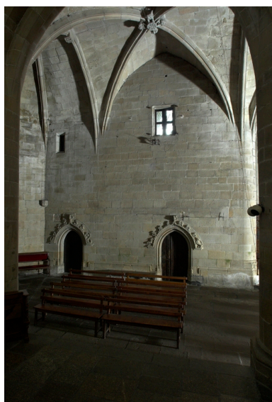
Déambulatoire du chœur, travée de la sacristie et de la trésorerie Phot. Norbert Lambart IVR53_20072200273NUCA
