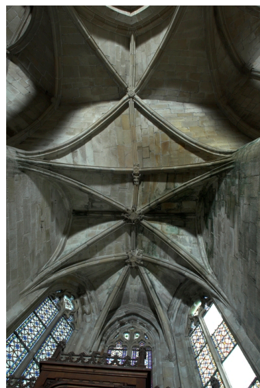
Voûtes du déambulatoire du choeur et de la chapelle d'axe. Phot. Bernard Bègne IVR53_20072200272NUCA
