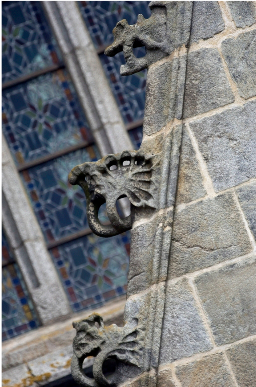
Détail d'un pignon d'une chapelle du choeur
