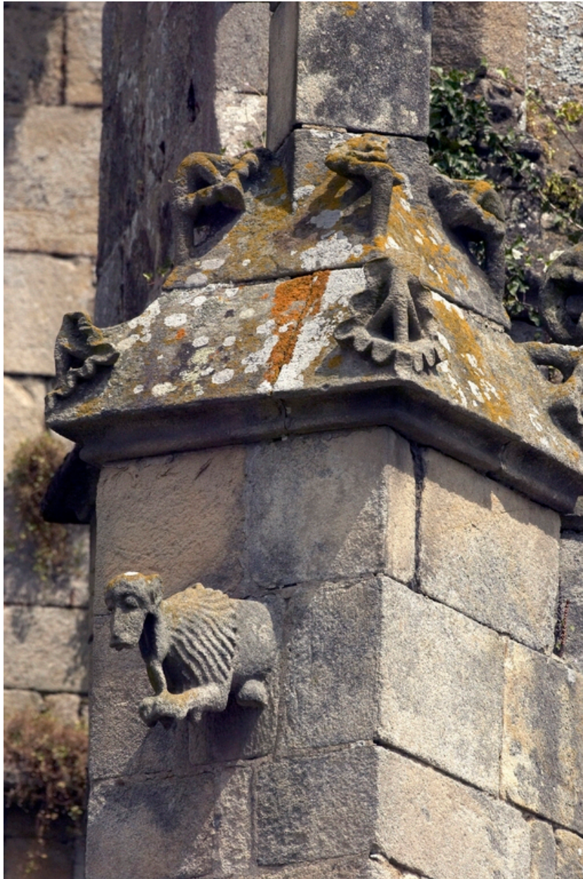
Détail contrefort ouest de la sacristie
