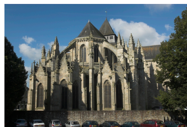
Vue générale du chevet Phot. Bernard Bègne IVR53_20072200256NUCA
