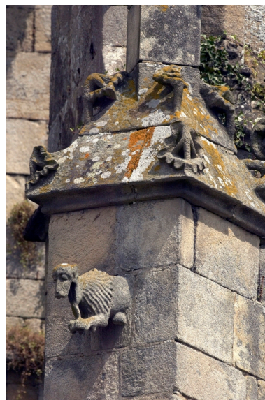
Détail contrefort ouest de la sacristie Phot. Norbert Lambart IVR53_20072200180NUCA
