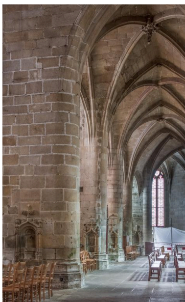
Déambulatoire du choeur côté nord avec l'enfilade des chapelles Phot. Delia Gaulin-Crespel IVR53_20192200595NUCA
