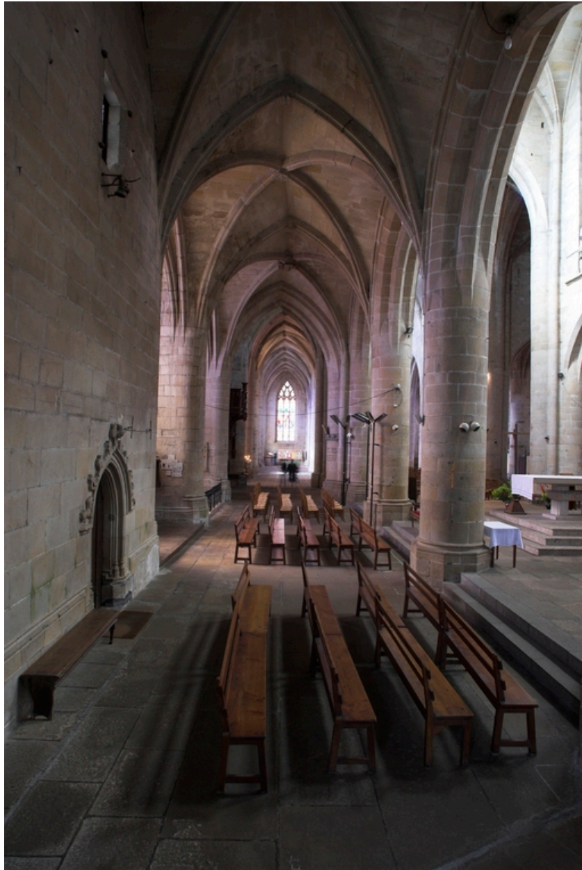
Déambulatoire du choeur, côté sud
