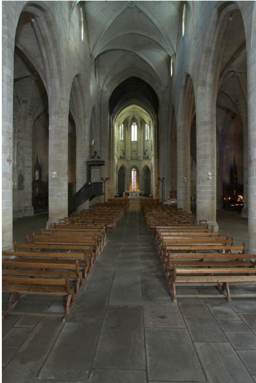
Intérieur, vue axiale depuis le bas de la nef
