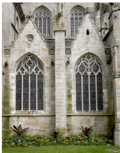
Travées droites du choeur depuis le sud Phot. Norbert Lambart IVR53_20072200173NUCA
