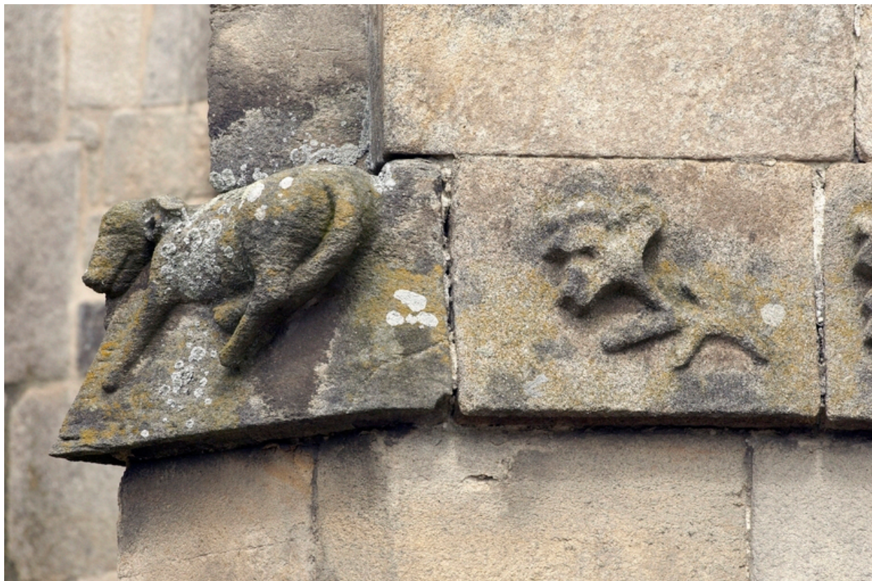
Détail de sculpture d'un des contreforts du chevet
