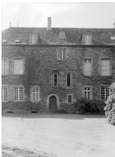
Face nord : travée avec porte Phot. Guy Artur IVR53_19772200020V
