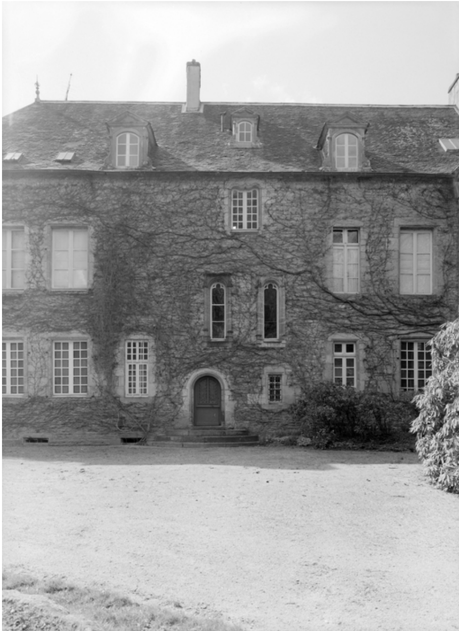
Face nord : travée avec porte
