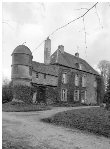
vue générale ancien corps d'entrée Phot. Guy Artur IVR53_19772200019V
