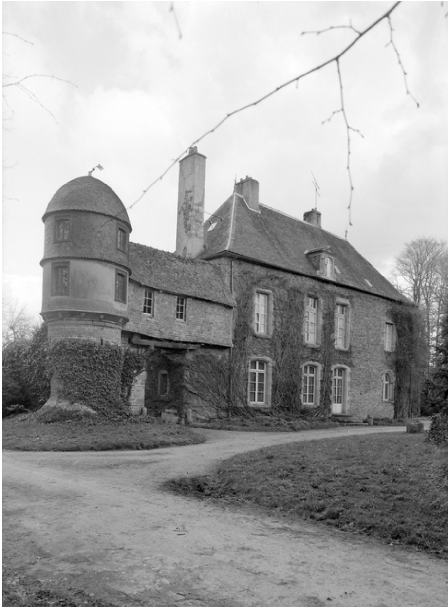
vue générale ancien corps d'entrée
