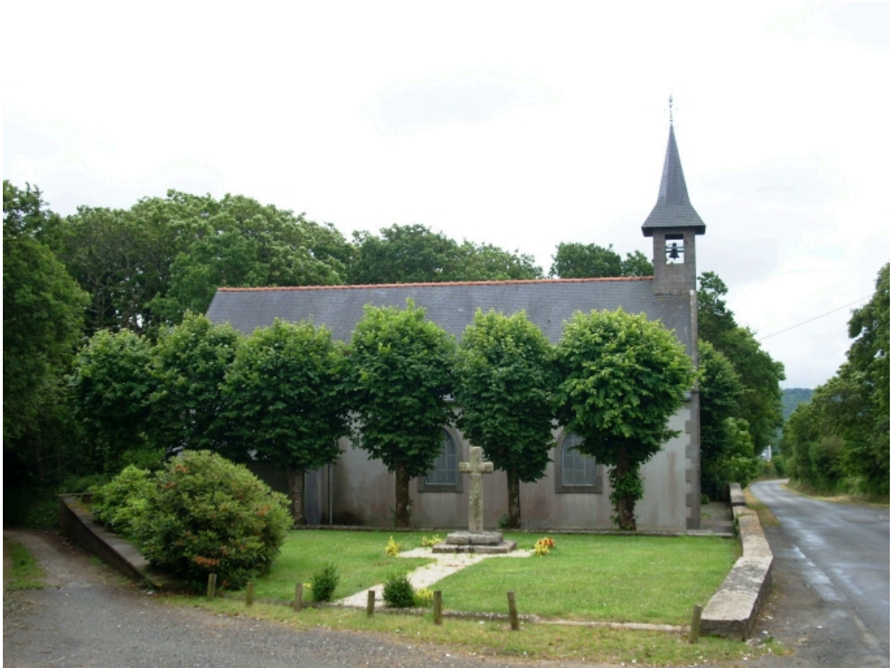
Guipavas, chapelle Saint-Yves : vue générale nord
