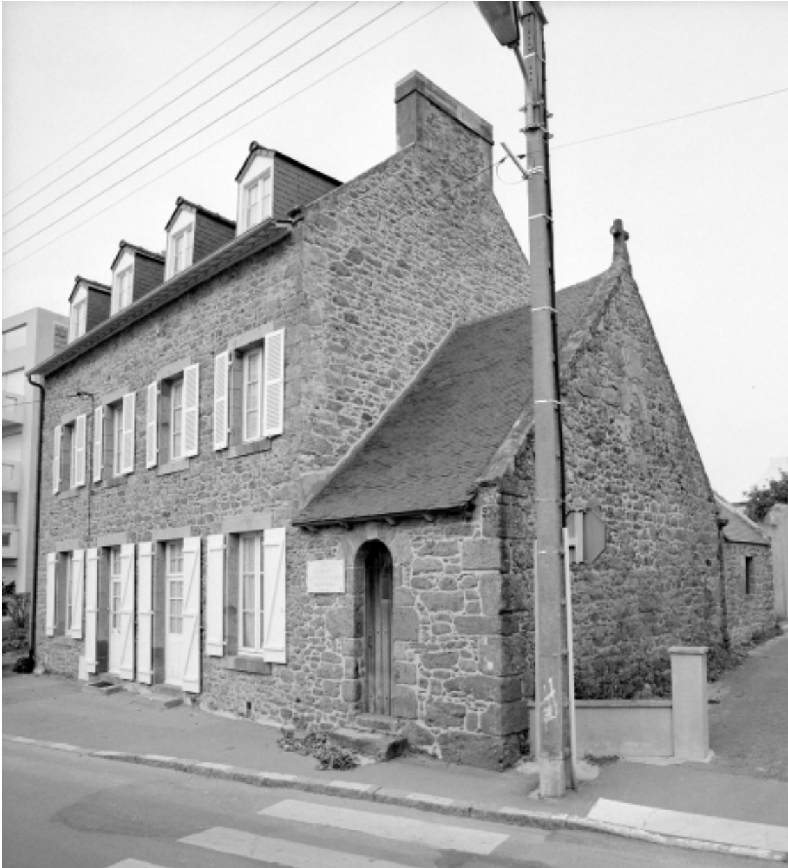
Elévation Sud : vue générale
