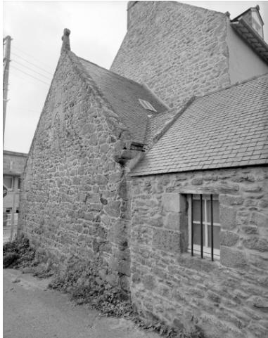
Elévation Sud-Est : vue générale Phot. Bernard Bègne, Phot. M. Loyon IVR53_19923500830X
