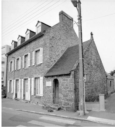
Elévation Sud : vue générale Phot. Bernard Bègne, Phot. M. Loyon IVR53_19923500832X
