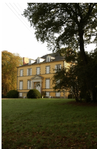
Vue de situation sud-ouest Phot. Norbert Lambart IVR53_20053503048NUCA
