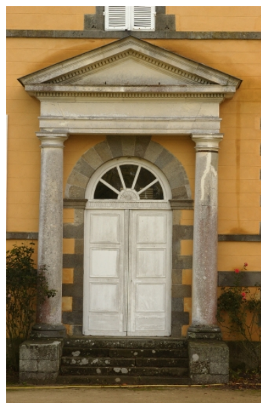
Elévation ouest : détail du porche d'entrée Phot. Norbert Lambart IVR53_20053503047NUCA
