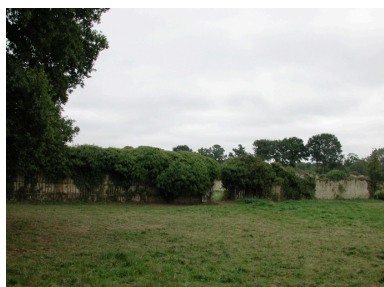
Mur de clôture de l'ancien jardin potager Phot. Elise Lauranceau IVR53_20053519902NUCA
