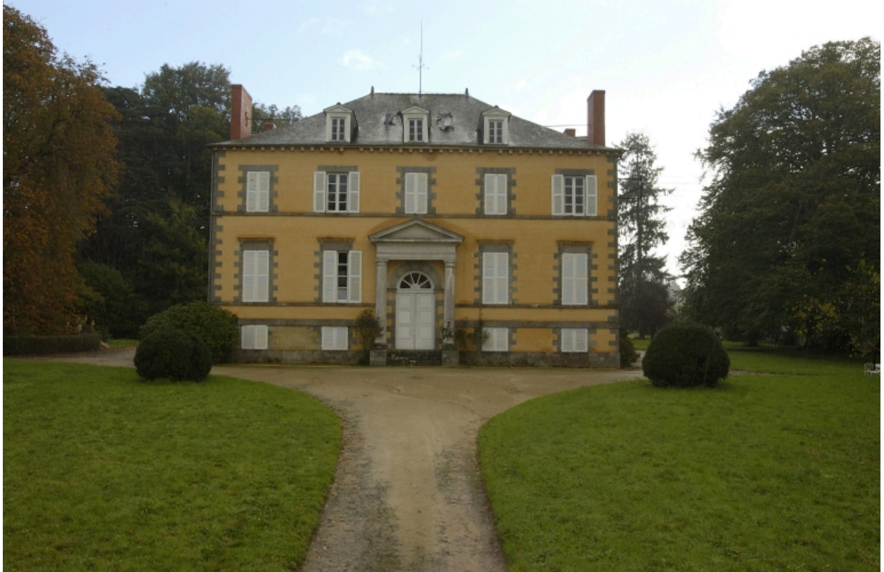
Elévation ouest : vue générale
