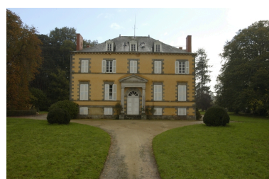
Elévation ouest : vue générale Phot. Norbert Lambart IVR53_20053503146NUCA
