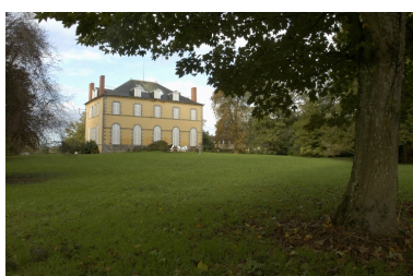
Vue de situation est Phot. Norbert Lambart IVR53_20053503148NUCA
