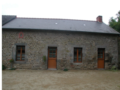
Ferme ; détail du corps de logis remanié en 1931 Phot. Elise Lauranceau IVR53_20053519906NUCA
