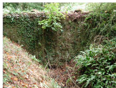
Ponceau au nord-ouest du site Phot. Elise Lauranceau IVR53_20053519903NUCA
