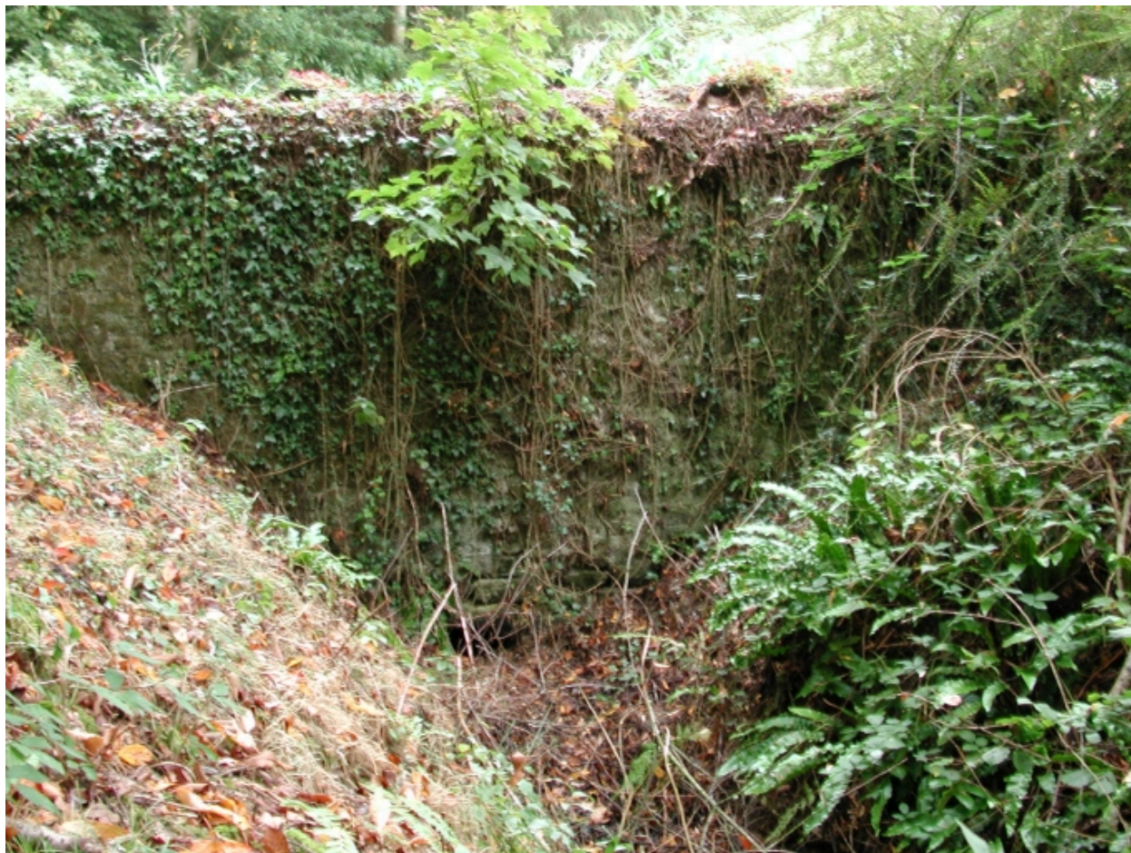
Ponceau au nord-ouest du site
