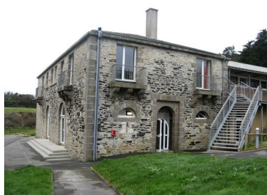
Vue générale du fort de Postolonec Phot. Guillaume Marie IVR53_20072908896NUCA
