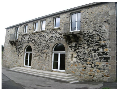
Vue arrière du fort de Postolonec Phot. Guillaume Marie IVR53_20072908894NUCA
