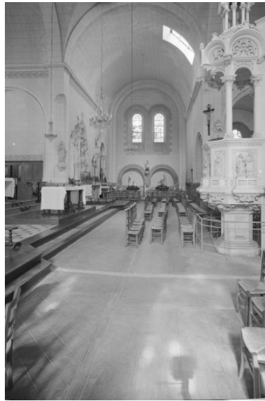
Intérieur, chœur : vue générale. Phot. Gaudin IVR53_19703500178V
