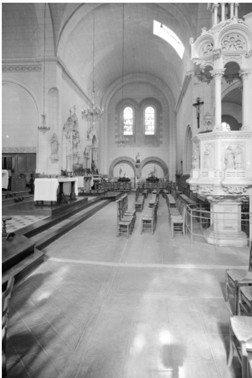
Intérieur, bras Nord du transept : vue générale.
