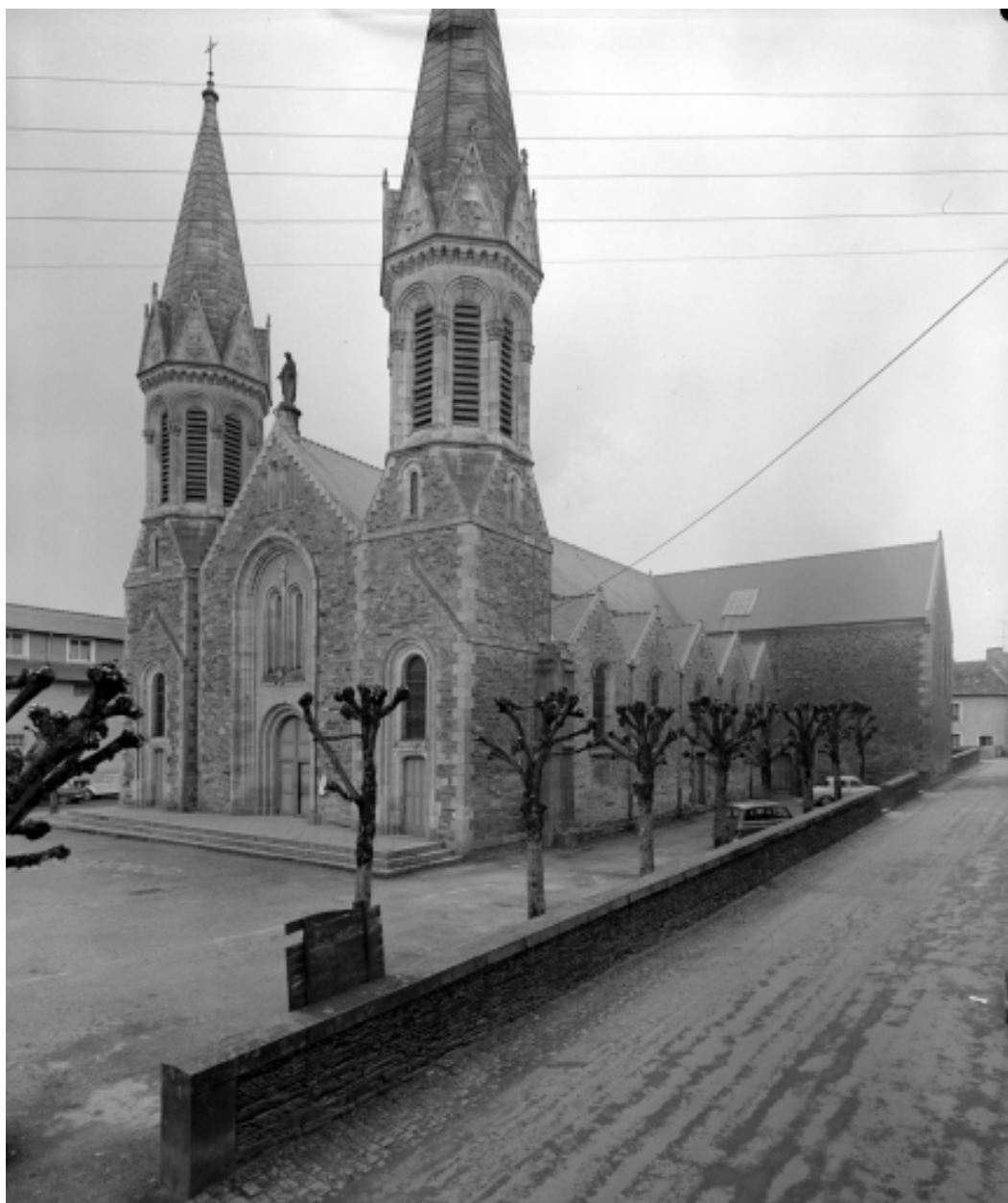
Elévation Nord-Est : vue générale
