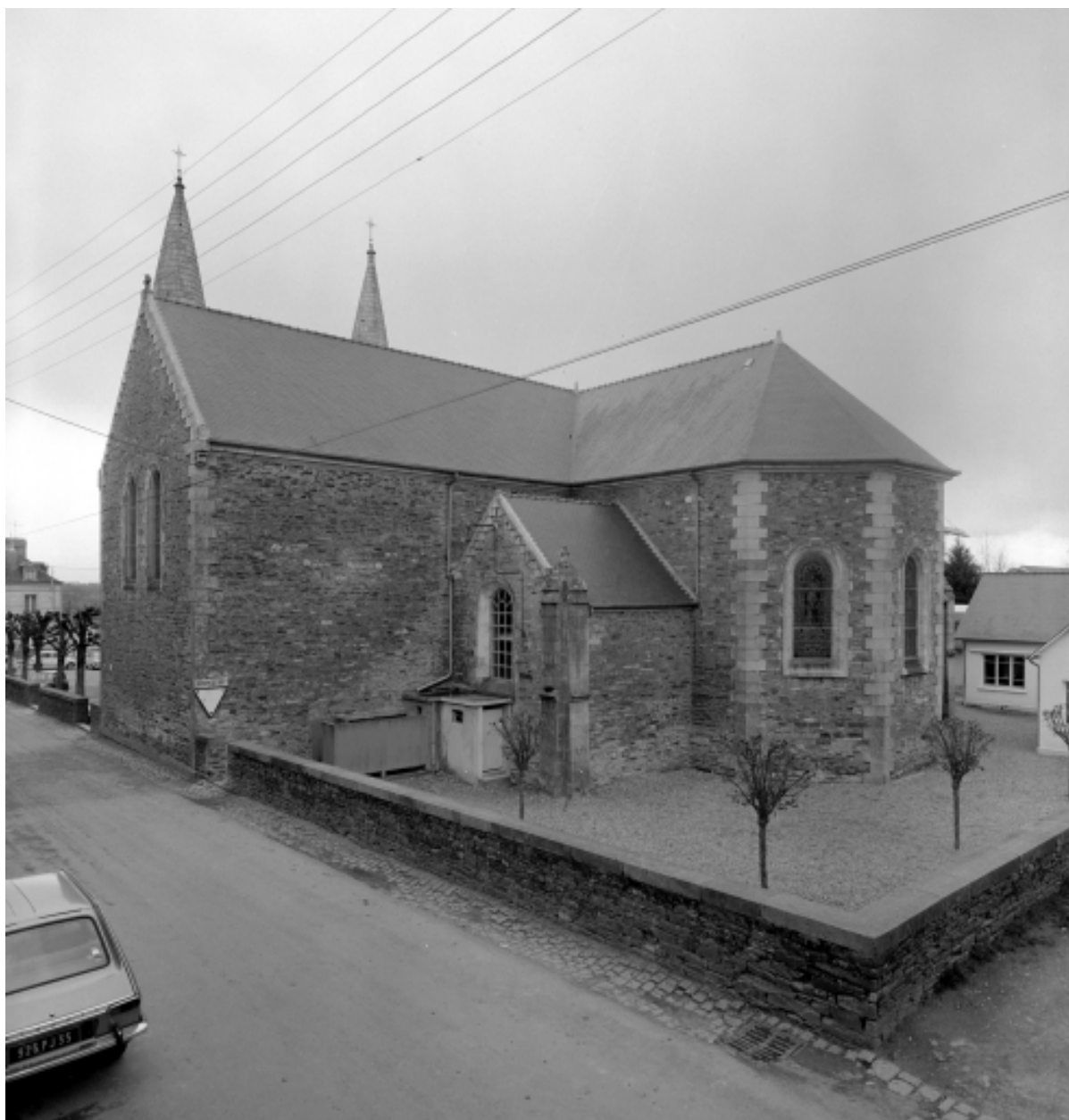
Elévation Nord-Ouest : vue générale
