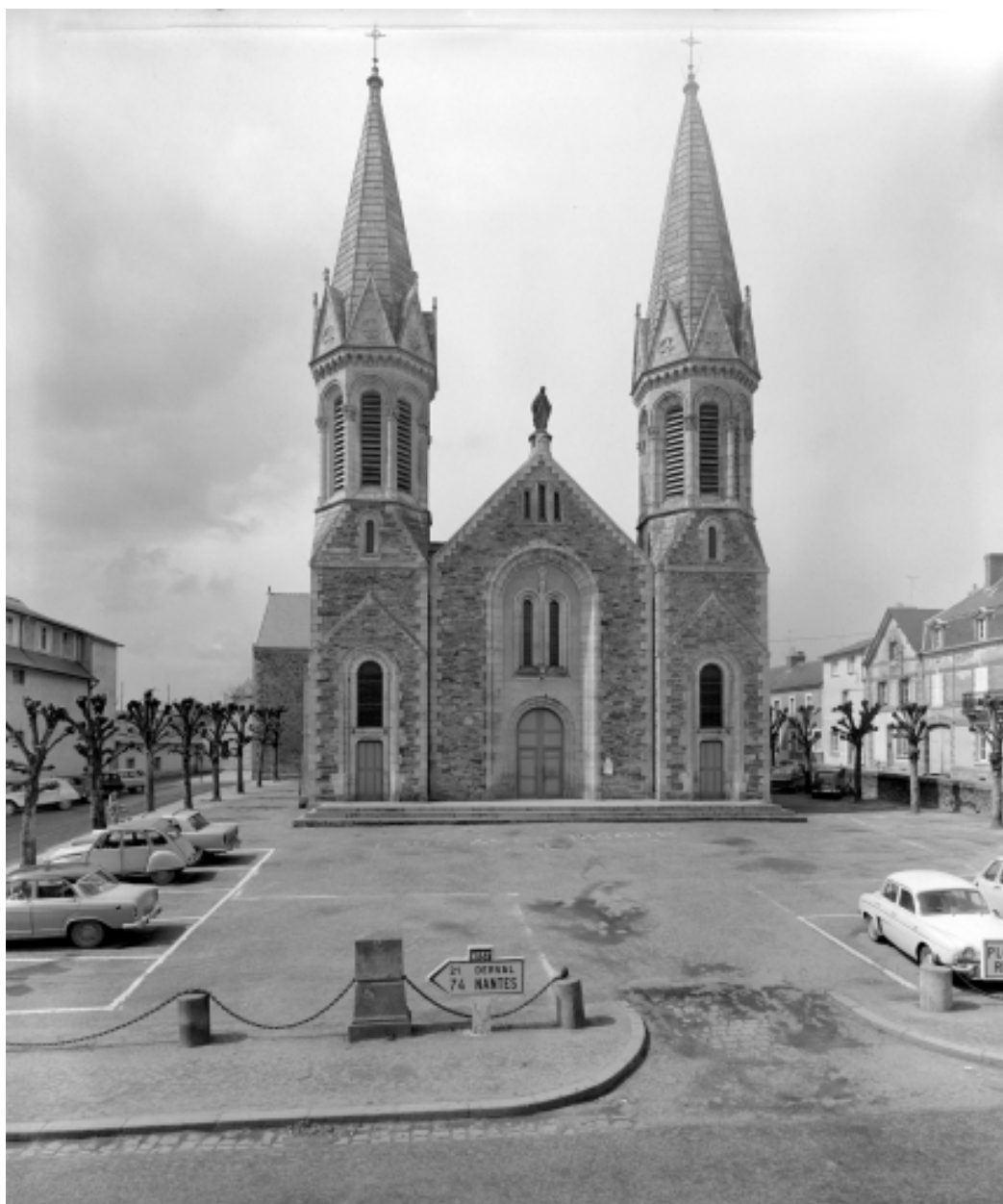
Elévation Est : vue générale
