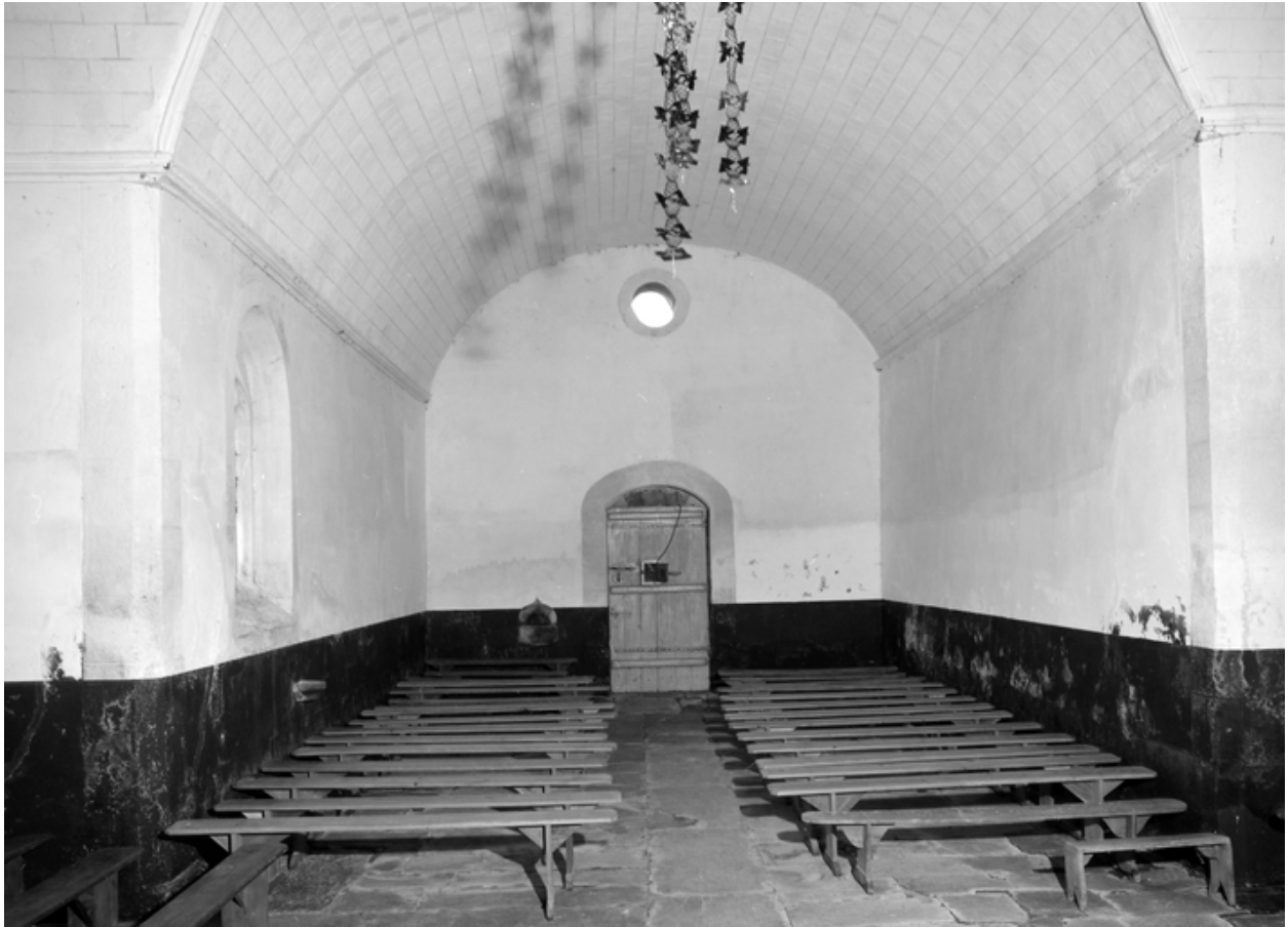
Vue intérieure vers l'ouest
