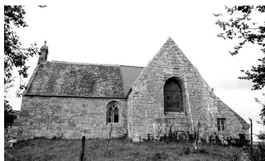
Élévation sud Phot. Gérard Lefort IVR53_19665600728Z
