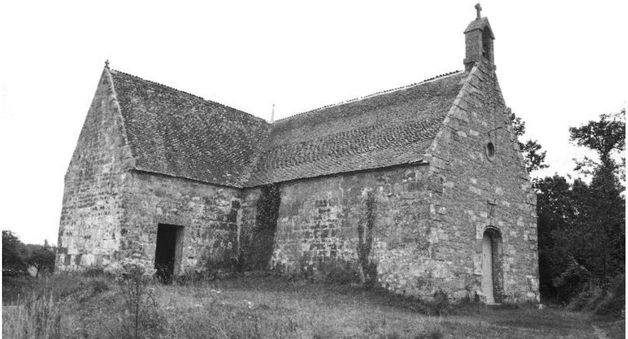
Vue d'ensemble prise du nord-ouest
