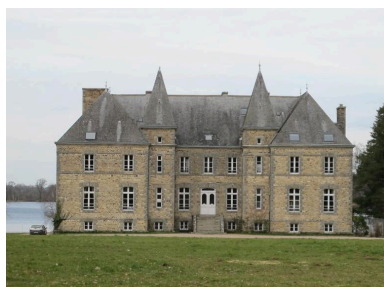
Elévation antérieure sud Phot. Stéphanie Le Lu IVR53_20135615118NUCA
