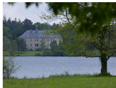
Vue de situation sur l'étang prise du nord-ouest Phot. Bernard Bègne IVR53_20135600677NUCA
