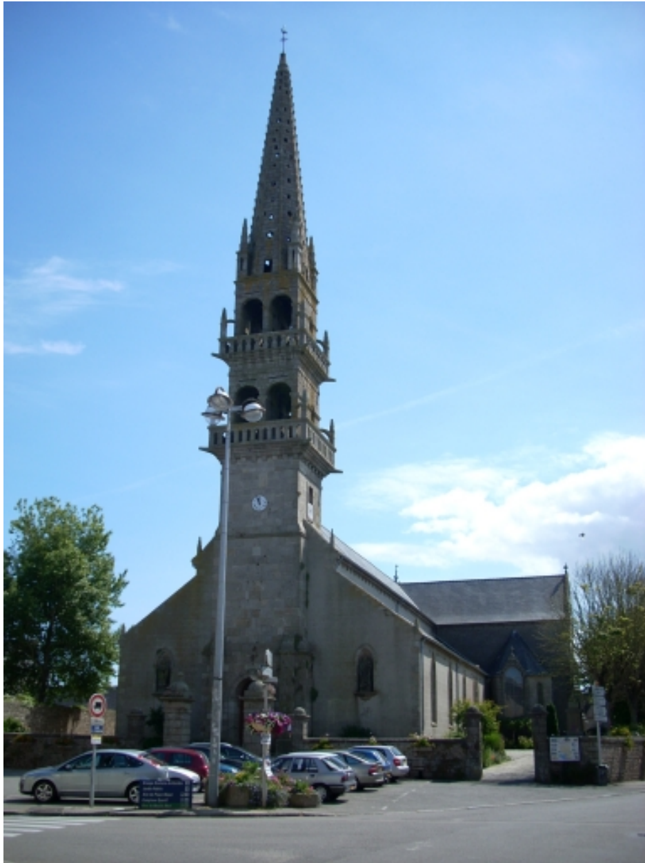
Ploudalmézeau, église paroissiale : vue générale sud-ouest
