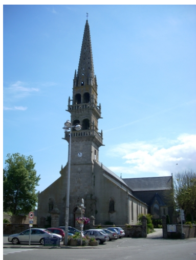
Ploudalmézeau, église paroissiale : vue générale sud-ouest Phot. Gwénaél Fauchille IVR53_20082906188NUCA
