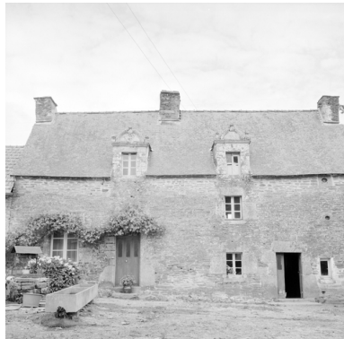
Vue d'ensemble de la façade sud Phot. Jean-Yves Veillard IVR53_19665600778X
