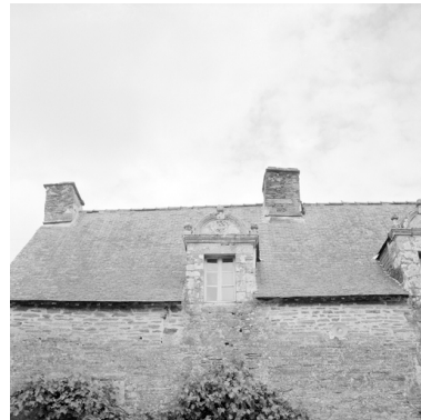
Détail de la lucarne ouest sur la façade sud Phot. Jean-Yves Veillard IVR53_19665600780X
