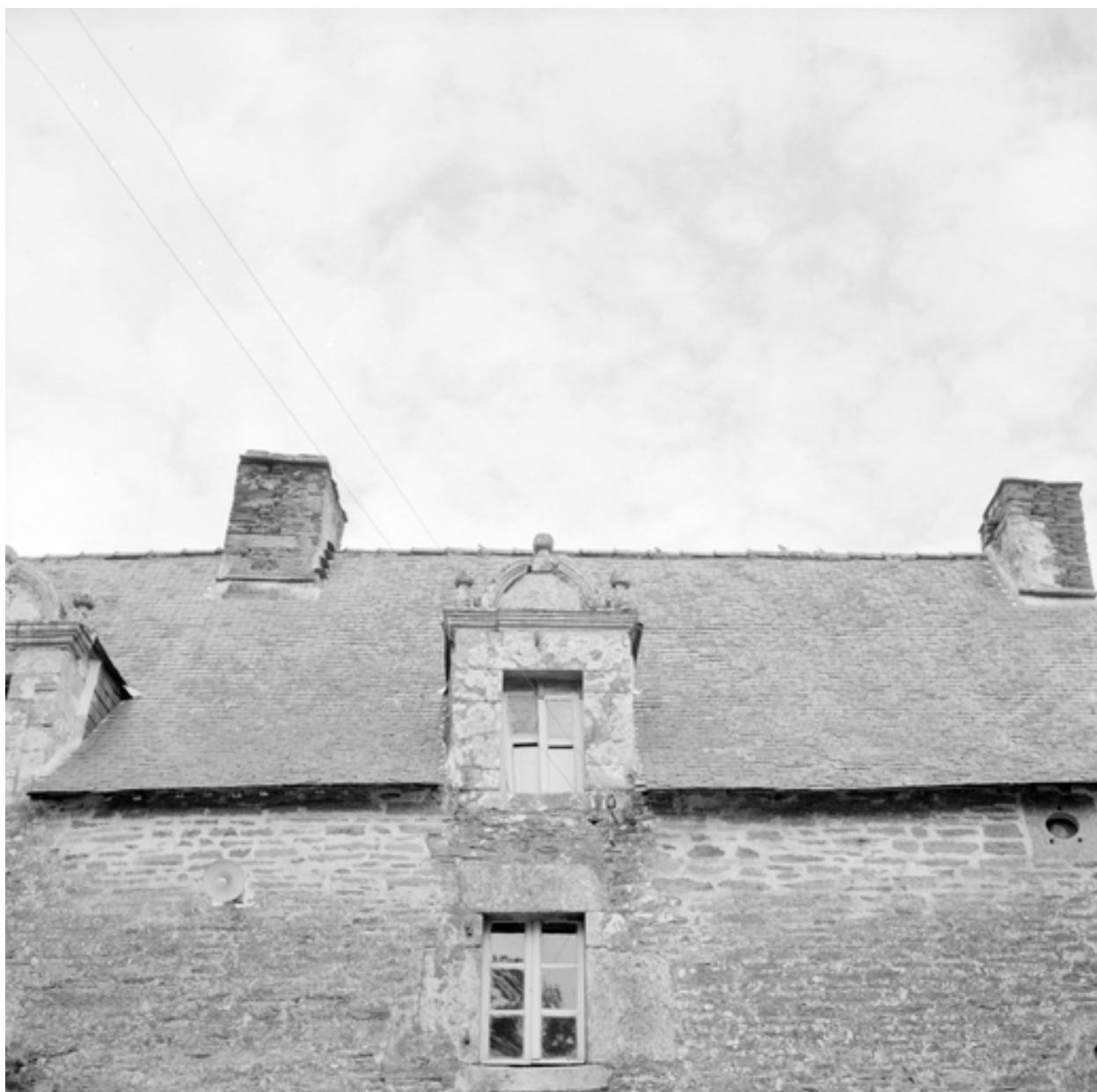
Détail de la lucarne est sur la façade sud
