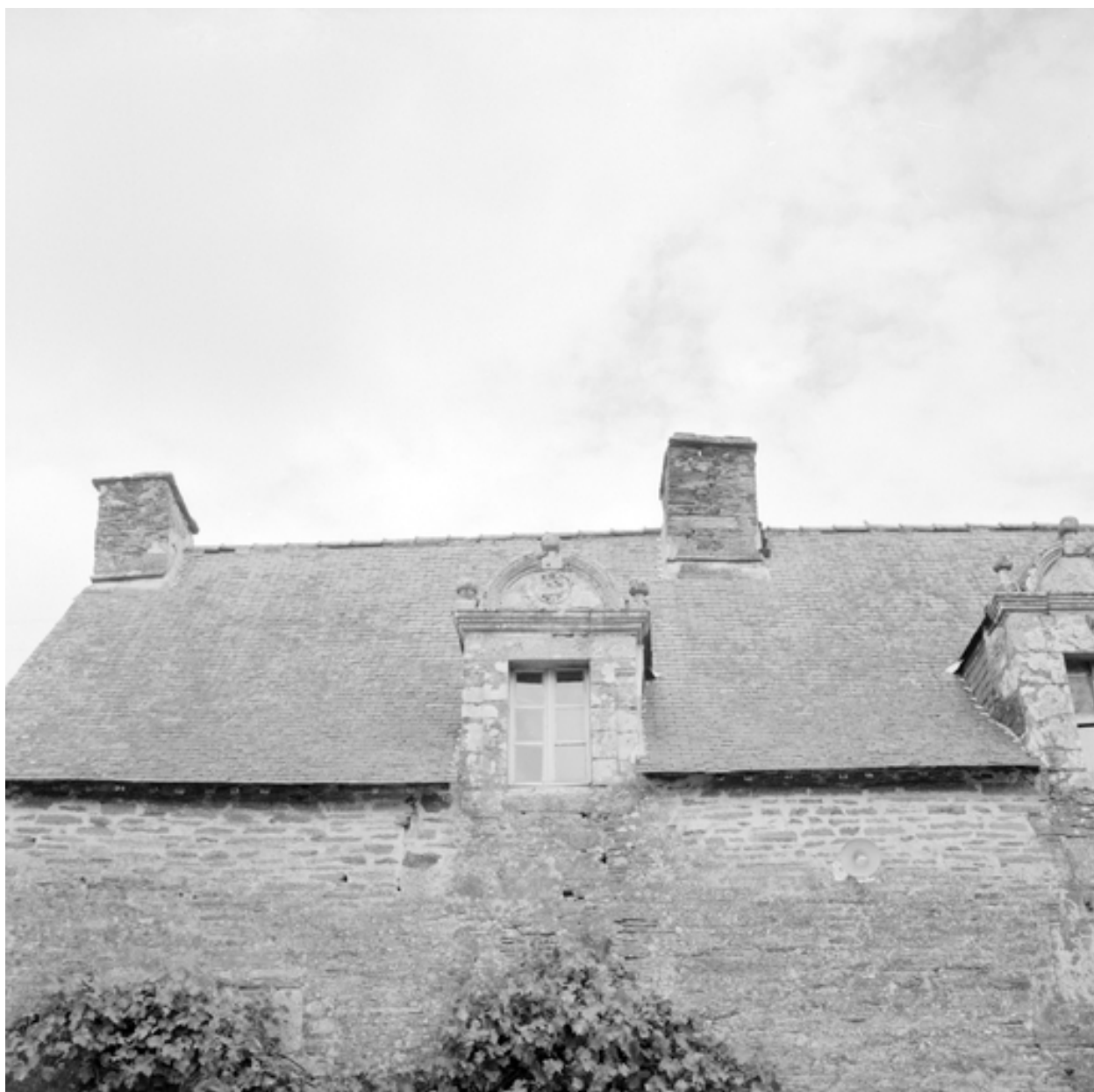
Détail de la lucarne ouest sur la façade sud
