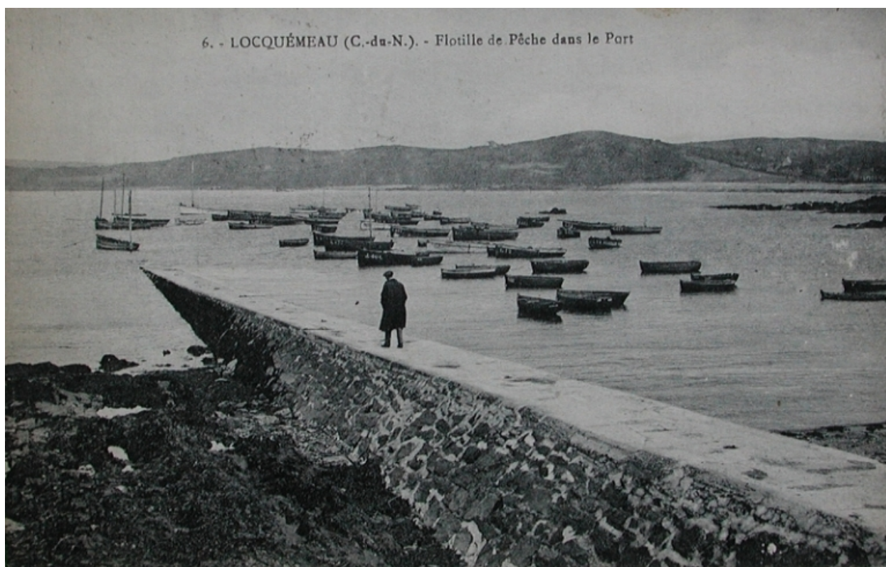
La cale rallongée avec son parement en pierres et une certaine pente
