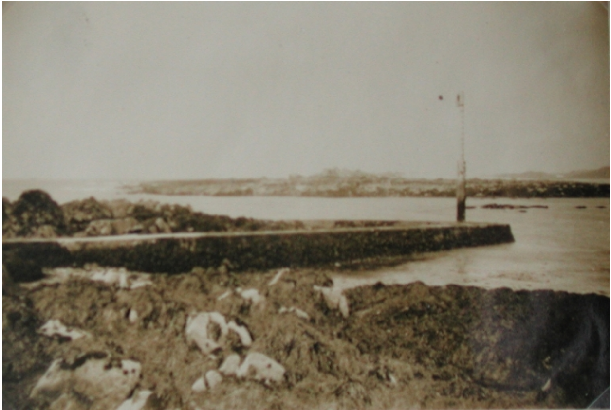
La petite cale (cale d'en bas) à marée haute, avec son feu rouge vers 1954
