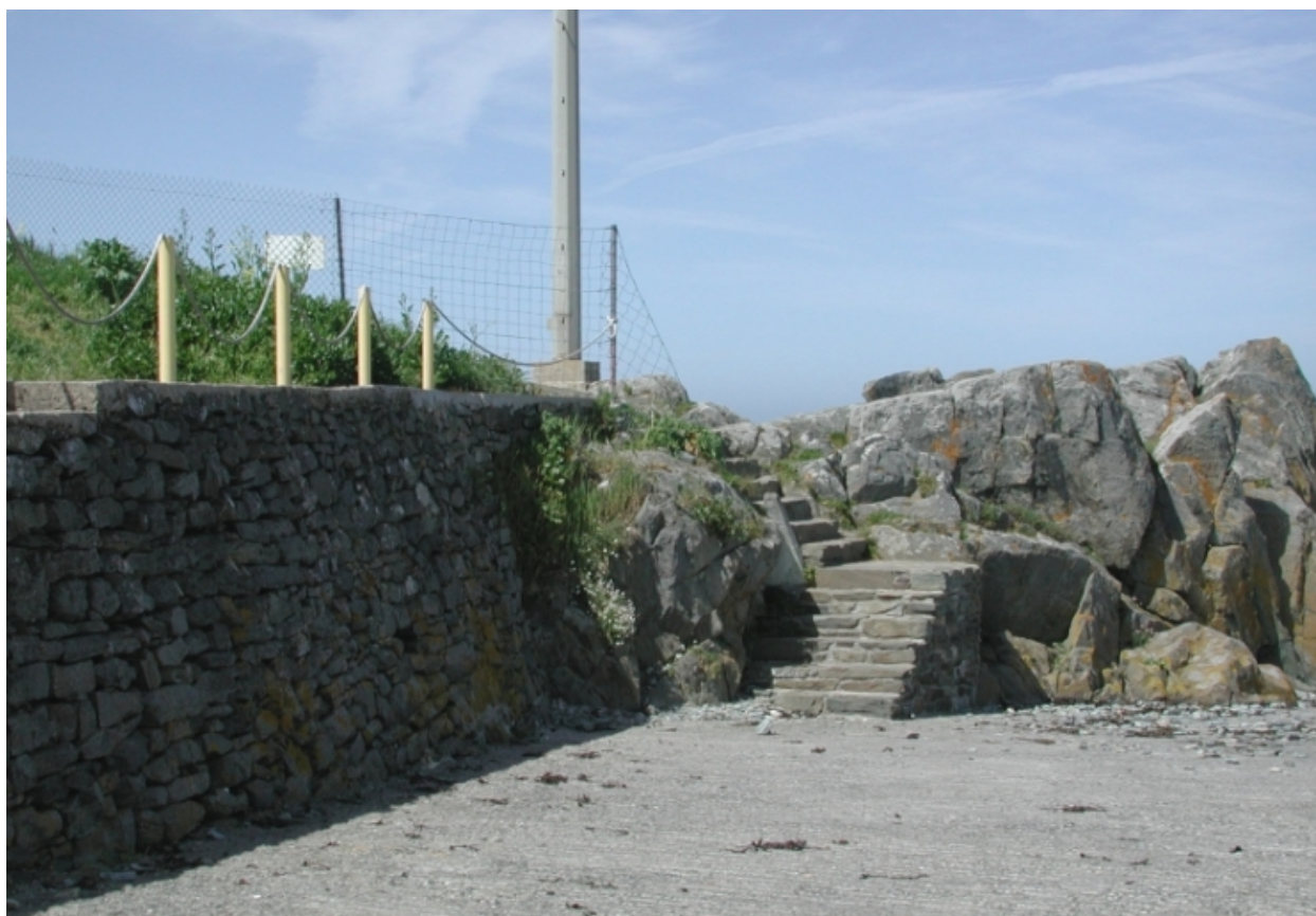
Anciens murs de soutènement et escalier en pierres près de la petite cale de Locquémeau
