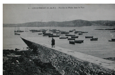
La cale rallongée avec son parement en pierres et une certaine pente Repro. Guy Prigent, Autr. Nederlein IVR53_20042204640NUCB
