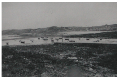
Le port à marée basse avec à gauche la grande cale vers 1954 Phot. Guy Prigent , Autr. Yves Audern IVR53_20042204434NUC
