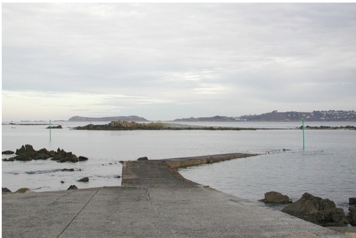
La petite cale (cale d'en bas) à marée haute
