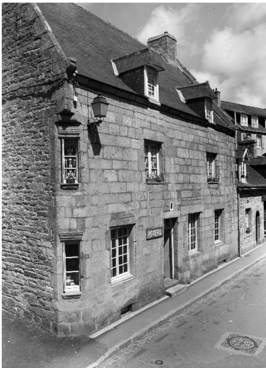
Elévation sud, vue générale
