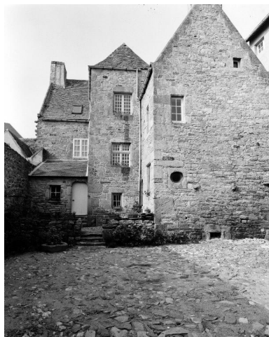
Elévation nord, cour, vue générale prise à partir du bâtiment de la cour Phot. Guy Artur, Phot. Norbert Lambart IVR53_19852901094X
