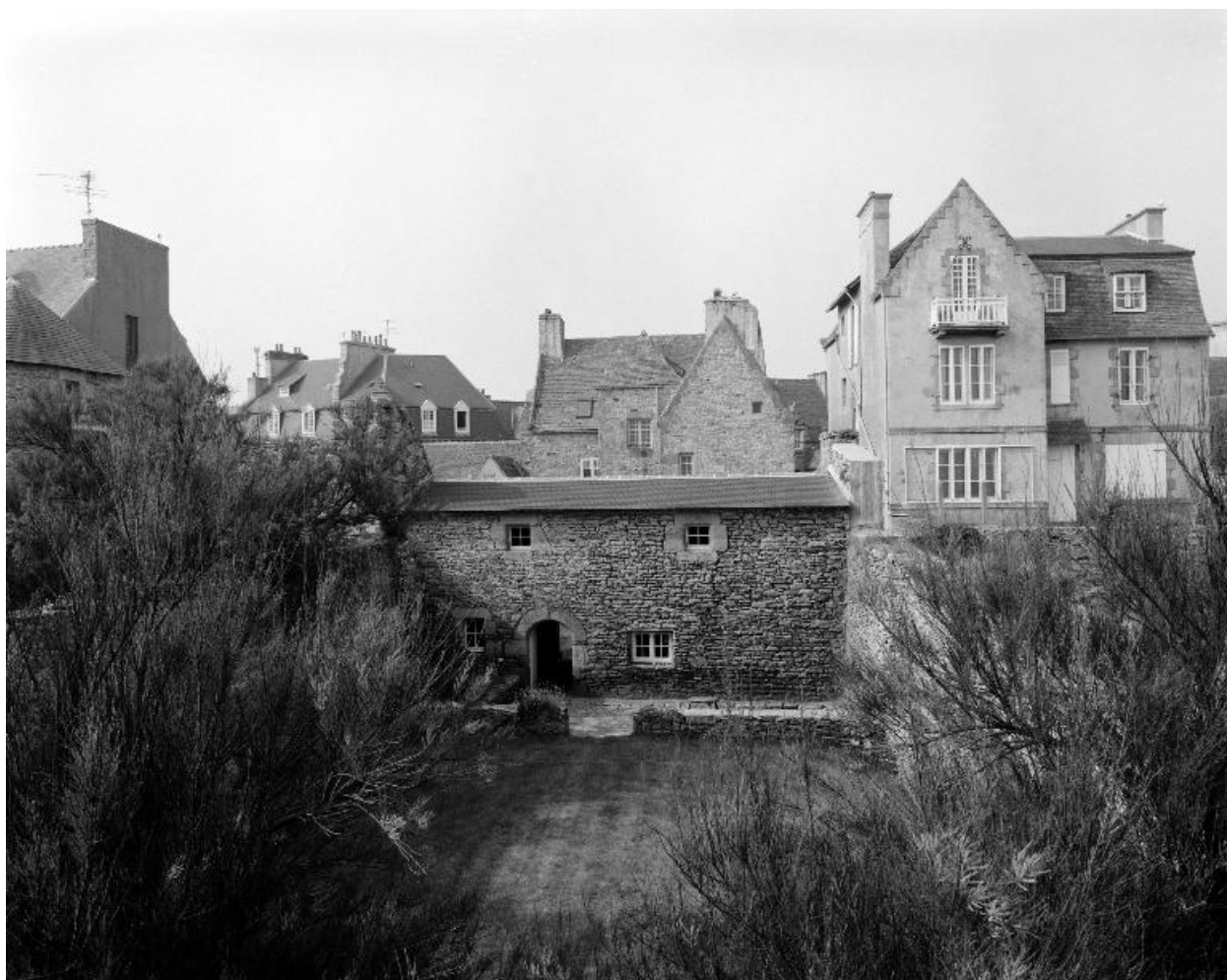
Bâtiment annexe, vue générale nord prise du fond du jardin
