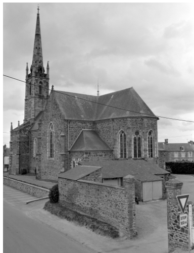
Elévation Sud-Ouest : vue générale Phot. Guy Artur, Phot. Norbert Lambart IVR53_19943501291X
