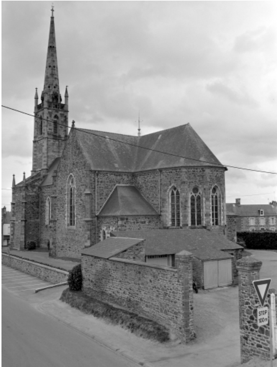
Elévation Sud-Ouest : vue générale
