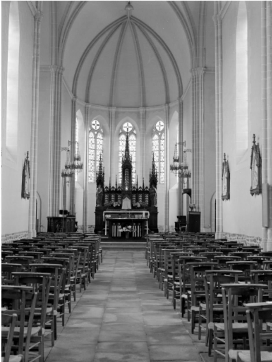
Intérieur : vue générale vers le chœur.
