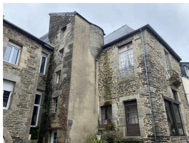
Élévation nord Phot. Baptiste Oligo IVR53_20265610184NUCA
