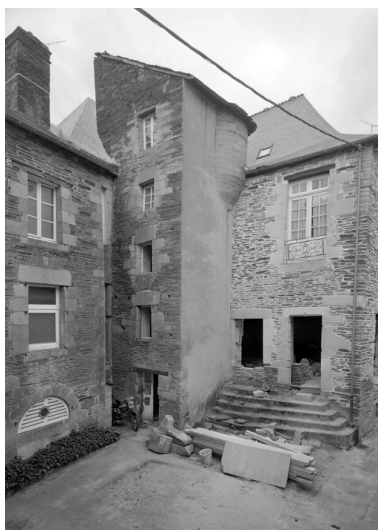
Maison : élévation nord (état en 1985) Phot. Norbert Lambart IVR53_19855600813V
