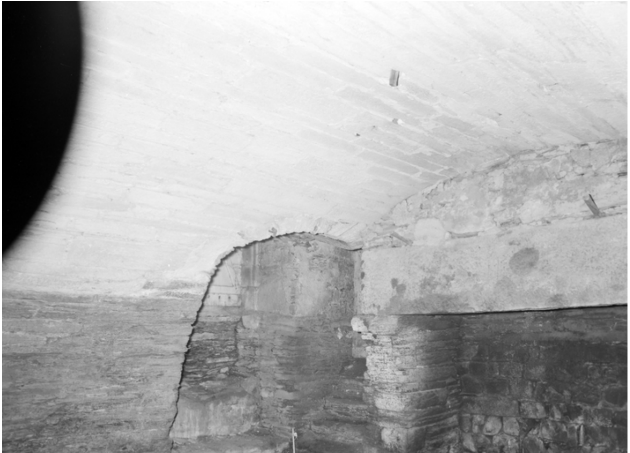
Maison : voûte du sous-sol (état en 1985)
