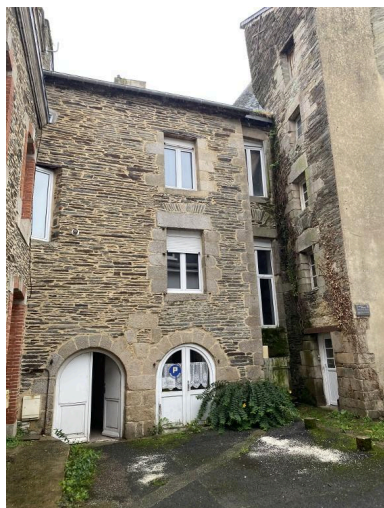
Élévation ouest Phot. Baptiste Oligo IVR53_20265610183NUCA
