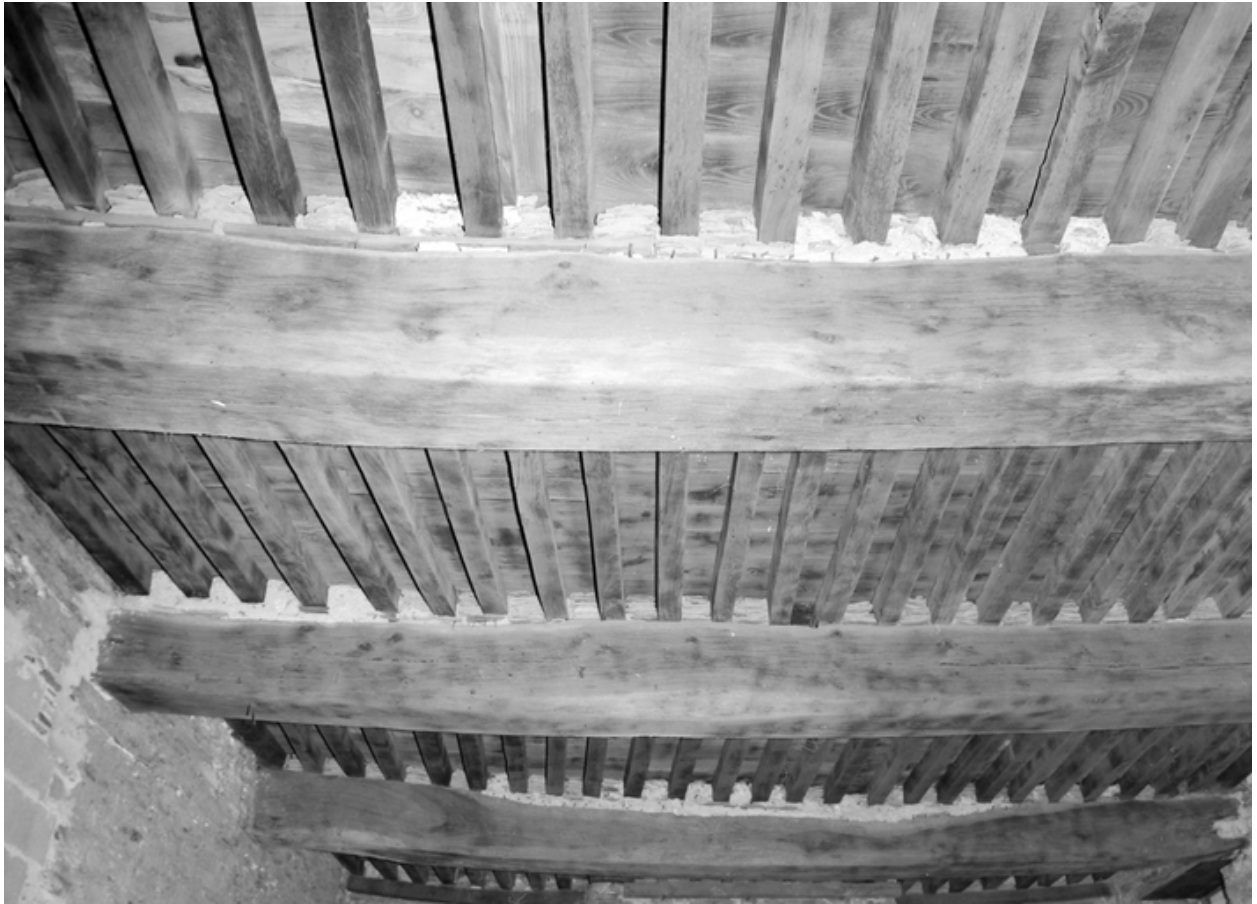
Maison : le plafond de la salle du rez-de-chaussée (état en 1985)
