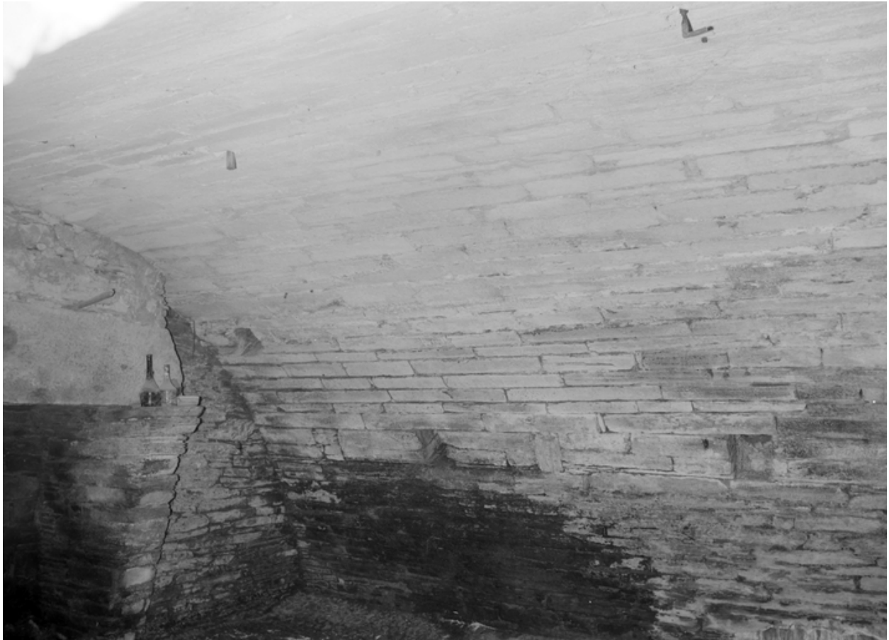
Maison : voûte du sous-sol (état en 1985)
