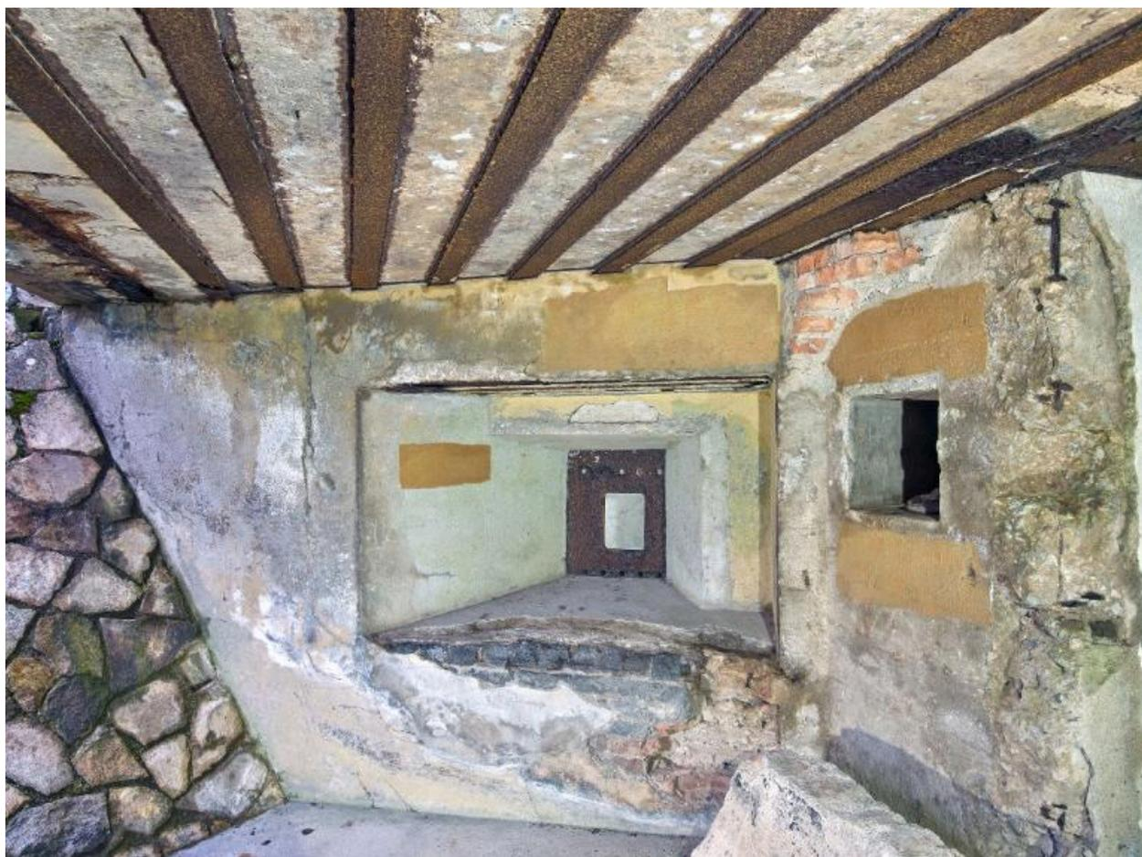
Vue du créneau blindé de défense de l'entrée depuis l'extérieur. A droite, prise d'air (dépourvu de grille de protection et de tuyau) de la salle des ventilateurs. Les murs étaient doublés de brique
