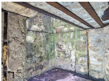
Vue du puits d'antenne nord-est. Les murs étaient dotés de tasseaux posés à intervalle régulier pour la fixation des câbles. Le béton laisse apparaître gravillons, galets entiers et ferrailage
