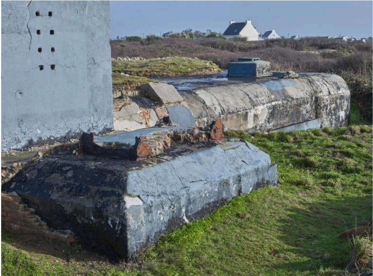
Vue depuis le sud-ouest : vestiges de l'un des quatre mâts d'antenne. A gauche, puits sud-ouest pour câble d'antenne avec ses passages de câble (8 de ce côté)
