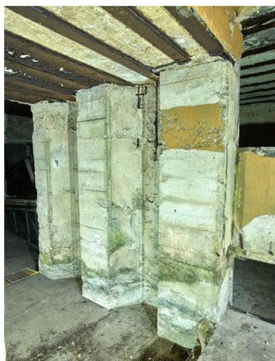
Vue de l'entrée de la salle des machines (groupe électrogène) depuis l'extérieur. Elle était prévue pour être condamnée par des poutres métalliques après installation des équipements
