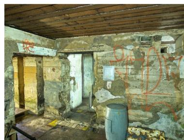
Vue de la salle des machines (groupe électrogène). A gauche : entrée pour le matériel ; au centre, accès vers le couloir d'entrée. Cette partie du bunker n'est pas étanche aux attaques de gaz
