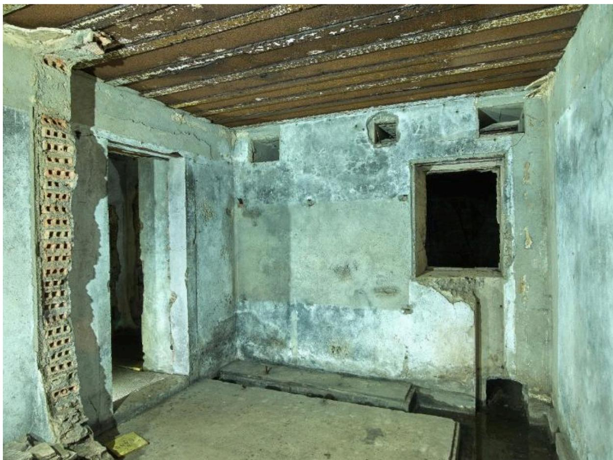
Vue de la salle des ventilateurs. Une cloison en brique creuse, percée d'une porte, subsiste à l'état de vestiges. A gauche, porte donnant sur le sas étanche. Sur le mur, traces d'un équipement
