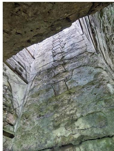
Vue du puits d'antenne nord-est avec ses échelons. Les murs étaient dotés de tasseaux posés à intervalle régulier pour la fixation des câbles
