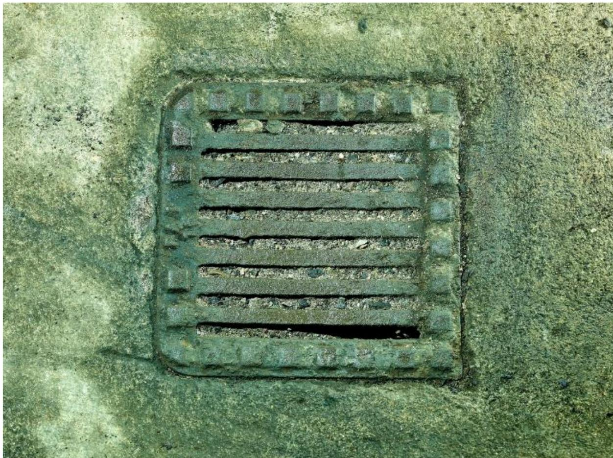
Vue de la salle des ventilateurs, grille de l'exutoire aménagé dans le sol pour le nettoyage
