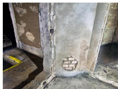
Vue du passage des câbles de la salle des compensateurs au puits d'antenne sud-ouest via un sas étanche. Ils sont photographiés depuis le sas doublé en brique montée au ciment. Les portes ont disparu
