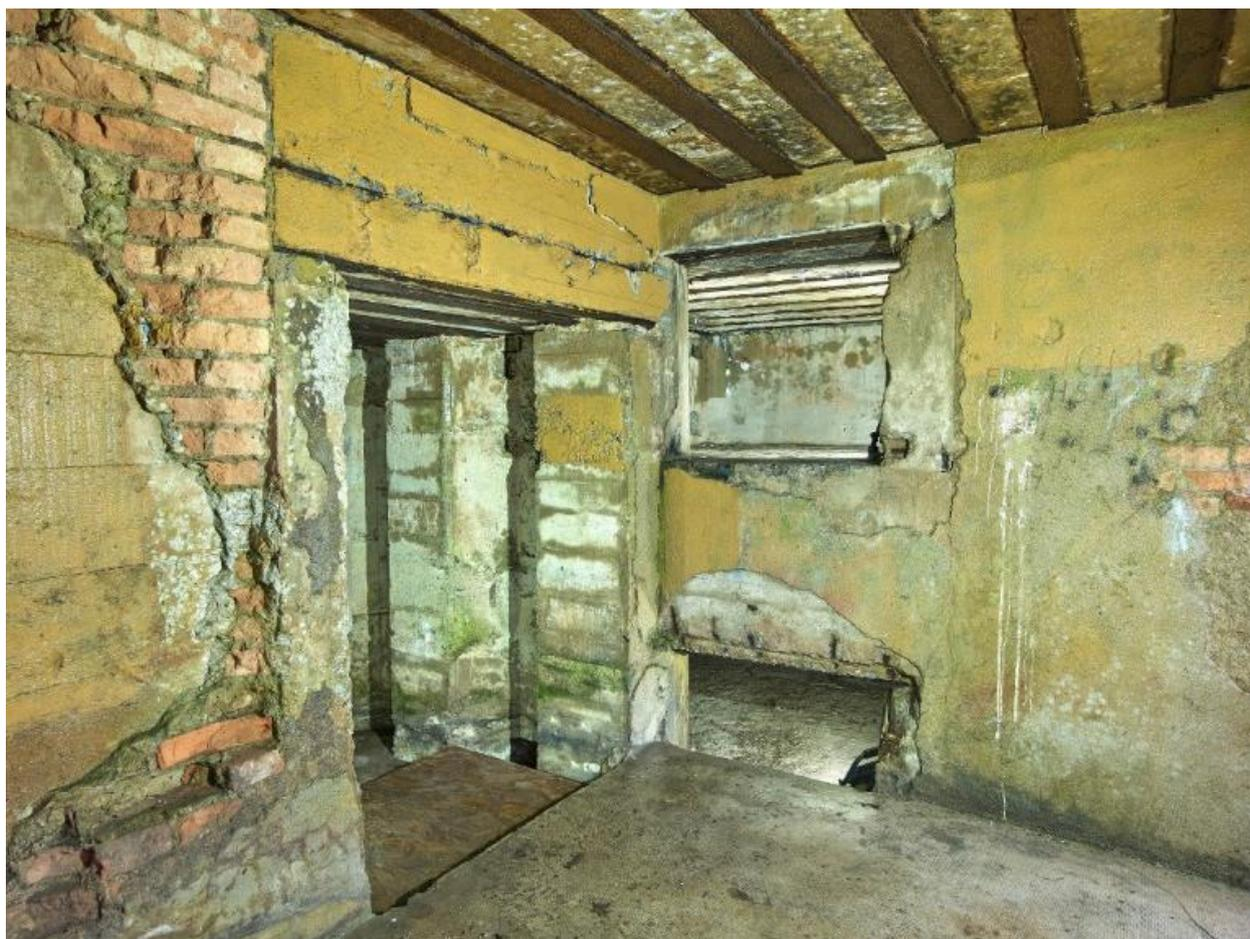
Vue de l'entrée vers la salle des machines (groupe électrogène) depuis l'extérieur. Au centre : prise d'air et emplacement du refroidisseur. Les murs du bunker sont doublés en brique
