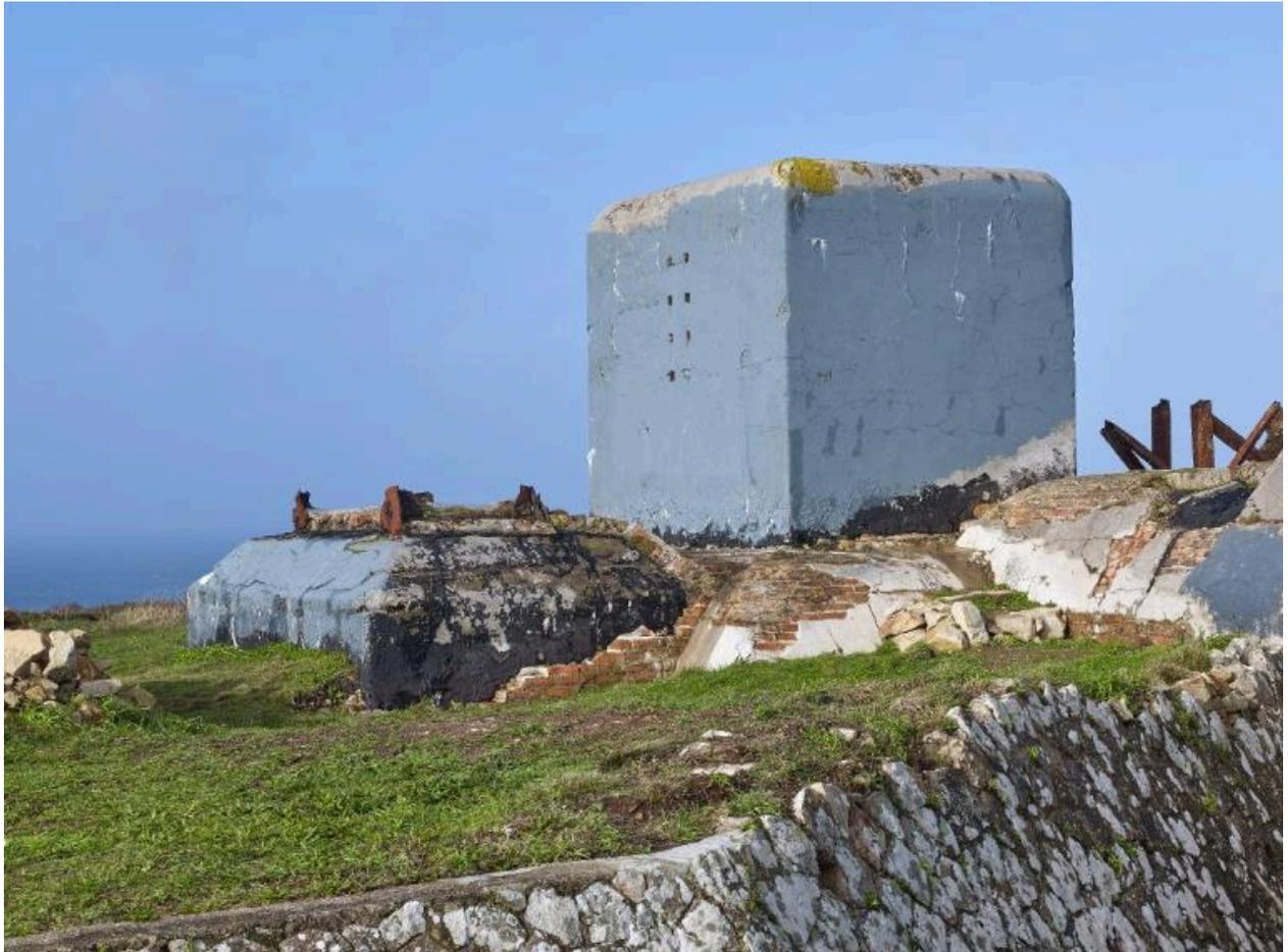
Vue depuis le sud : puits sud-ouest pour câble d'antenne et vestiges de deux des quatre mâts d'antenne. Le bunker est doublé en brique
