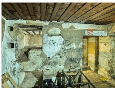
Vue de la salle des machines (groupe électrogène). A gauche : prise d'air et emplacement du refroidisseur ; à droite, entrée pour le matériel. Cette partie du bunker n'est pas étanche aux attaques de gaz
