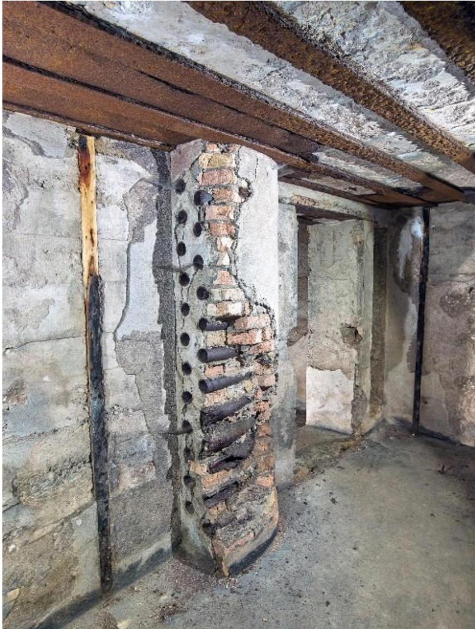
Vue du passage des câbles de la salle des compensateurs au puits d'antenne nord-est via un sas étanche. Ils sont photographiés depuis le puits. Les murs sont dotés de tasseaux posés à intervalle régulier
