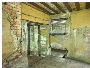
Vue de l'entrée vers la salle des machines (groupe électrogène) depuis l'extérieur. Au centre : prise d'air et emplacement du refroidisseur. Les murs du bunker sont doublés en brique
