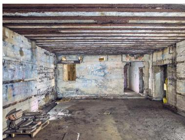
Vue de la salle d'exploitation depuis le sud-ouest. Au fond : à gauche, ouverture donnant sur la salle des ventilateurs ; à droite, vers le sas étanche ; encore à droite, vers la salle du groupe électrogène de secours
