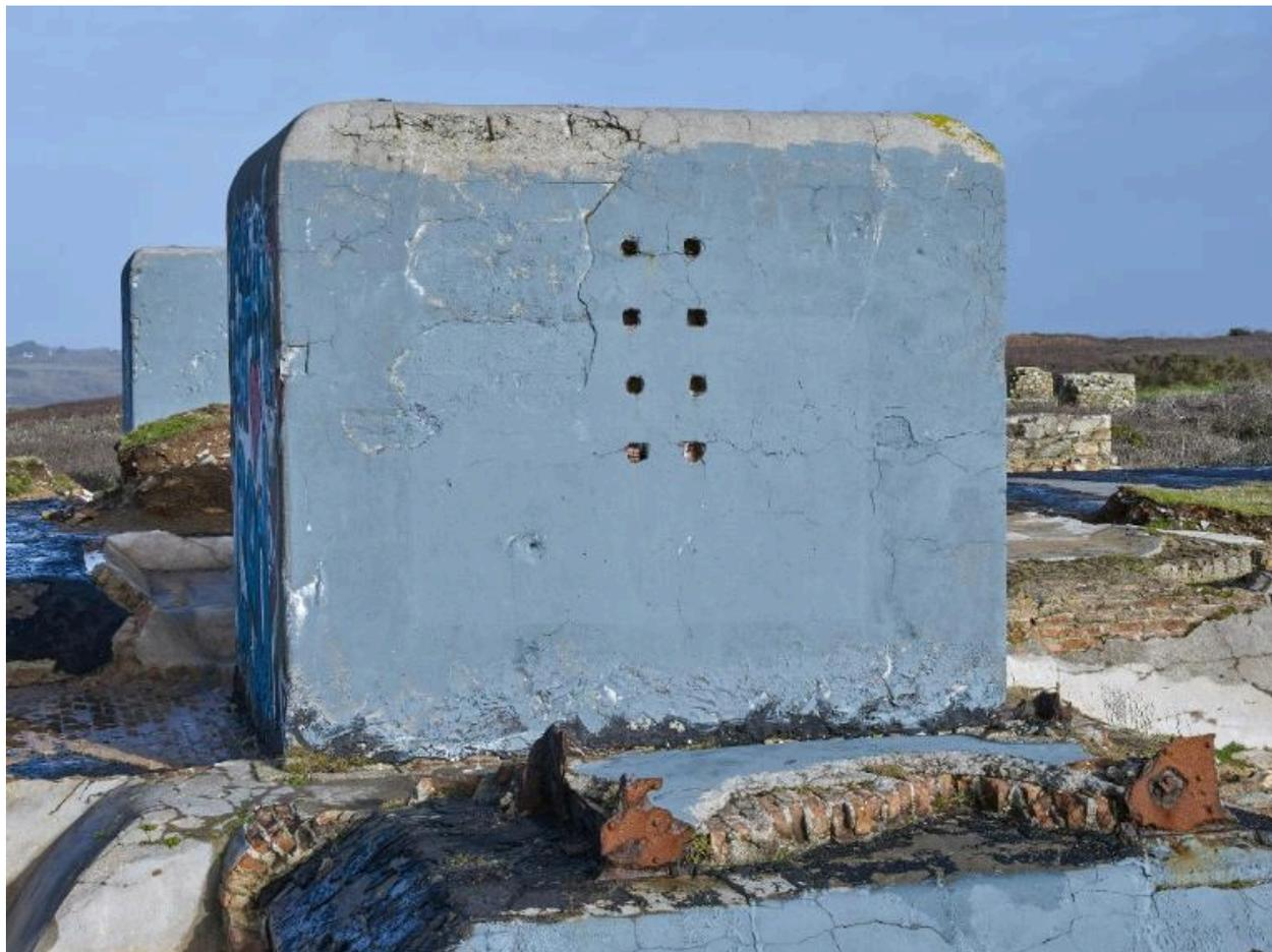
Vue depuis le sud-ouest : puits sud-ouest pour câble d'antenne avec ses passages de câble (8 de ce côté). Au premier plan, les vestiges de l'un des quatre mâts d'antenne. Le bunker est doublé en brique
