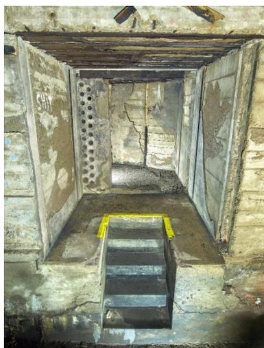
Vue du passage des câbles de la salle des compensateurs au puits d'antenne sud-ouest via un sas étanche. Au premier plan, gaine technique de la salle des compensateurs accessible par un escalier
