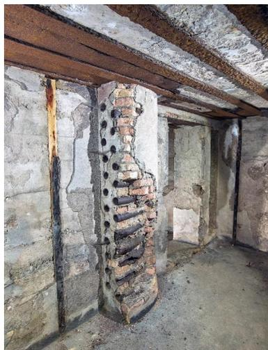
Vue du passage des câbles de la salle des compensateurs au puits d'antenne nord-est via un sas étanche. Ils sont photographiés depuis le puits. Les murs sont dotés de tasseaux posés à intervalle régulier
