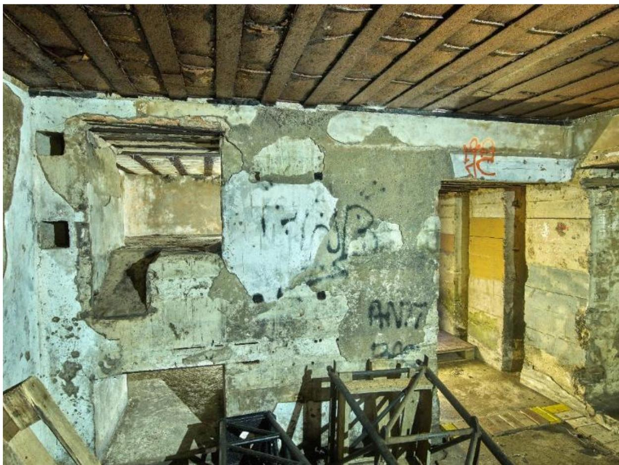
Vue de la salle des machines (groupe électrogène). A gauche : prise d'air et emplacement du refroidisseur ; à droite, entrée pour le matériel. Cette partie du bunker n'est pas étanche aux attaques de gaz
