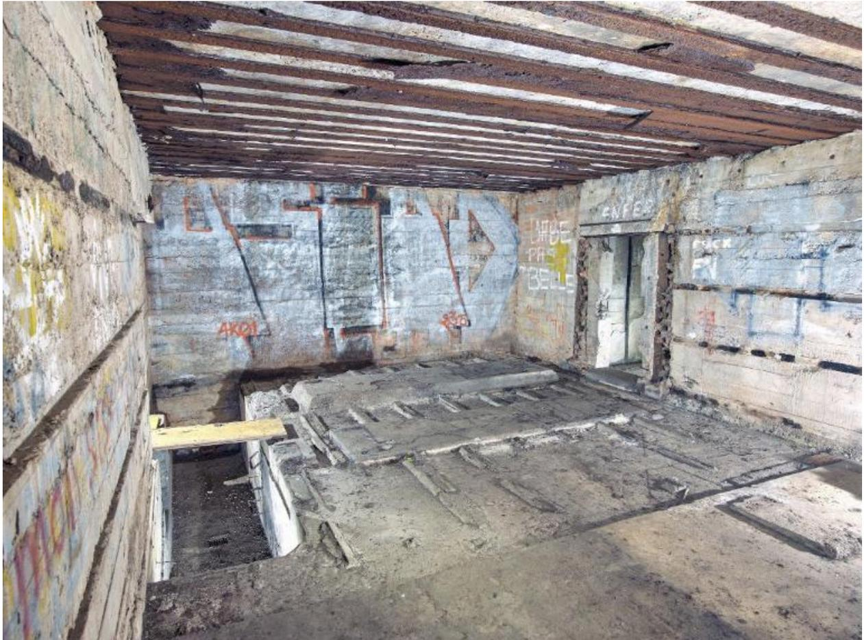
Vue de la salle des compensateurs avec sa gaine technique et ses deux socles. La salle d'exploitation et la salle des compensateurs étaient divisées par une cloison en brique
