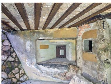
Vue du créneau blindé de défense de l'entrée depuis l'extérieur. A droite, prise d'air (dépourvu de grille de protection et de tuyau) de la salle des ventilateurs. Les murs étaient doublés de brique
