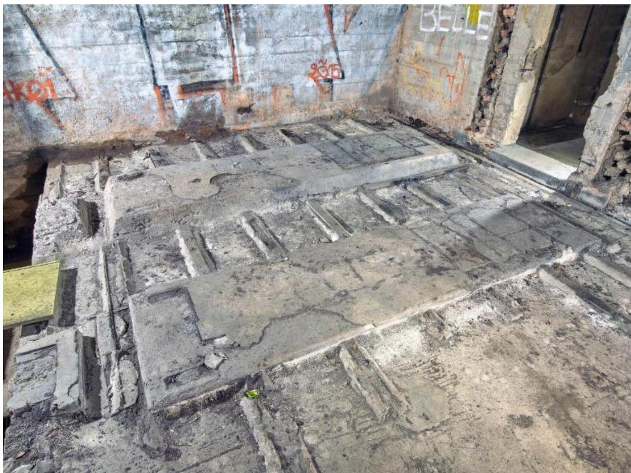
Vue des socles des compensateurs dans la salle homonyme. Des solives permettaient la fixation d'un plancher. A droite, passages de câble vers le puits d'antenne nord-est
