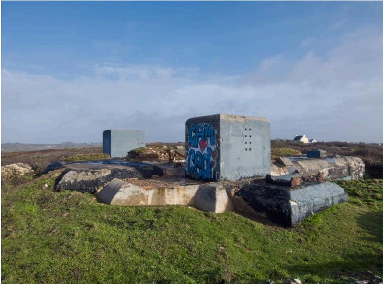
Vue générale depuis le sud-ouest. De la dalle de couverture émergent deux imposants puits pour câble d'antenne et les vestiges des quatre mâts d'antenne. Le bunker est doublé en brique
