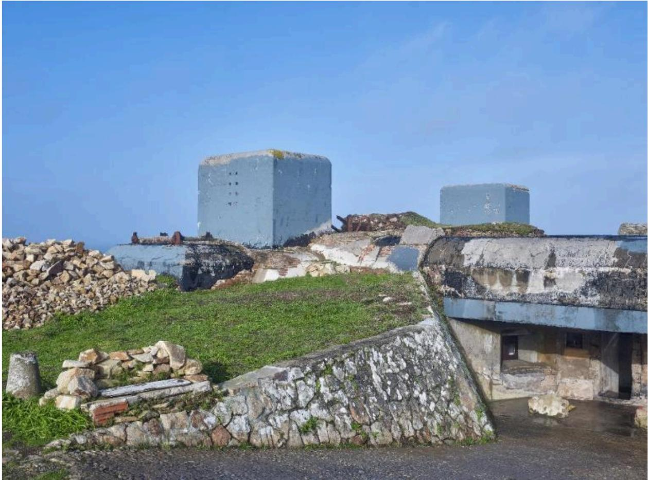
Vue depuis le sud. De la dalle de couverture émergent deux imposants puits pour câble d'antenne et les vestiges des quatre mâts d'antenne. Le mur en glacis de la rampe est en appareillage polygonal
