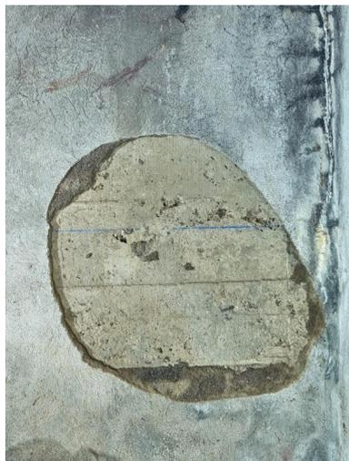
Vue de détail du mur de la salle des ventilateurs. Un enduit au ciment, peint à la chaux, a été réalisé au-dessus du béton brut. Un repère de niveau est tracé en bleu
