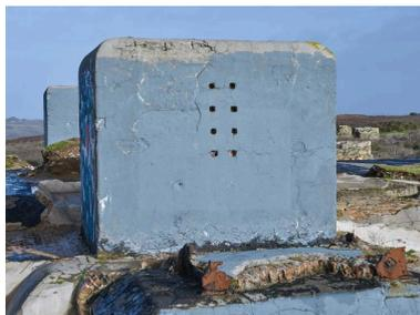
Vue depuis le sud-ouest : puits sud-ouest pour câble d'antenne avec ses passages de câble (8 de ce côté).
