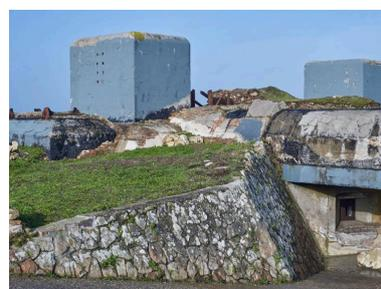
Vue depuis le sud. De la dalle de couverture émergent deux imposants puits pour câble d'antenne. Le mur en glacié de la rampe est en appareillage polygonal. En bas à droite, le créneau blindé
