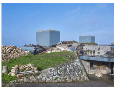
Vue depuis le sud. De la dalle de couverture émergent deux imposants puits pour câble d'antenne et les vestiges des quatre mâts d'antenne. Le mur en glacié de la rampe est en appareillage polygonal
