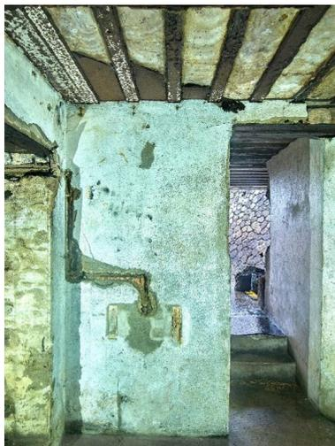
Vue du couloir d'entrée. Sur le mur, traces de l'emplacement d'un lavabo (arrivée et évacuation d'eau ; tasseaux de fixation). Au-dessus, emplacement d'une lampe hublot et arrivée électrique
