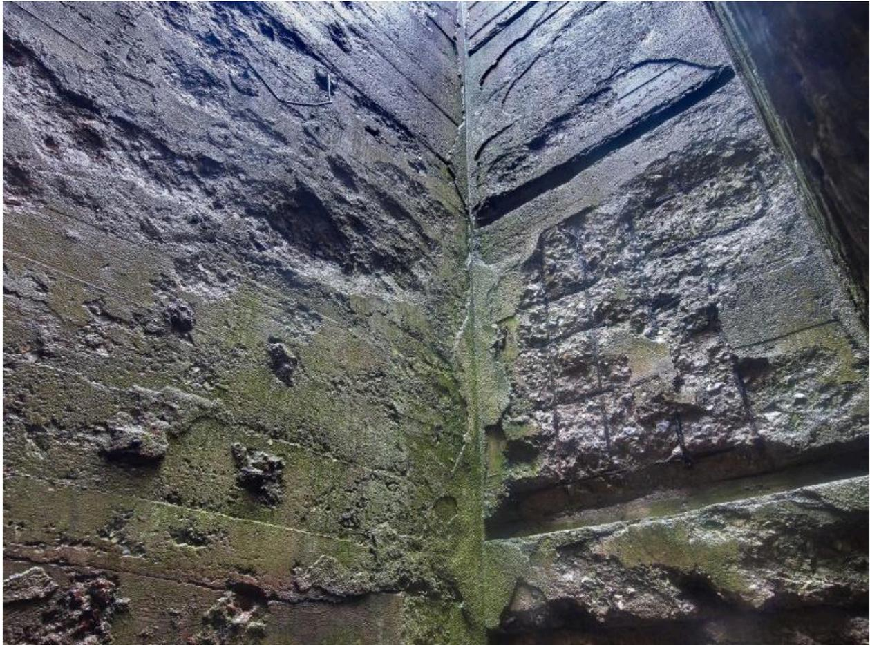
Vue du puits d'antenne sud-ouest. Les murs étaient dotés de tasseaux posés à intervalle régulier pour la fixation des câbles. Le béton laisse apparaître gravillons, galets entiers et ferrailage
