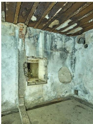
Vue de la salle des ventilateurs, sortie de secours (mur nord-est). Une cloison en brique creuse, percée d'une porte, subsiste à l'état de vestiges
