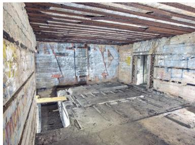
Vue de la salle des compensateurs avec sa gaine technique et ses deux socles. La salle d'exploitation et
