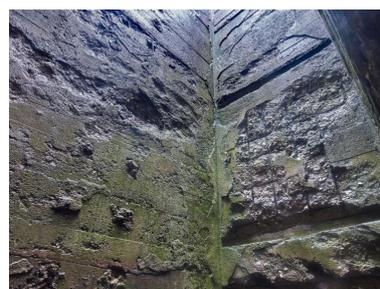
Vue du puits d'antenne sud-ouest. Les murs étaient dotés de tasseaux posés à intervalle régulier pour la fixation des câbles. Le béton laisse apparaître gravillons, galets entiers et ferrailage
