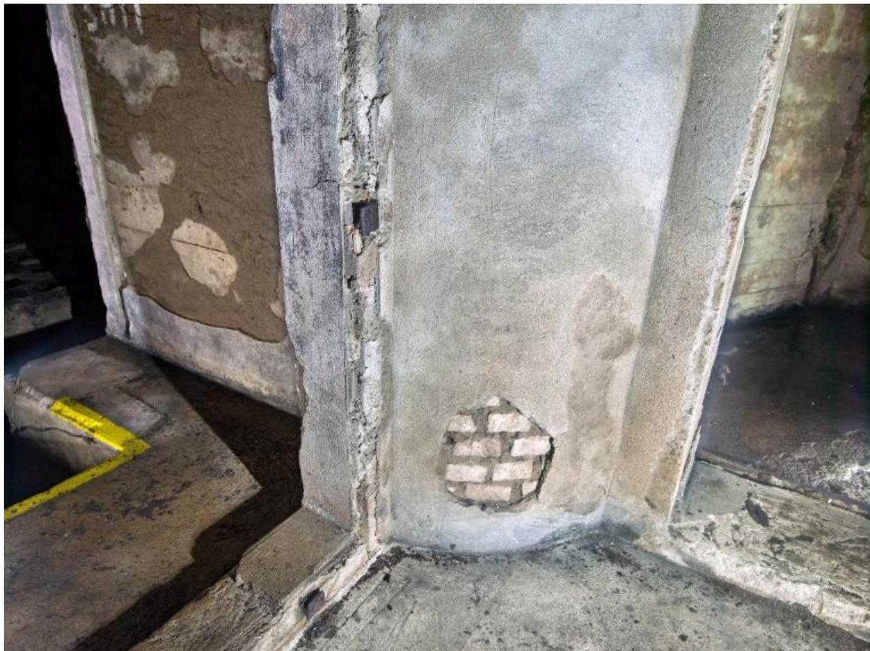
Vue du passage des câbles de la salle des compensateurs au puits d'antenne sud-ouest via un sas étanche. Ils sont photographiés depuis le sas doublé en brique montée au ciment. Les portes ont disparu
