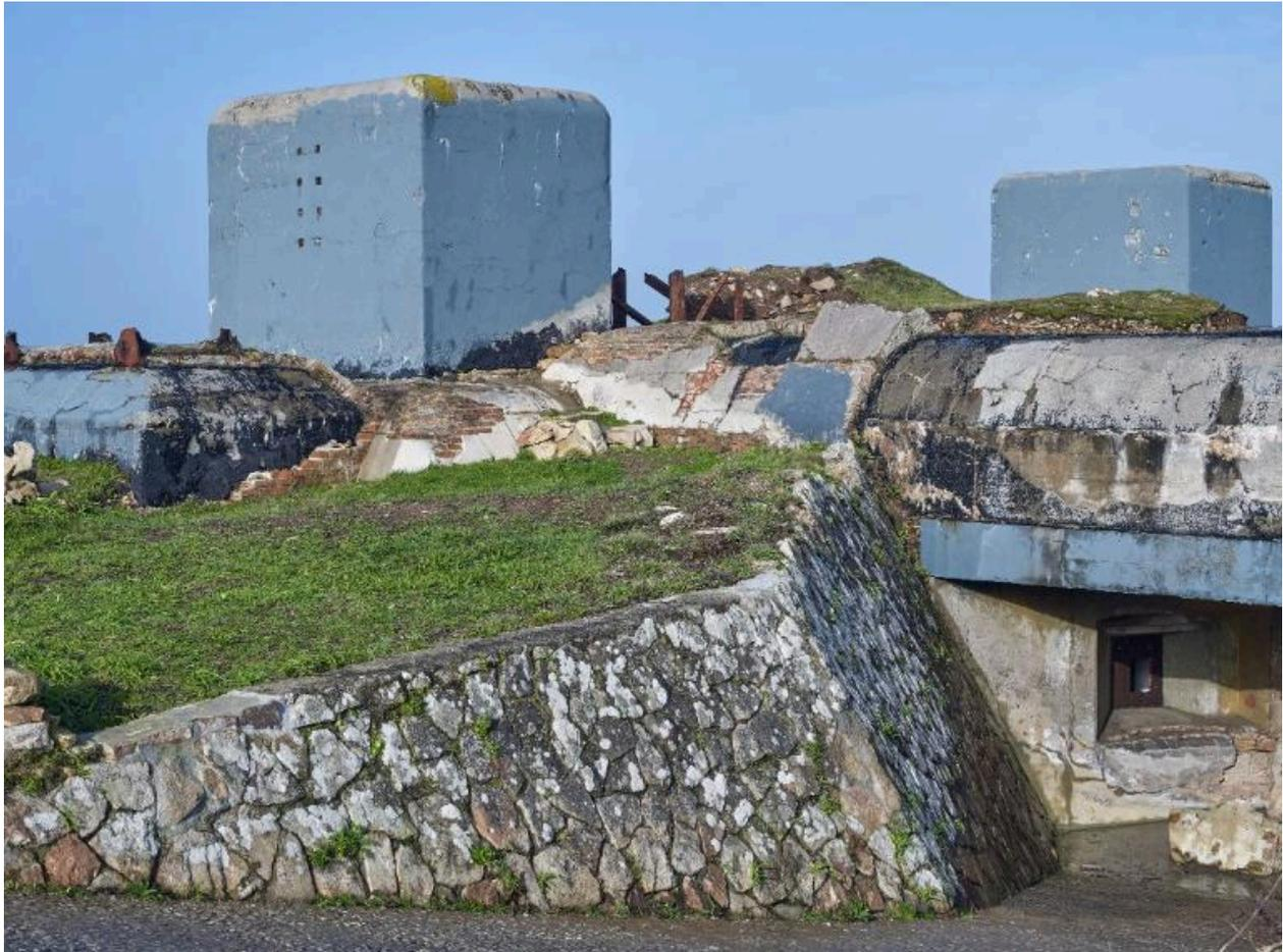
Vue depuis le sud. De la dalle de couverture émergent deux imposants puits pour câble d'antenne. Le mur en glacis de la rampe est en appareillage polygonal. En bas à droite, le créneau blindé
