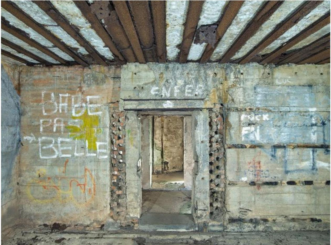
Vue du passage des câbles de la salle des compensateurs au puits d'antenne nord-est via un sas étanche. Ils sont photographiés depuis la salle des compensateurs ; au centre, porte disparue
