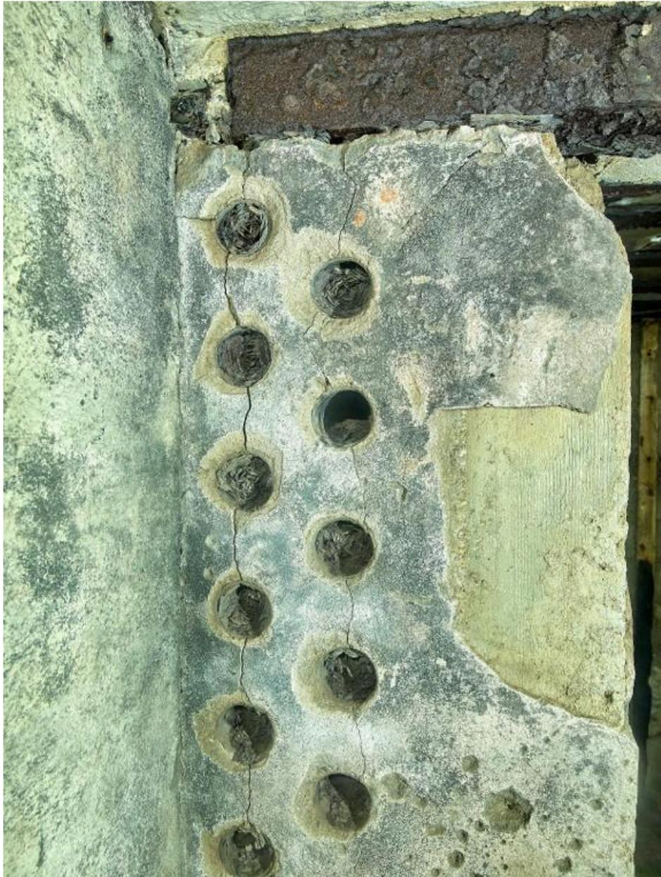
Vue du passage des câbles de la salle des compensateurs au puits d'antenne sud-ouest via un sas étanche
