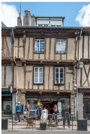
Façade sur rue en pan de bois en encorbellement sur solives. Phot. Charlotte Barraud IVR53_20222900531NUCA
