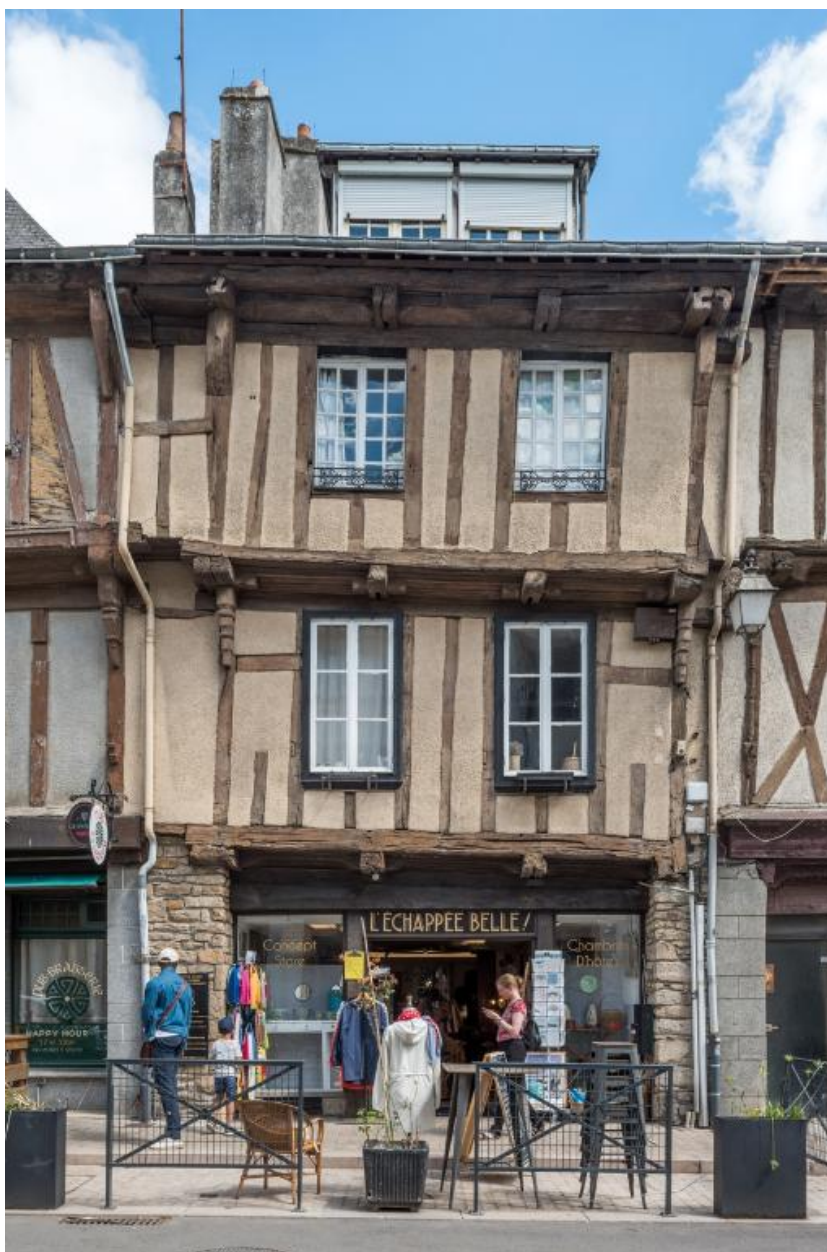
Façade sur rue en pan de bois en encorbellement sur solives.
