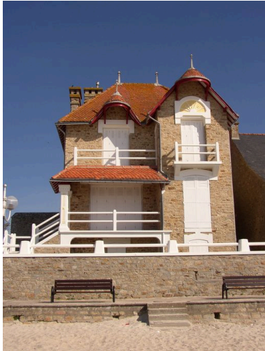
Vue générale de la maison de villégiature anciennement Ker Mat Jeanne Phot. Johan Vincent IVR53_20065606520NUCA
