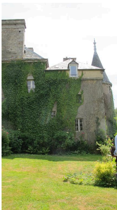
Façade latérale nord et ancien pavillon Phot. Véronique Orain IVR53_20142209770NUCA
