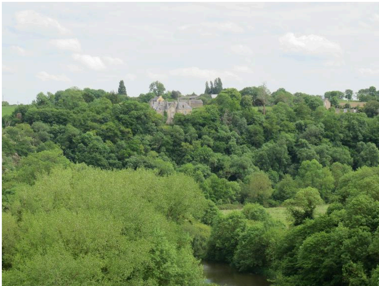
Vue de situation, prise de Taden, façade arrière donnant sur la Rance
