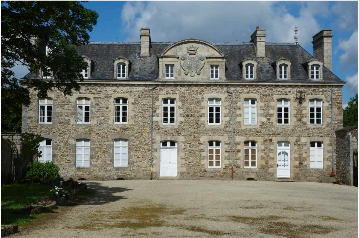
Vue rapprochée de la façade sur cour
