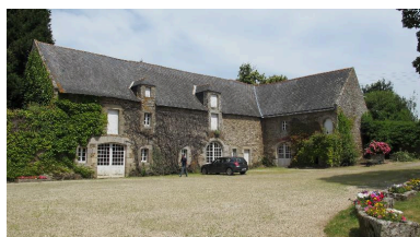
Communs Phot. Véronique Orain IVR53_20142209776NUCA
