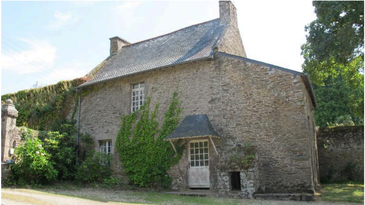
Logis du jardinier à l'entrée de la cour, avec niche pour le chien en pierre
