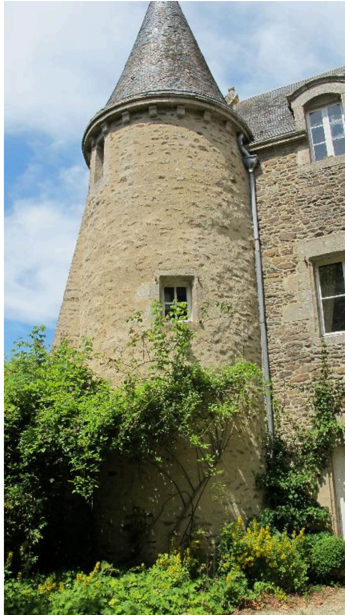
Pavillon originel sur la Rance avec tour d'angle, vue prise de l'ouest
