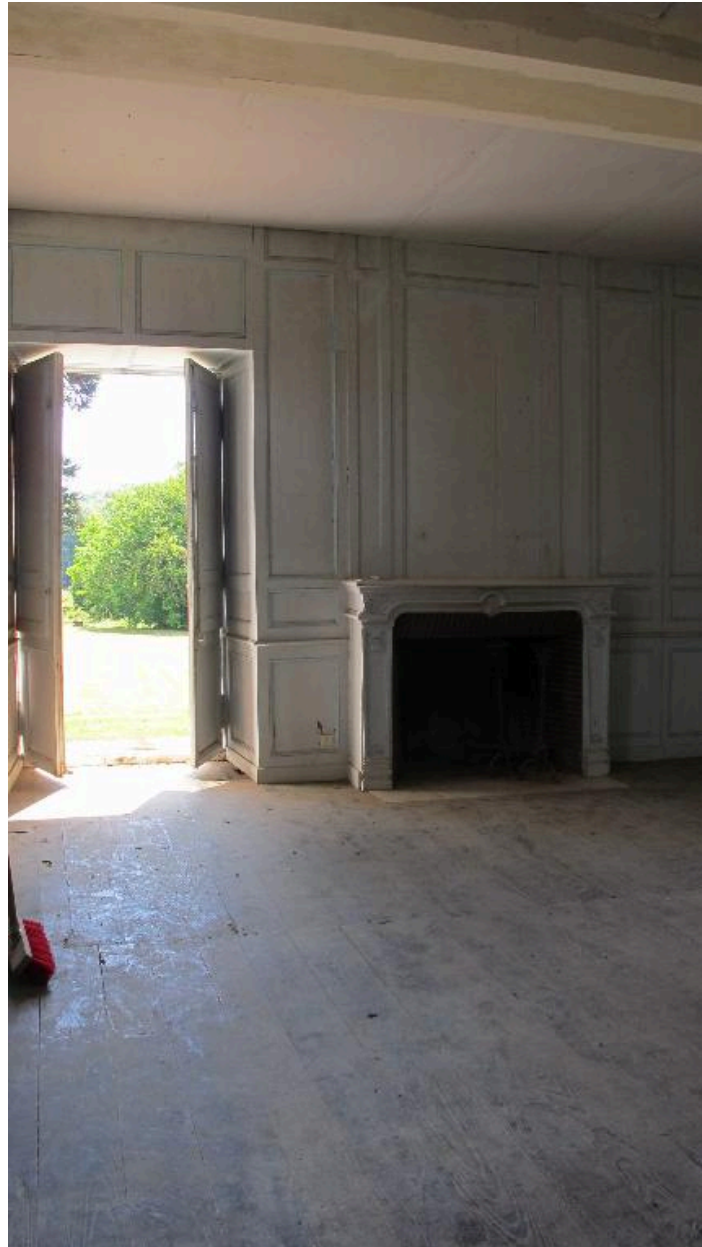
Rez-de-chaussée, salon sud-est, 18e siècle
