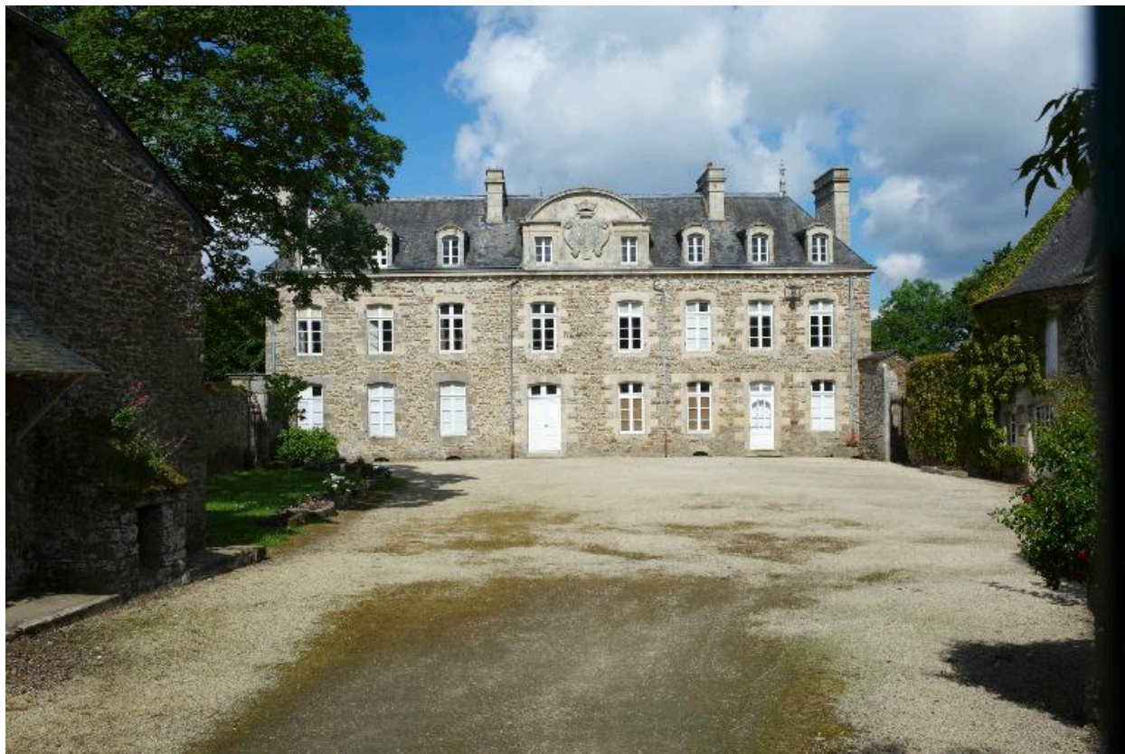
Vue générale, façade sur cour
