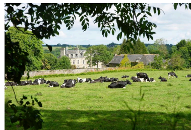
Vue de situation, façade sur cour Phot. Norbert Lambart IVR53_20142201346NUCA
