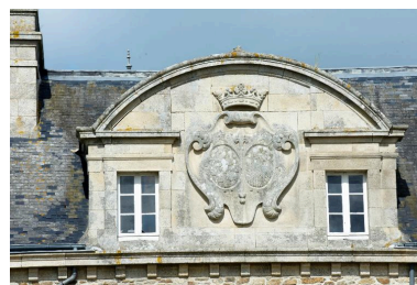
Fronton avec armoires Phot. Norbert Lambart IVR53_20142201344NUCA
